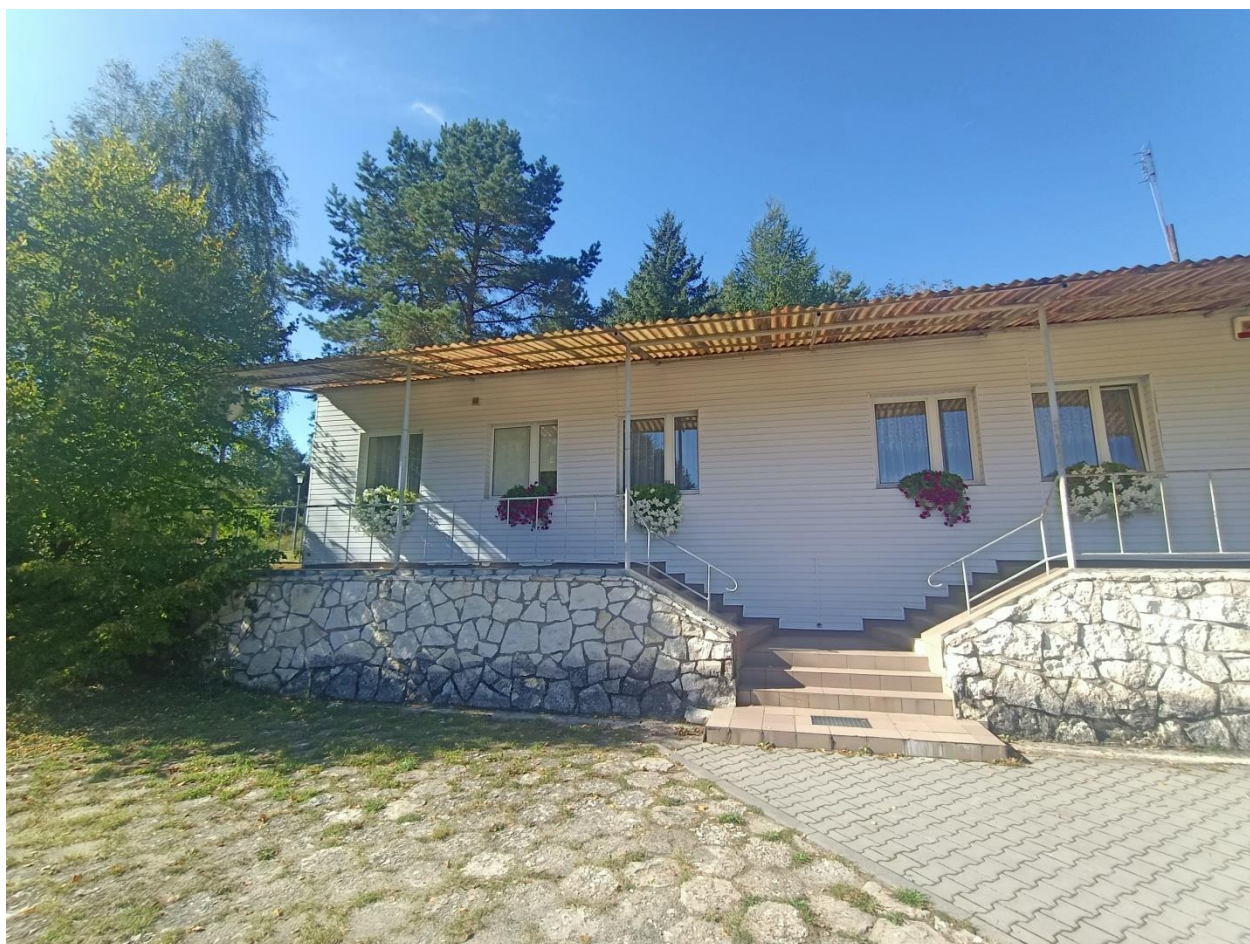
Zdjęcie 10. Elewacja wschodnia (widok fragmentu budynku od strony południowej)
