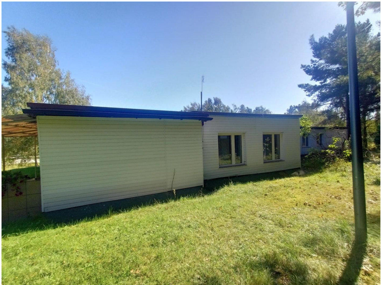
Zdjęcie 4. Elewacja zachodnia (widok fragmentu budynku od strony północnej).
