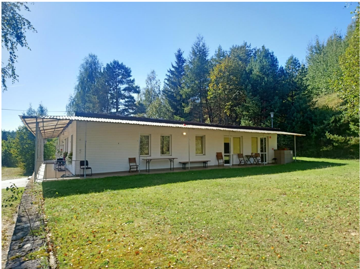
Zdjęcie 3. Elewacja północna.
