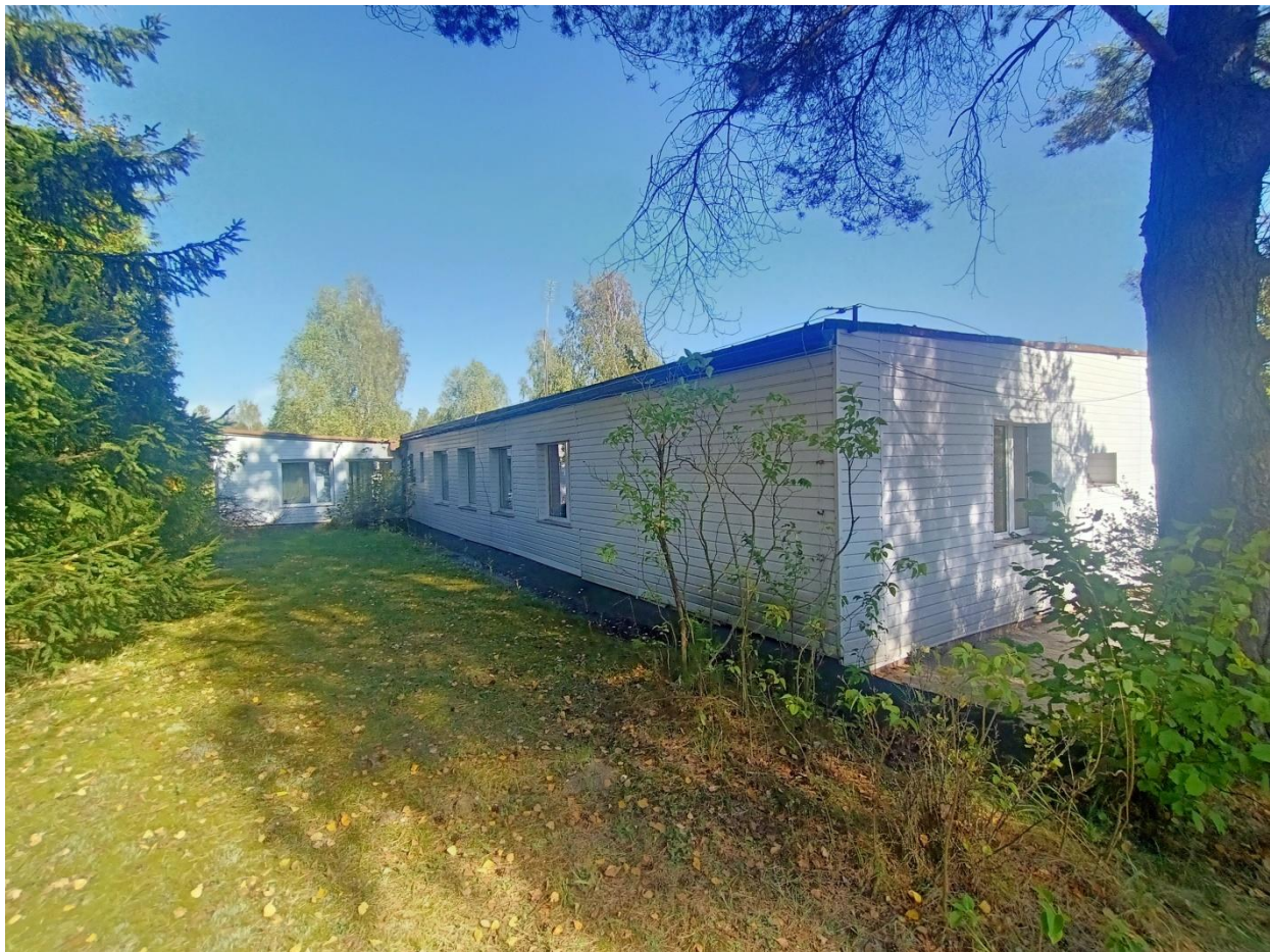
Zdjęcie 6. Elewacja zachodnia (widok fragmentu budynku od strony południowej).
