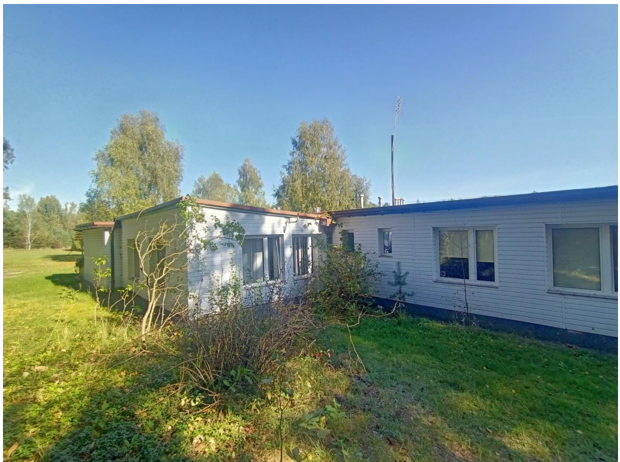
Zdjęcie 5. Elewacja zachodnia („część środkowa”).
