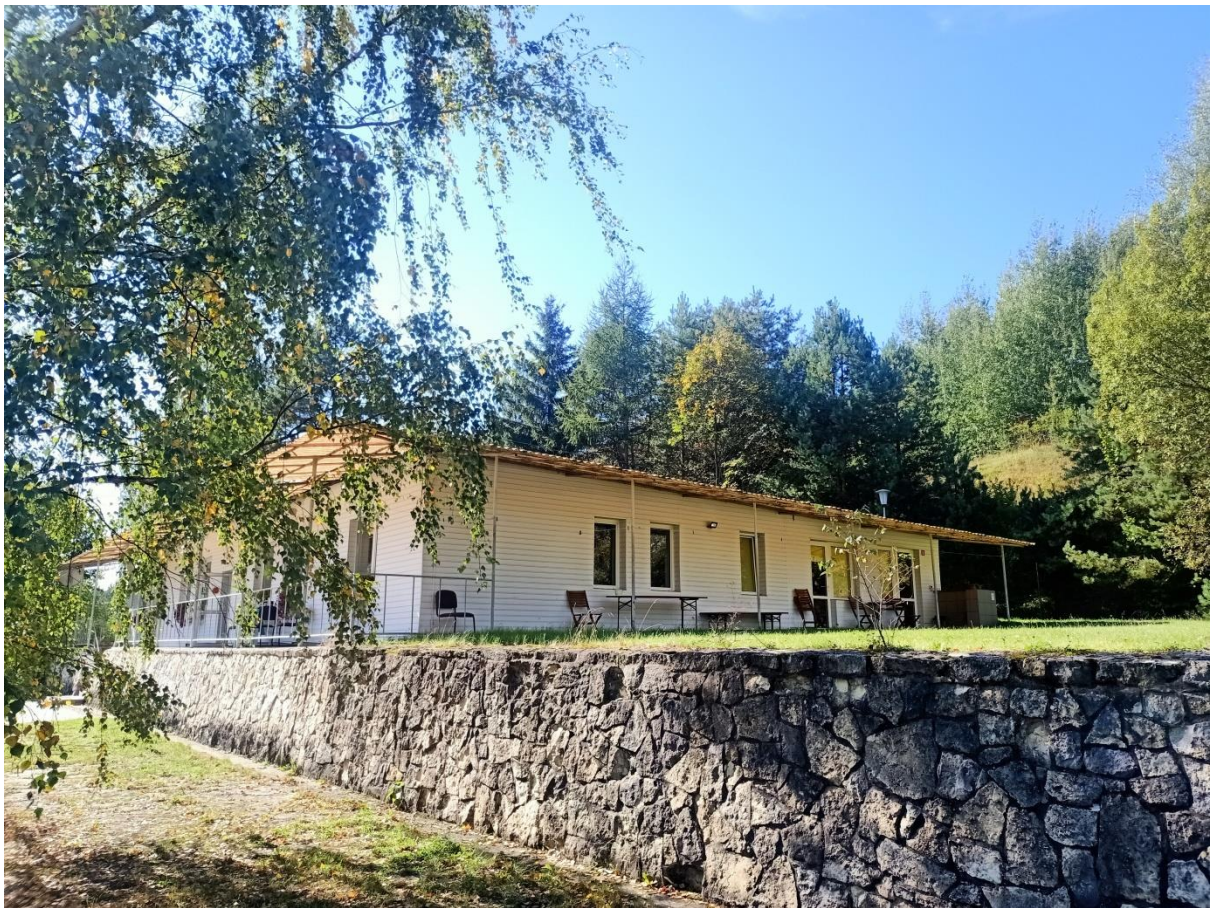
Zdjęcie 2. Elewacja północna.
