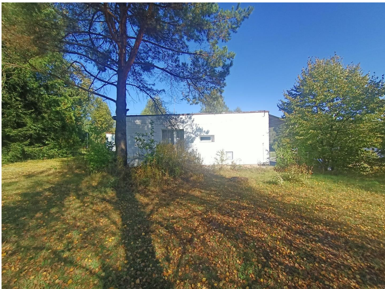
Zdjęcie 7. Elewacja południowa.
