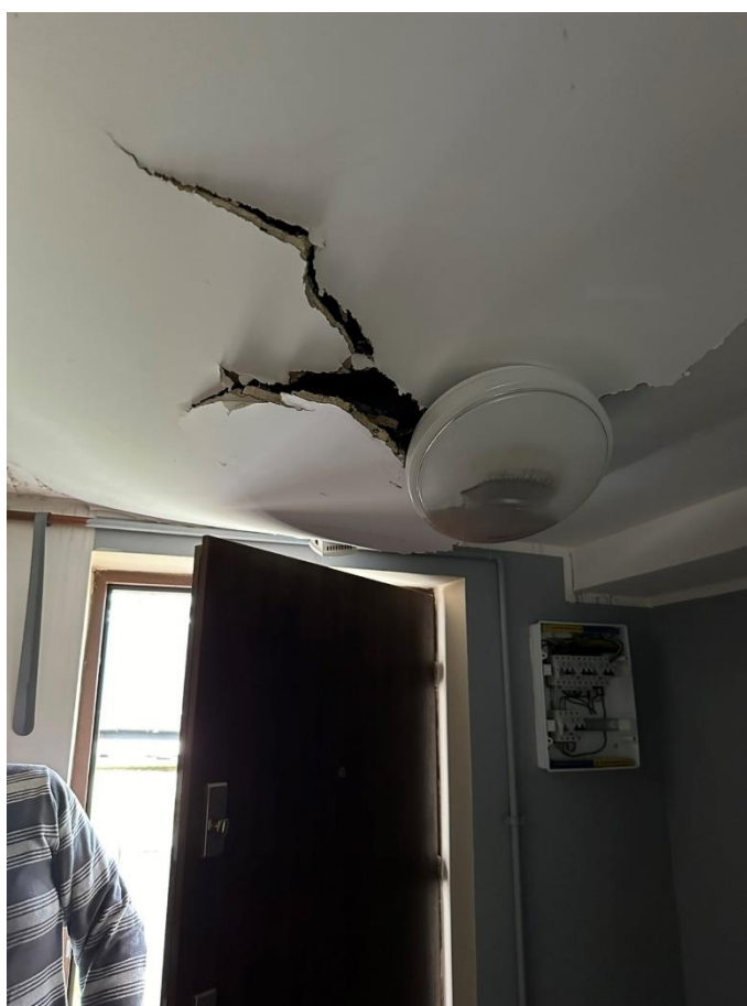
Foto 8. Widok stanu technicznego pomieszczeń poszczególnych lokali mieszkalnych na parterze;
