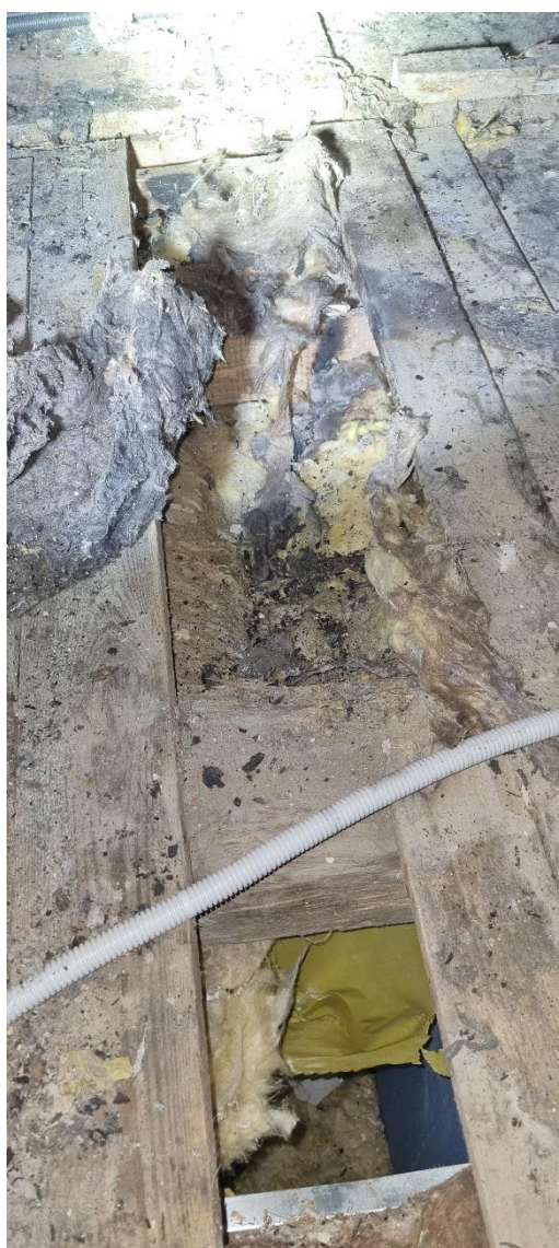
Foto 40. Widok stanu technicznego elementów stropu poddasza nie uszkodzonych przez pożar;
