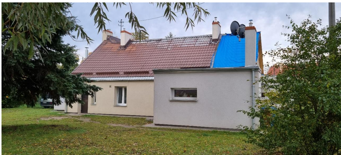
Foto 4. Widok elewacji wschodniej istniejącego budynku mieszkalnego wielorodzinnego;
