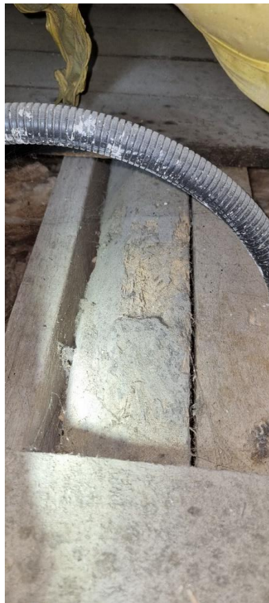
Foto 54. Widok stanu technicznego elementów stropu poddasza nie uszkodzonych przez pożar;
