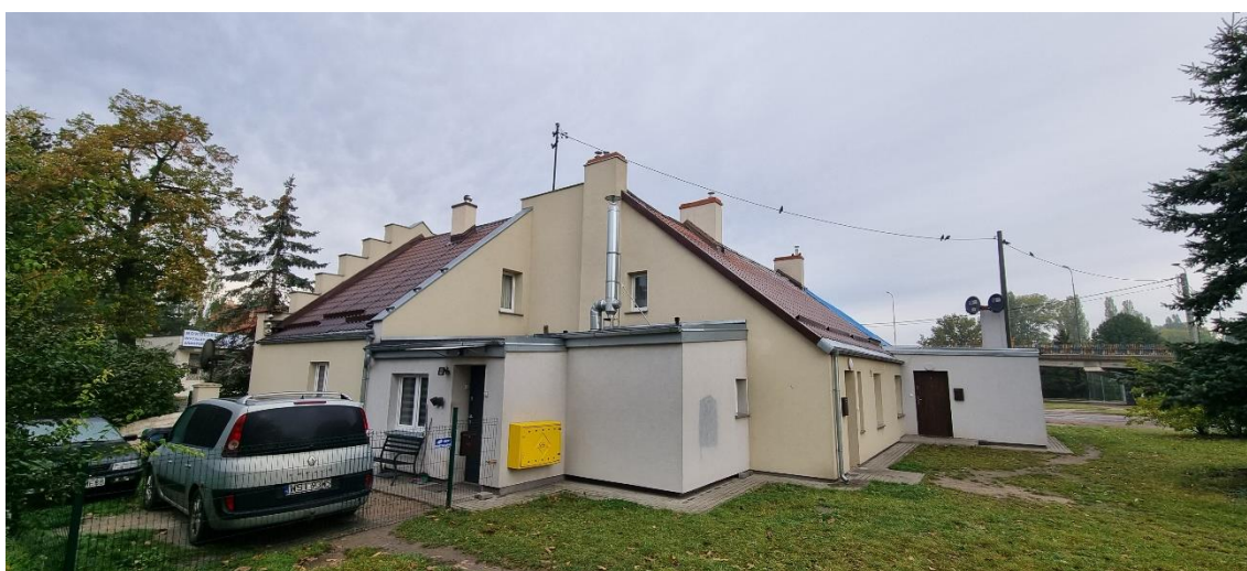
Foto 5. Widok elewacji wschodniej istniejącego budynku mieszkalnego wielorodzinnego;
