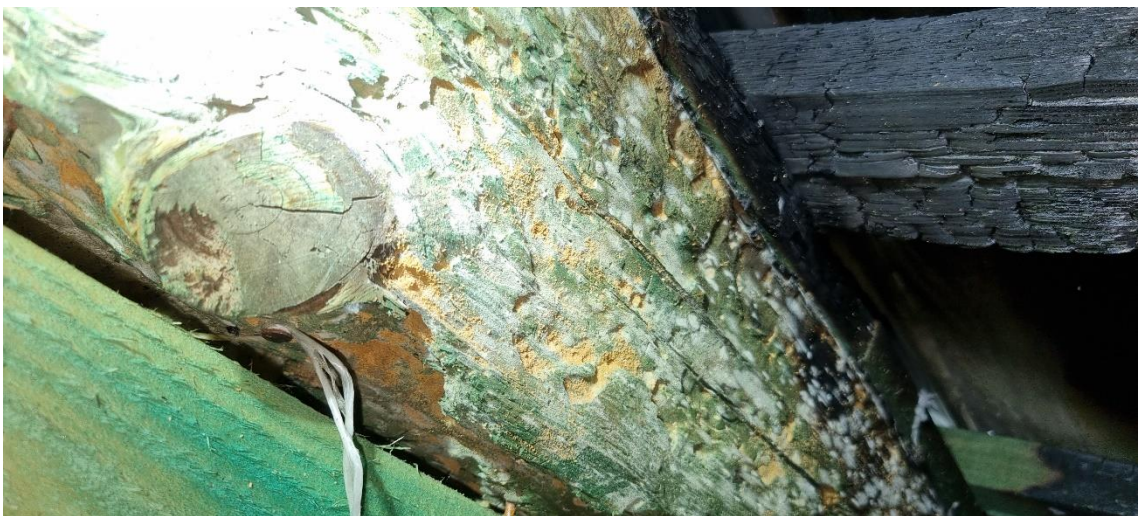
Foto 46. Widok stanu technicznego elementów więźby dachowej nie uszkodzonych przez pożar;
