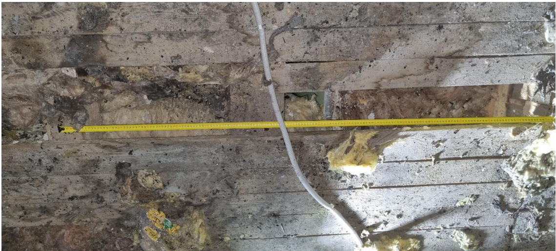
Foto 51. Widok stanu technicznego elementów stropu poddasza nie uszkodzonych przez pożar;
