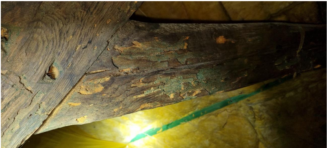
Foto 45. Widok stanu technicznego elementów więźby dachowej nie uszkodzonych przez pożar;
