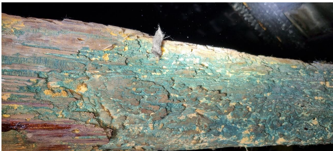
Foto 39. Widok stanu technicznego elementów więźby dachowej nie uszkodzonych przez pożar;
