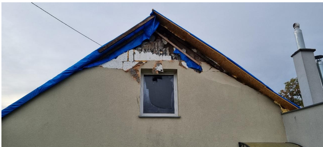
Foto 7. Widok elewacji północnej istniejącego budynku mieszkalnego wielorodzinnego;
