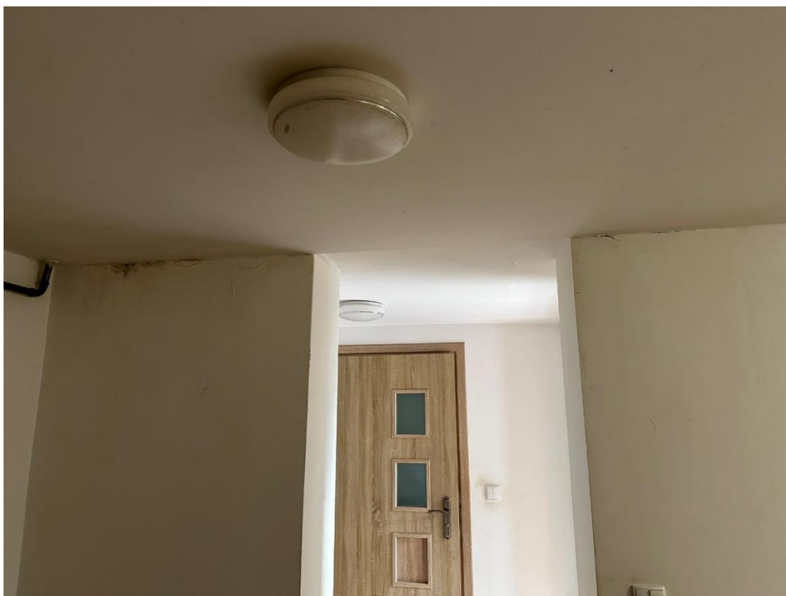
Foto 12. Widok stanu technicznego pomieszczeń poszczególnych lokali mieszkalnych na parterze;
