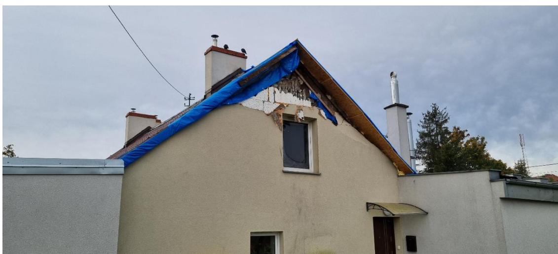
Foto 6. Widok elewacji północnej istniejącego budynku mieszkalnego wielorodzinnego;
