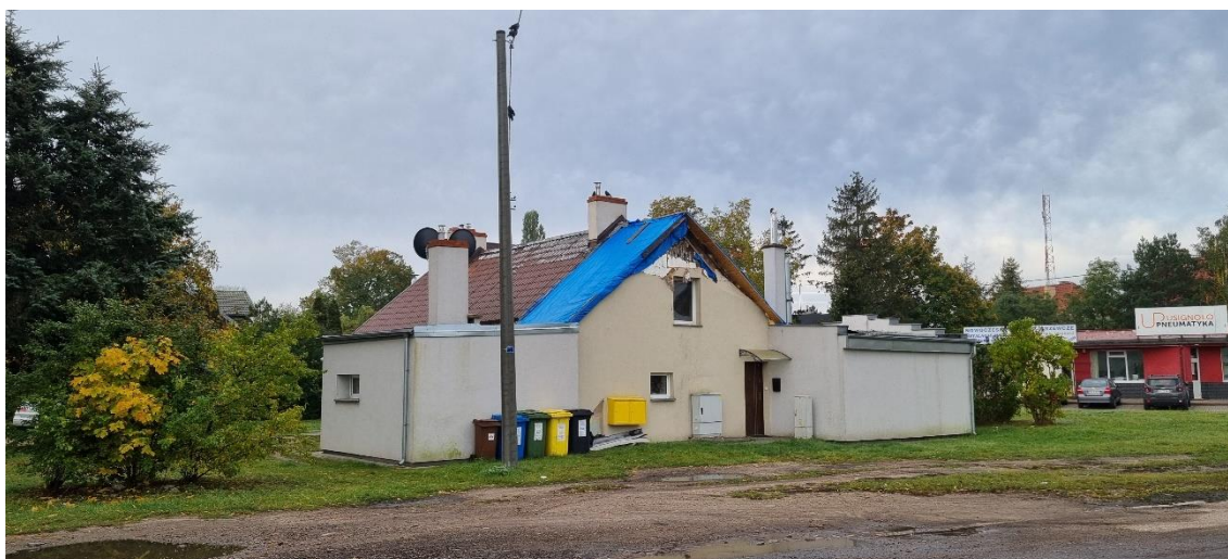
Foto 3. Widok elewacji północno-wschodniej istniejącego budynku mieszkalnego wielorodzinnego;
