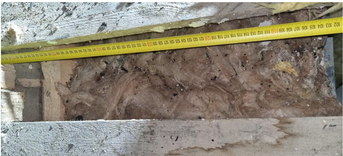
Foto 52. Widok stanu technicznego elementów stropu poddasza nie uszkodzonych przez pożar;
