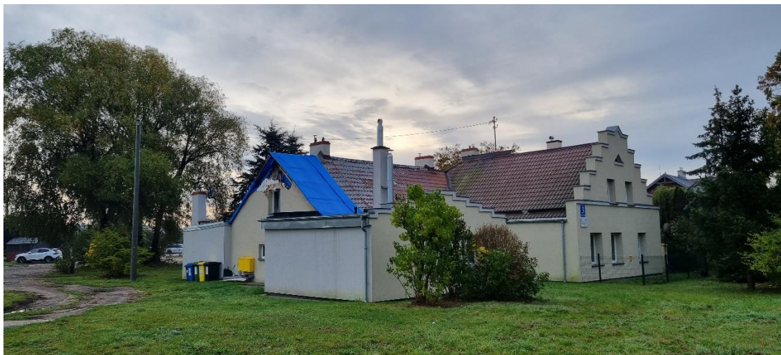
Foto 1. Widok elewacji zachodniej istniejącego budynku mieszkalnego wielorodzinnego;
