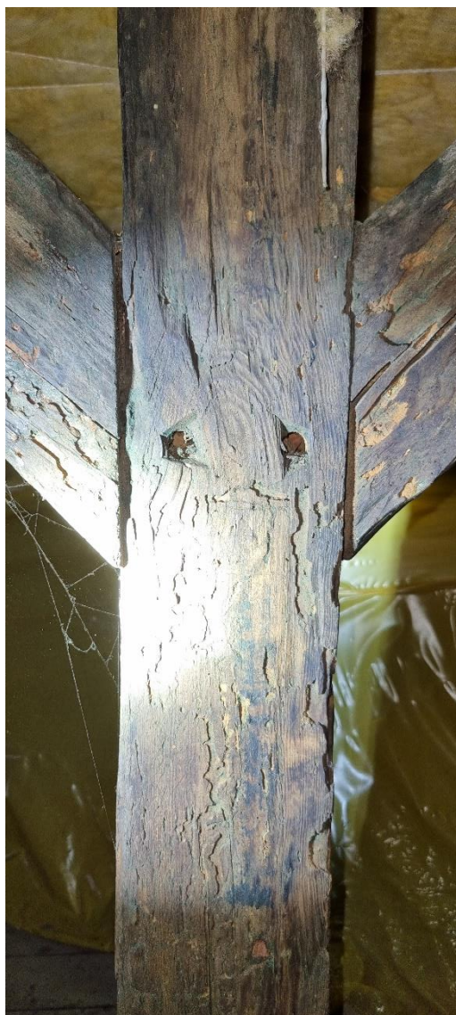
Foto 44. Widok stanu technicznego elementów więźby dachowej nie uszkodzonych przez pożar;
