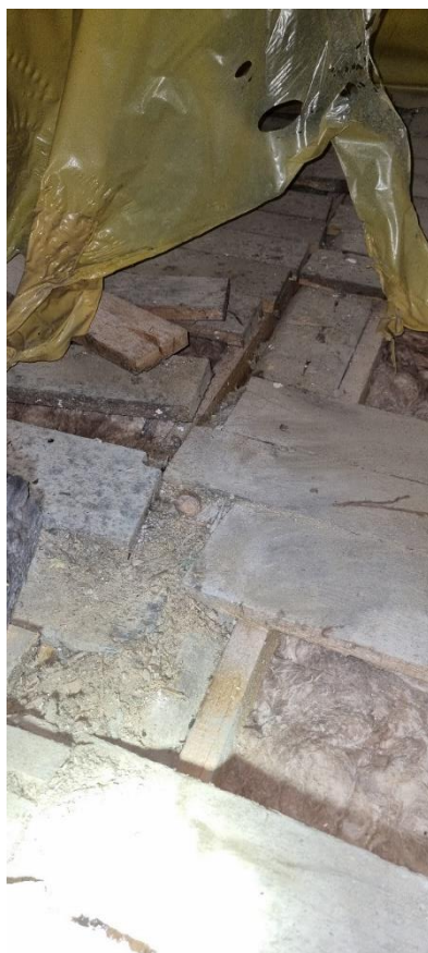
Foto 56. Widok stanu technicznego elementów stropu poddasza nie uszkodzonych przez pożar;
