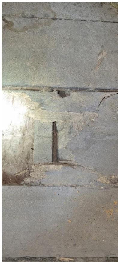
Foto 55. Widok stanu technicznego elementów stropu poddasza nie uszkodzonych przez pożar;
