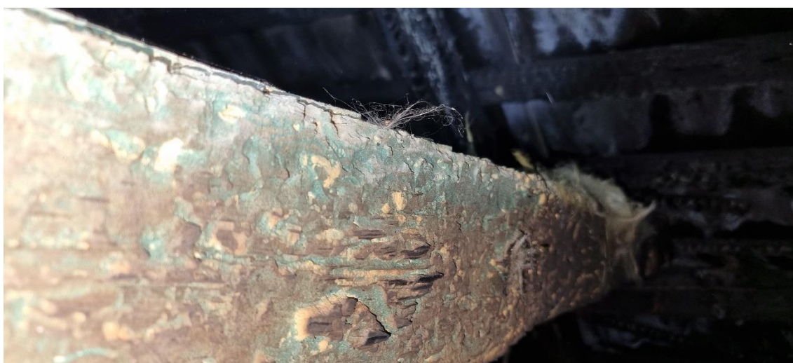
Foto 37. Widok stanu technicznego elementów więźby dachowej nie uszkodzonych przez pożar;
