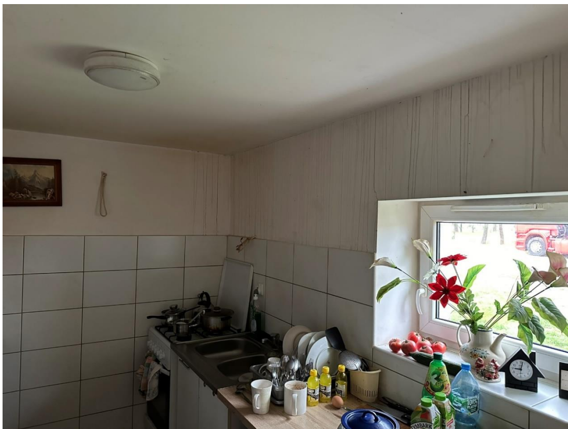
Foto 11. Widok stanu technicznego pomieszczeń poszczególnych lokali mieszkalnych na parterze;
