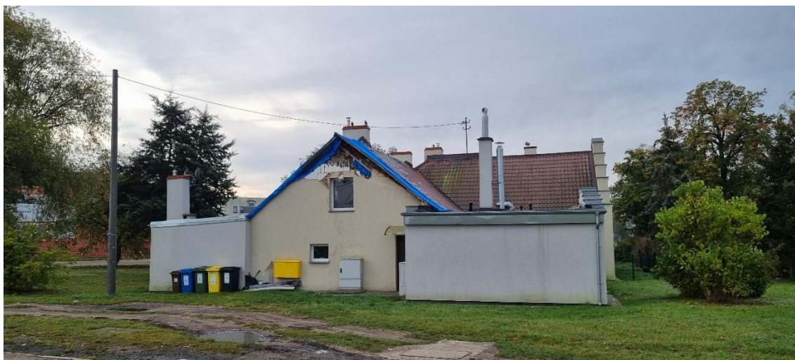
Foto 2. Widok elewacji północnej istniejącego budynku mieszkalnego wielorodzinnego;
