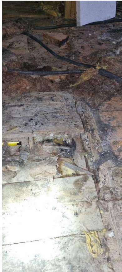
Foto 53. Widok stanu technicznego elementów stropu poddasza nie uszkodzonych przez pożar;
