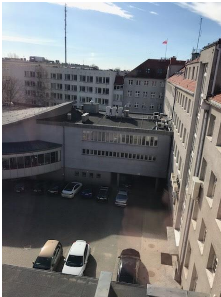
Fot. 1 Widok na dach
