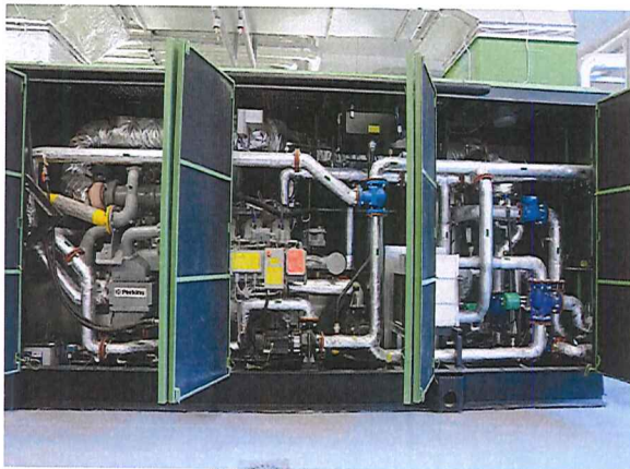
Bioelektrownia – Kogenerator
