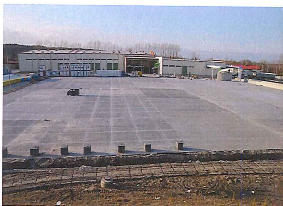
Budynek sortowni i kompostowni
