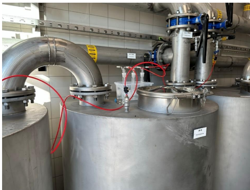
Rysunek 2. Filtry węglowe w węźle filtracji biogazu z elementami do poboru prób..
