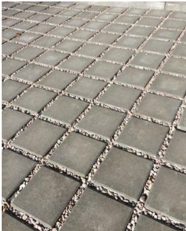
Wzór kostki – EKO KWADRAT – SPOINY WYPEŁNIONE GRYSIKIEM
