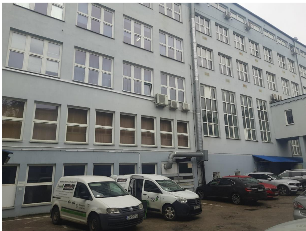
Zdj. B Elewacja południowa Budynku Głównego
