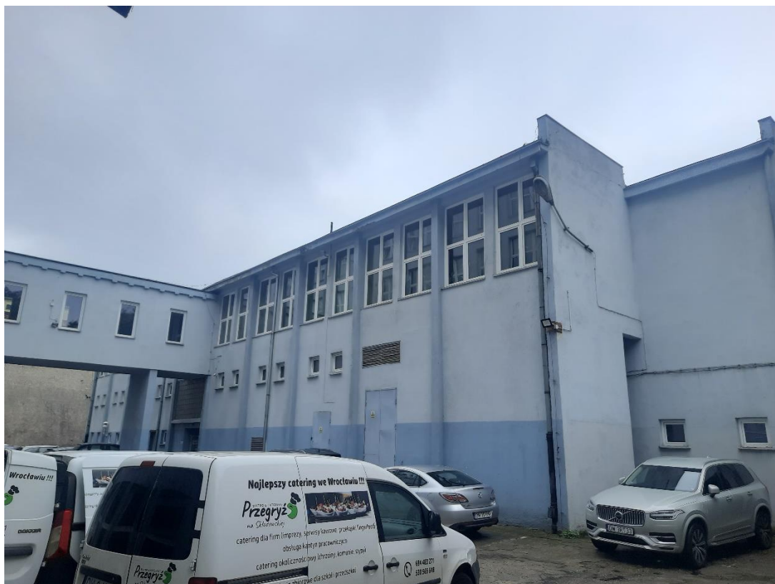
Zdj. C Elewacja północno-zachodnia Hali Technologicznej
