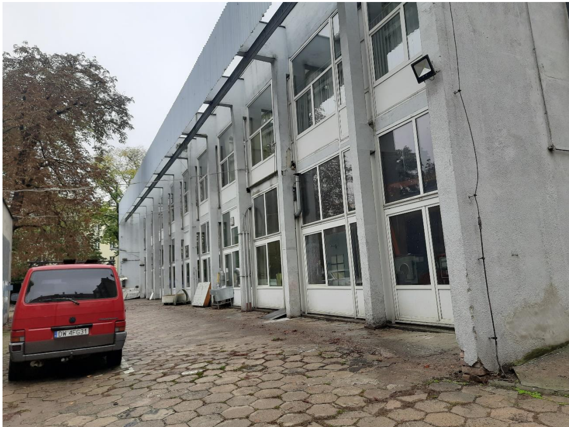
Zdj. E Elewacja południowa Hali technologicznej
