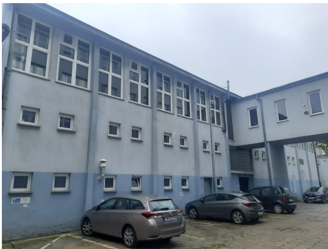
Zdj. D Elewacja północno-wschodnia Hali Technologicznej
