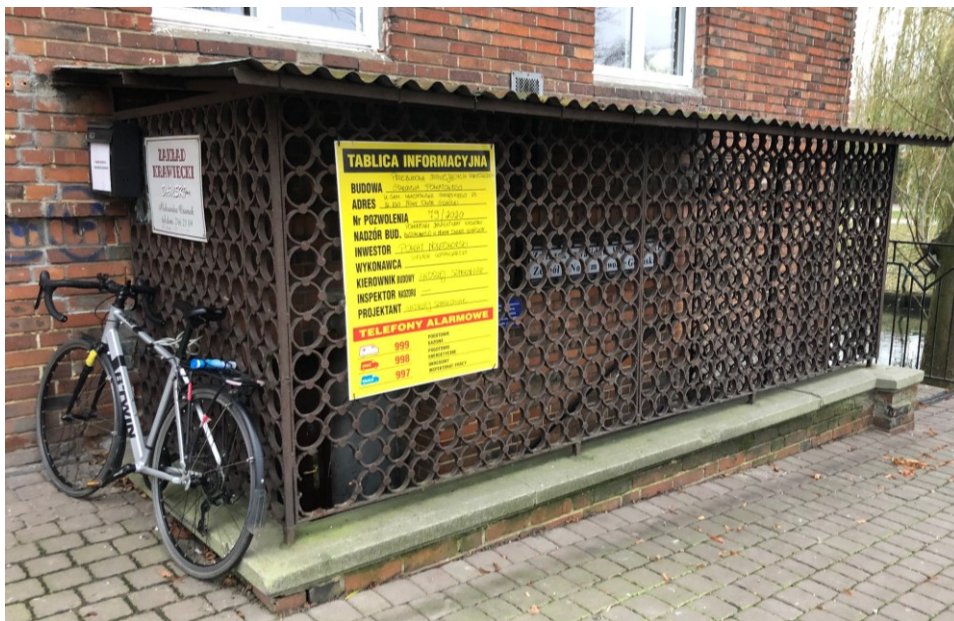
Zadaszenie z konstrukcją do demontażu
