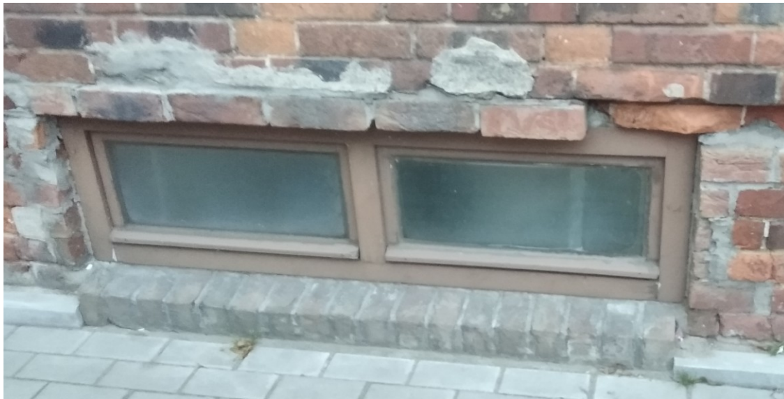
Widok na okno do piwnicy.
