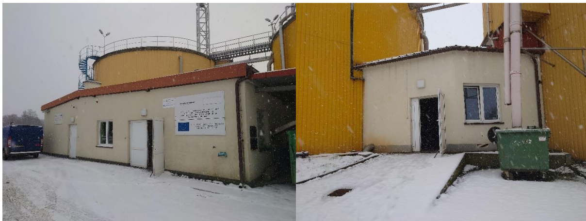
Fot. 10 Budynek socjalno - techniczny.
