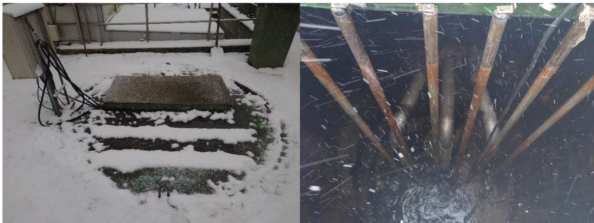
Fot. 4 Przepompownia ścieków.
