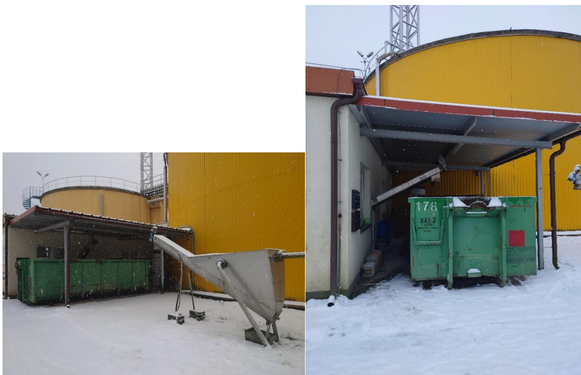
Fot. 11 Wiata na kontener osadowy oraz separator piasku.
