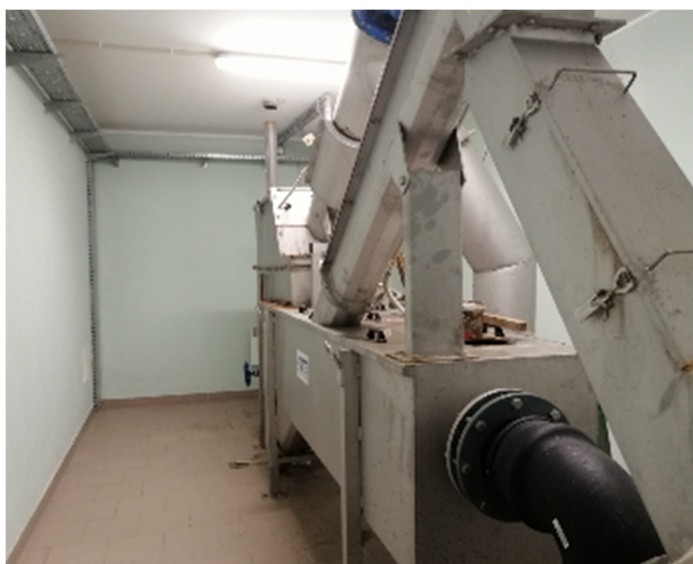
Fot.4. Budynek socjalno-techniczny – pomieszczenie mechanicznego oczyszczania
