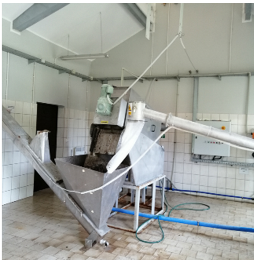
Fot.11. Budynek odwadniania osadu – instalacja odwadniania i higienizacji osadu
