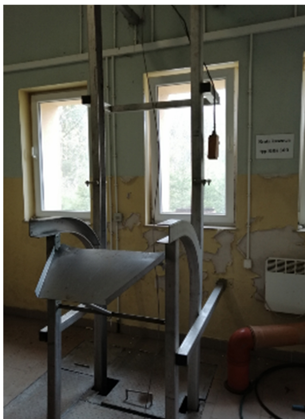
Fot.2. Przepompownia główna – kraty koszowa
