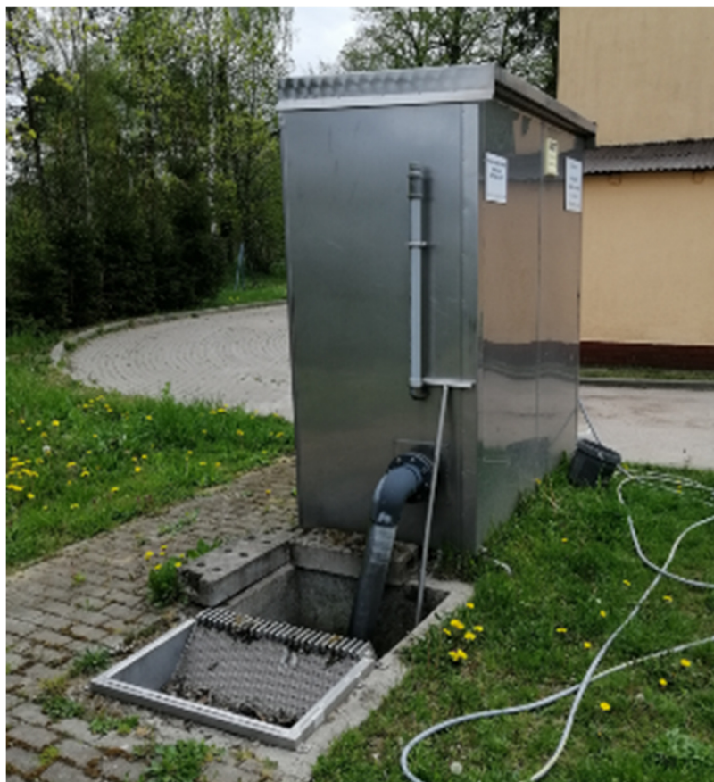
Fot.14. Stacja zlewna, krata ręczna
