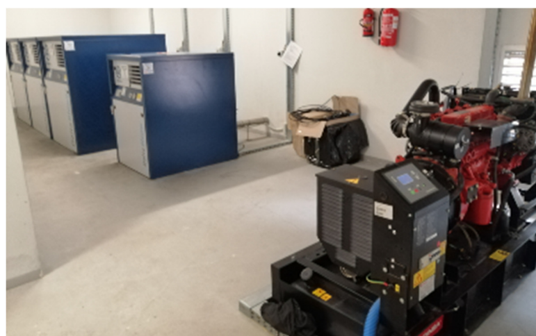
Fot.5. Budynek socjalno-techniczny – pomieszczenie dmuchaw i agregatu
