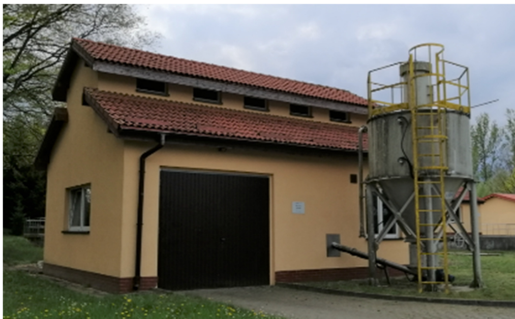
Fot.12. Silos wapna wraz z przenośnikiem
