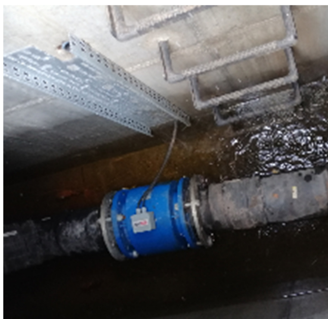
Fot.16, 17. Komora przepływomierza
