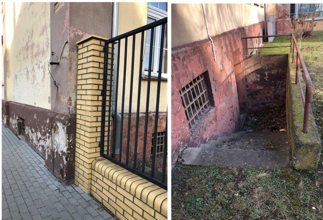
Zejsście do piwnicy (Murek wraz z barierkami do oczyszczenia i pomalowania w kolorze szarym)
