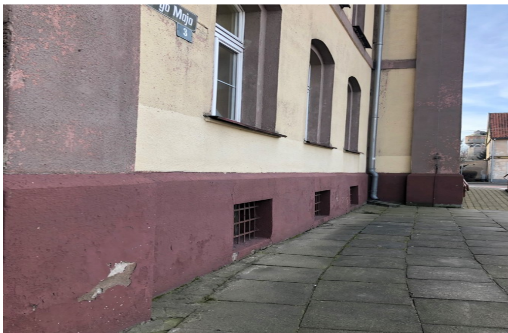
Widok na podjazd dla osób niepełnosprawnych i cokół
