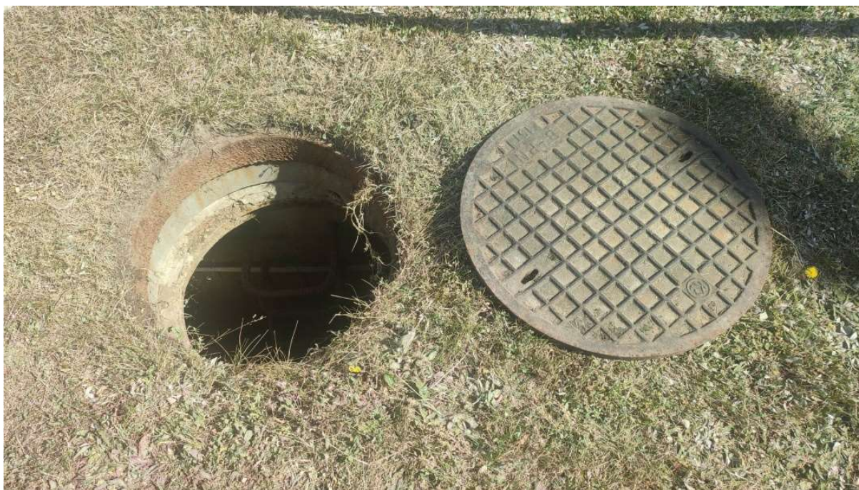
Fot. 3 – Właz do komory przewidziany do przebudowy
