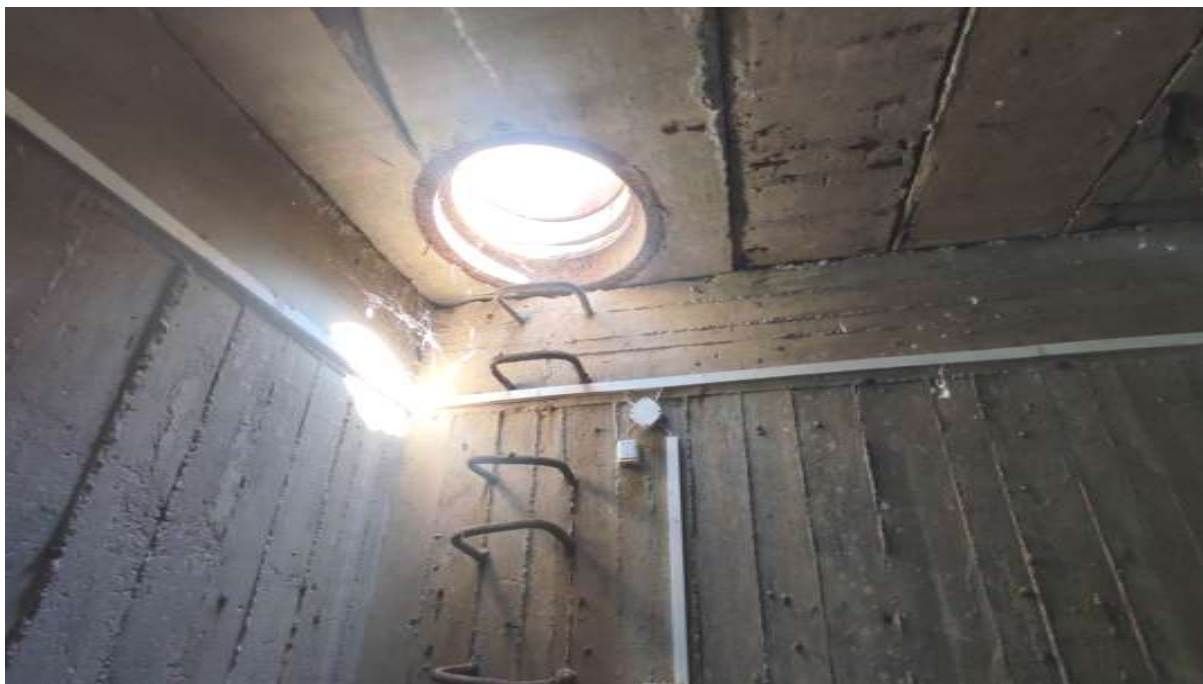
Fot. 4 – Właz do komory przewidziany do przebudowy (widok od wewnątrz)
