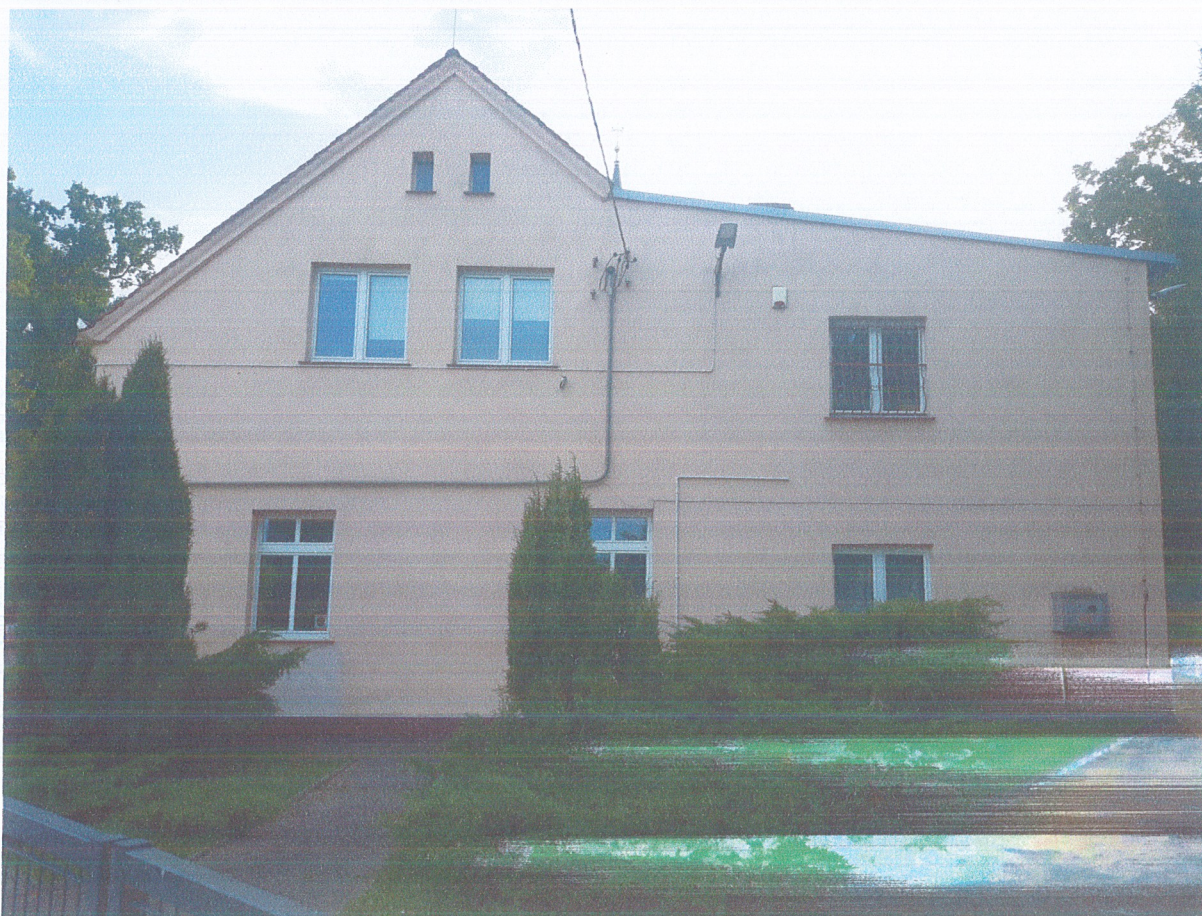
Widok na elewację boczną wschodnią budynku szkoły.
