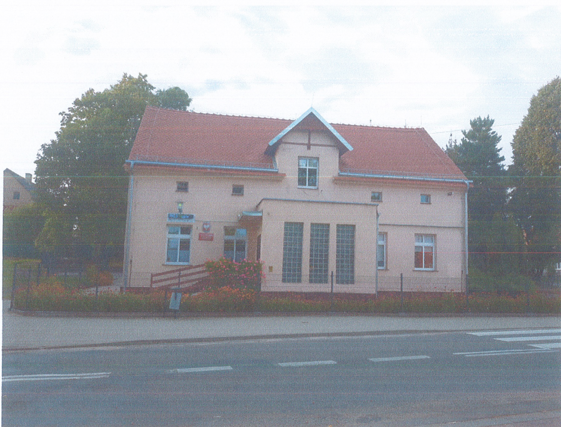
Widok na elewację frontową z wejściem głównym do szkoły.
