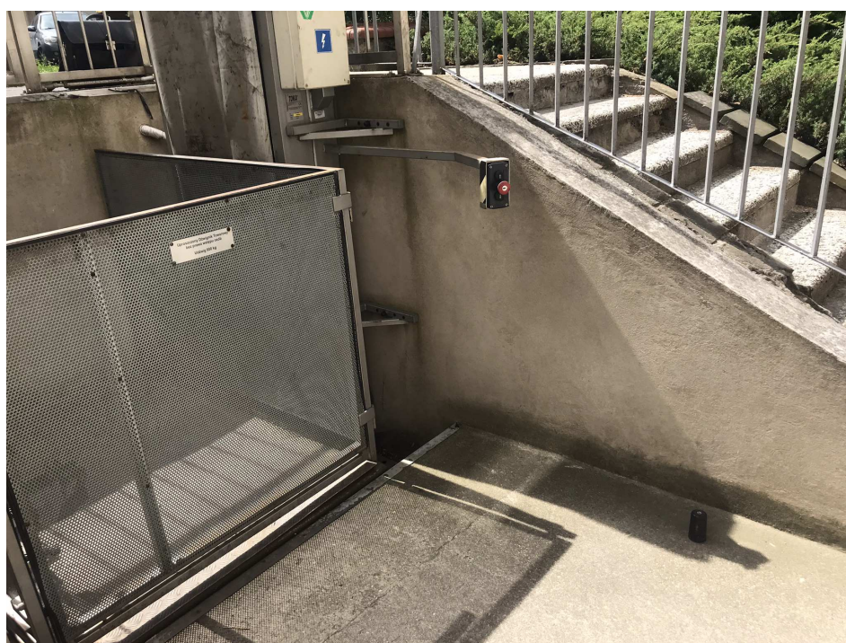
Podnośnik do demontażu. Balustrada do wykorzystania. Schody w tle do rozbiórki.
