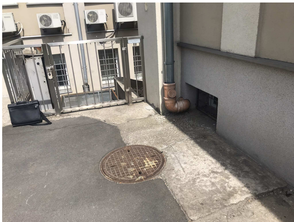
Balustrada przy podnośniku (górny poziom).
