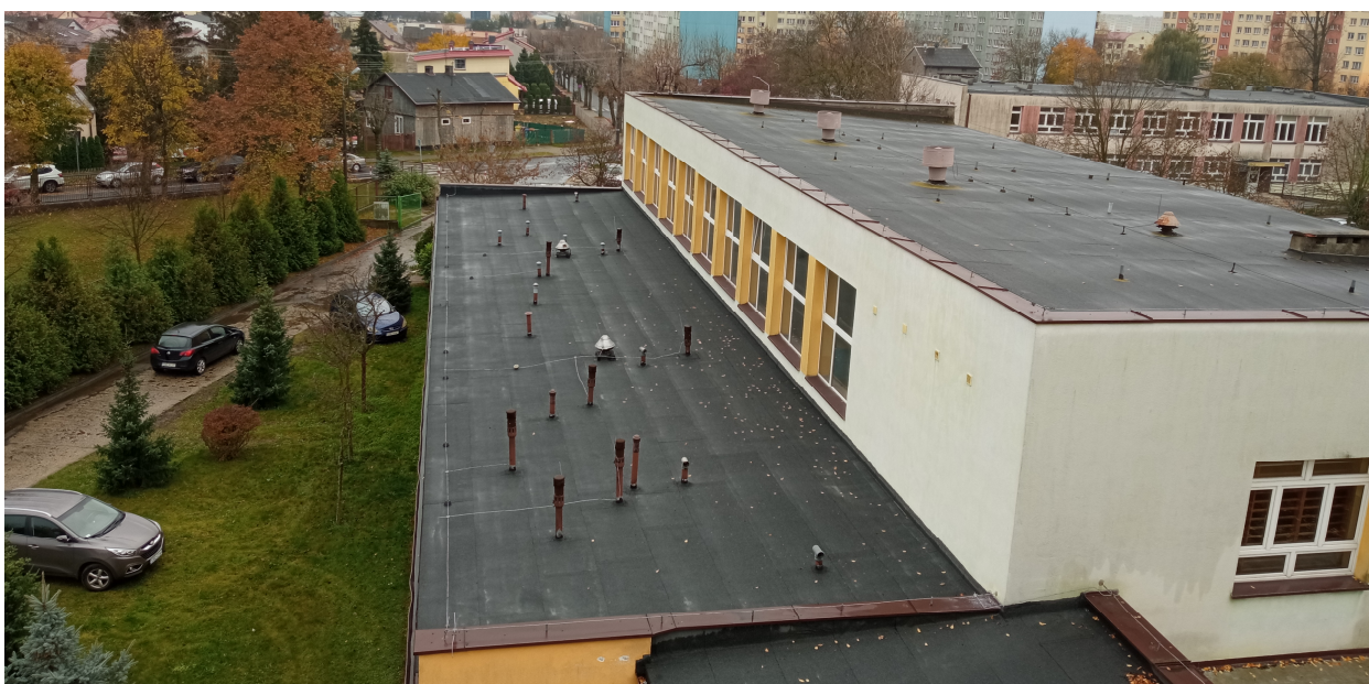
Fot. Widok na dach, cz. B
