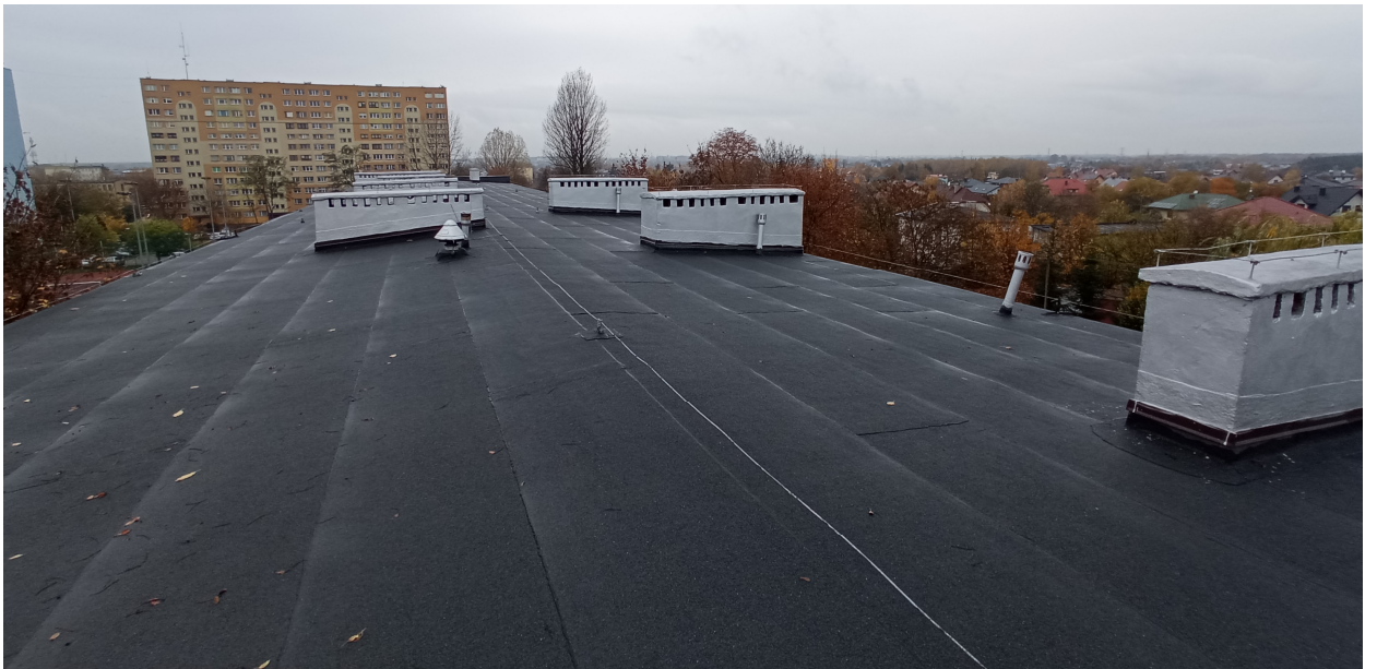
Fot. Widok na dach, cz. A
