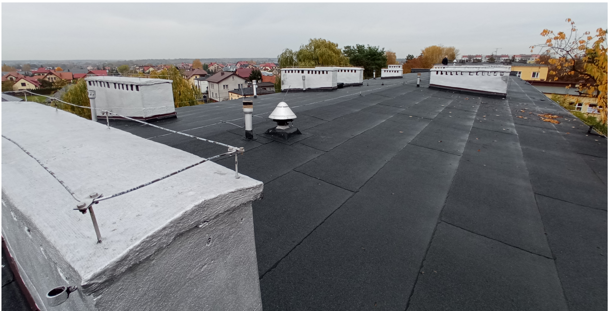
Fot. Widok na dach, cz. A
