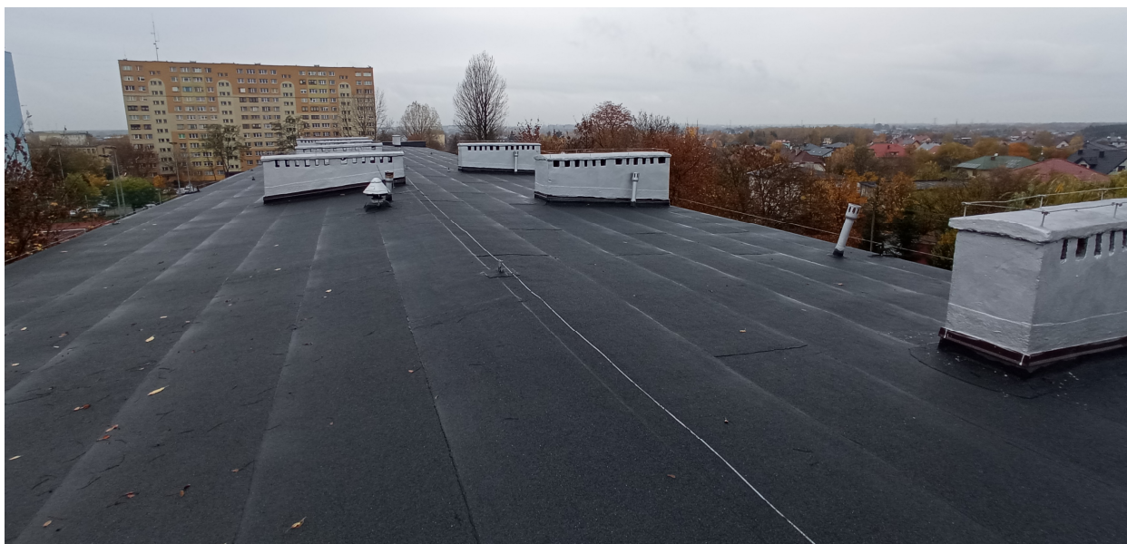
Fot. Widok na dach, cz. A
