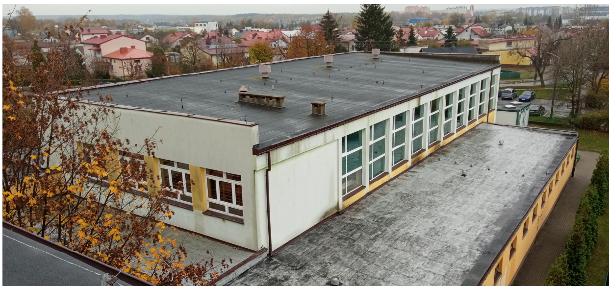
Fot. Widok na dach nad salą gimnastyczną
