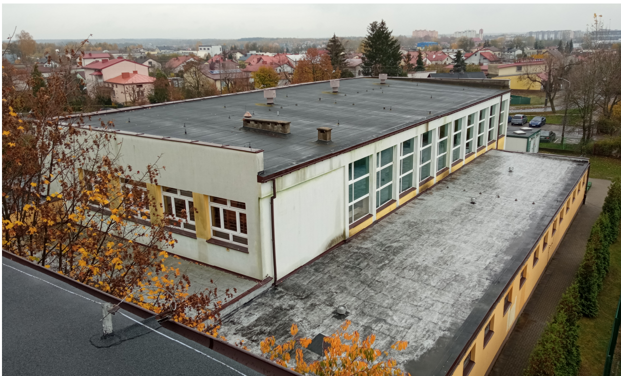
Fot. Widok na dach, cz. B
