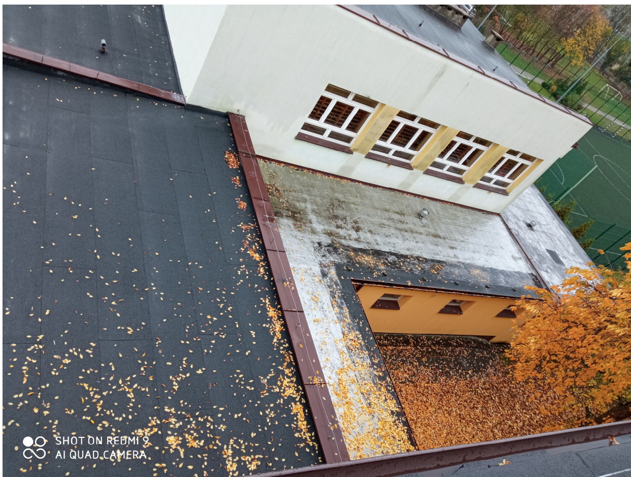
Fot. Widok na dach, cz. B
