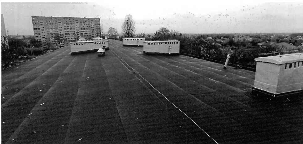
Fot. Widok na dach, cz. A
