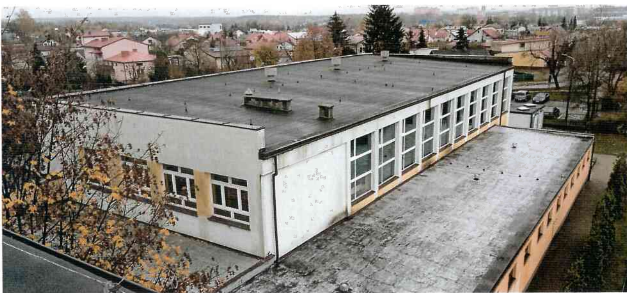
Fot. Widok na dach nad salą gimnastyczną
