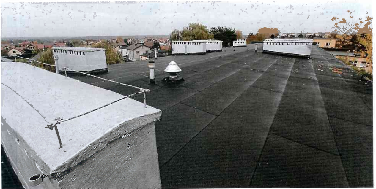
Fot. Widok na dach, cz. A
