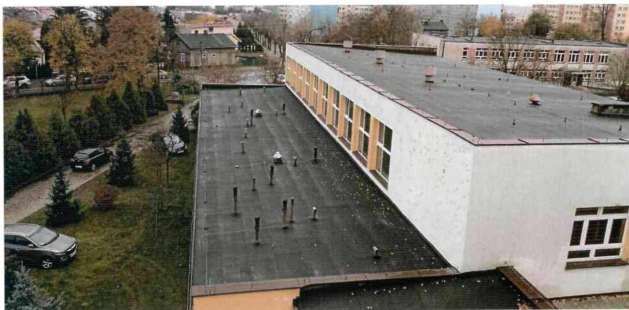
Fot. Widok na dach, cz. B
