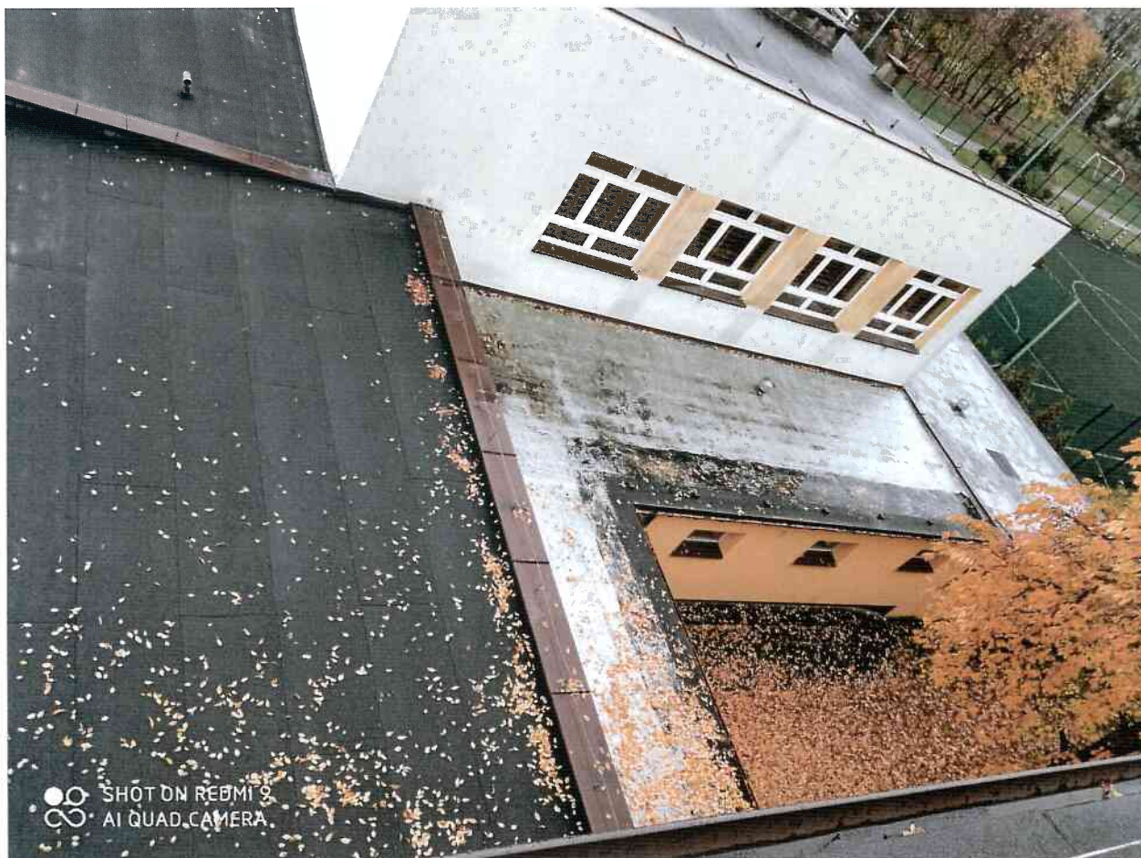
Fot. Widok na dach, cz. B
