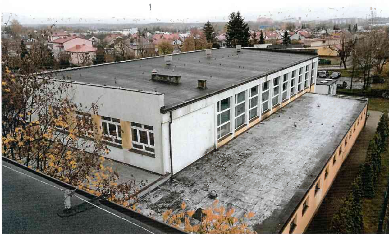
Fot. Widok na dach, cz. B
