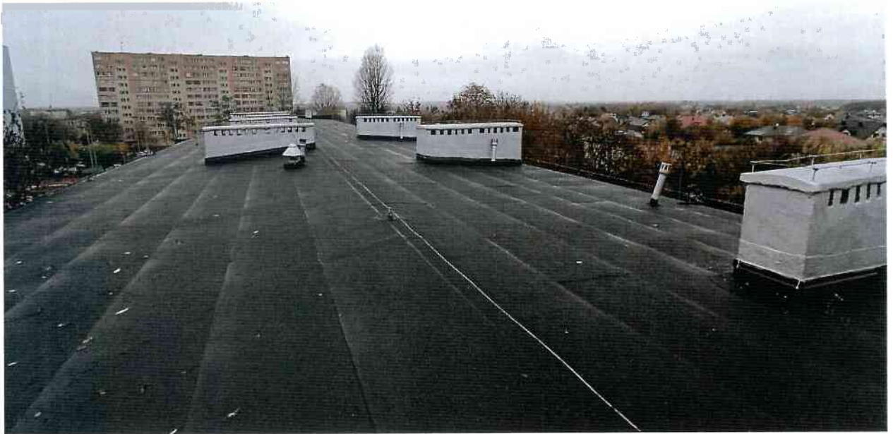
Fot. Widok na dach, cz. A
