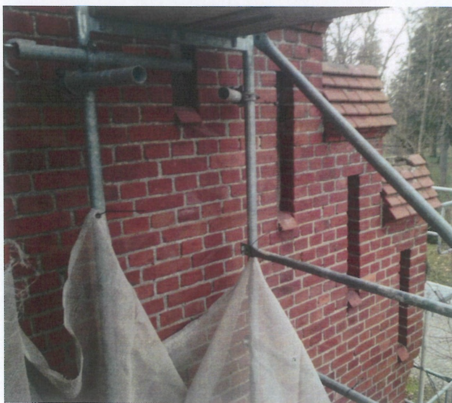
Fot. 22 i 23 (wyk. W. Tomaszewski): Widok stanu zachowania wybranych fragmentów wschodniej ściany szczytowej (od str. północnej). Widoczne są: braki kształtek ceramicznych, ich pęknięcia i uszczerbienia. Wątki ceglane ścian pionowych w dobrym stanie zachowania. Całość zwarta i kompletna. Sporadycznie zdarzają się bardzo małe ubytki spoiny (szczeliny i odpryski).
