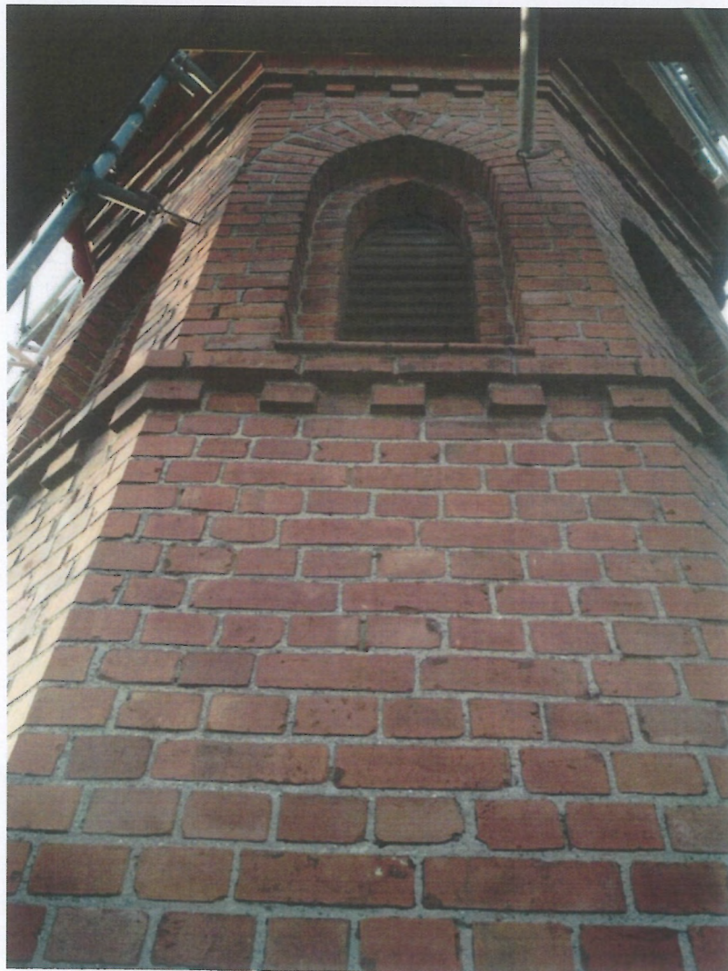
Fot. 12 i 13 (wyk. W. Tomaszewski): Widok stanu zachowania ścian wieży na poziomie gzymsu koronującego. Stan zachowania cegieł i spoin ocenia się jako dobry. Całość zwała i kompletna. Sporadycznie zdarzają się bardzo małe ubytki spoiny (szczeliny i odpryski).
