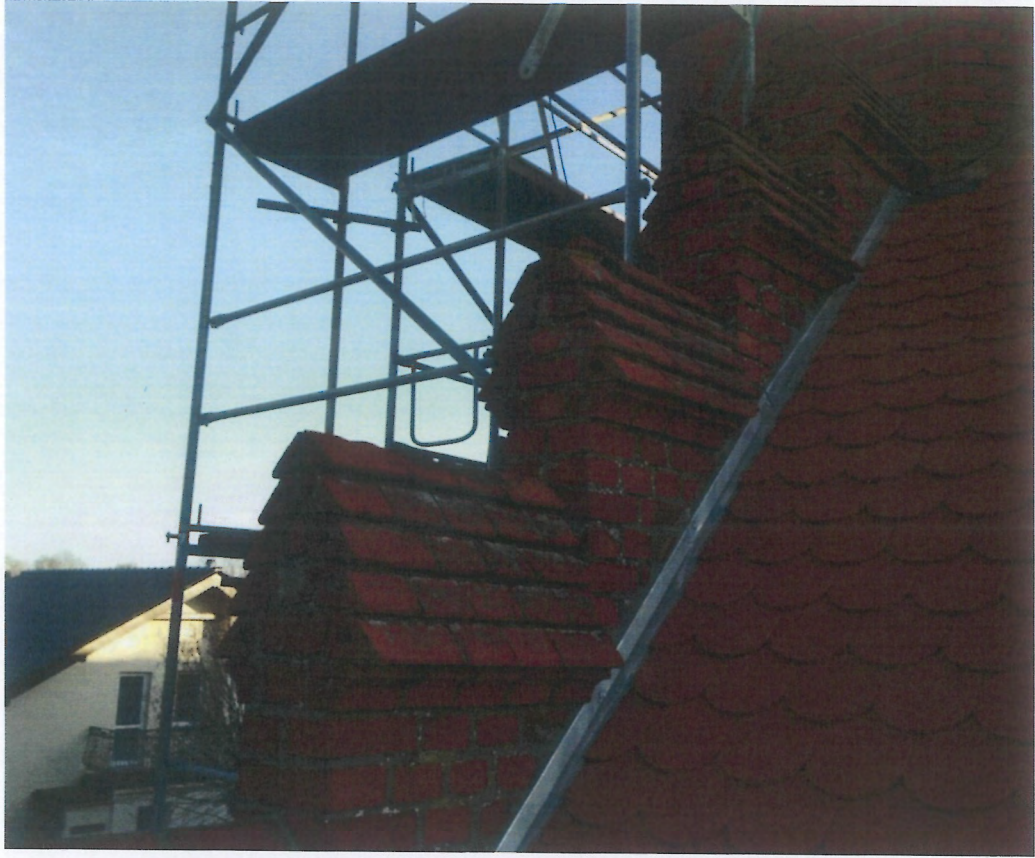
Fot. 24 i 25 (wyk. W. Tomaszewski): Widok stanu zachowania wybranych fragmentów wschodniej ściany szczytowej (od str. północnej).
