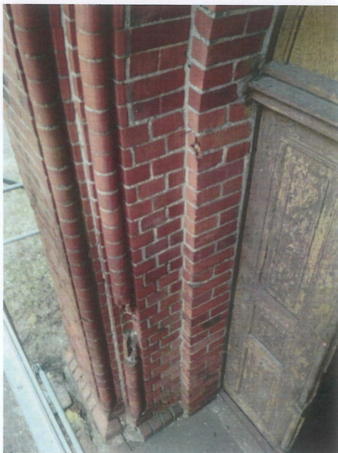
Fot. 31 i 32 (wyk. W. Tomaszewski): Widok stanu zachowania powierzchni portalu. Widoczny istotny ubytek wałka na odcinku kila kształtek ceramicznych. U podstawy brak kształtki ceramicznej.
