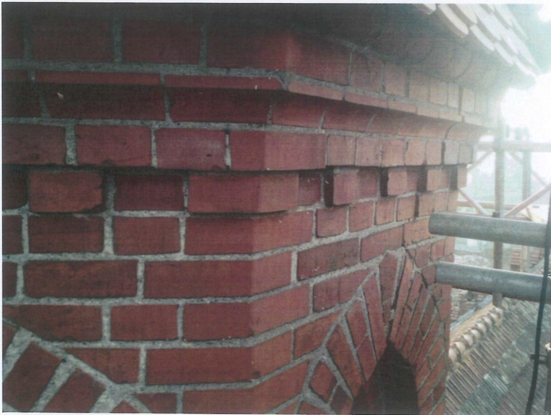
Fot. 10 i 11 (wyk. W. Tomaszewski): Widok stanu zachowania ścian wieży na poziomie gzymsu koronującego. Stan zachowania cegieł i spoin ocenia się jako dobry. Całość zwała i kompletna. Sporadycznie zdarzają się bardzo małe ubytki spoiny (szczeliny i odpryski).
