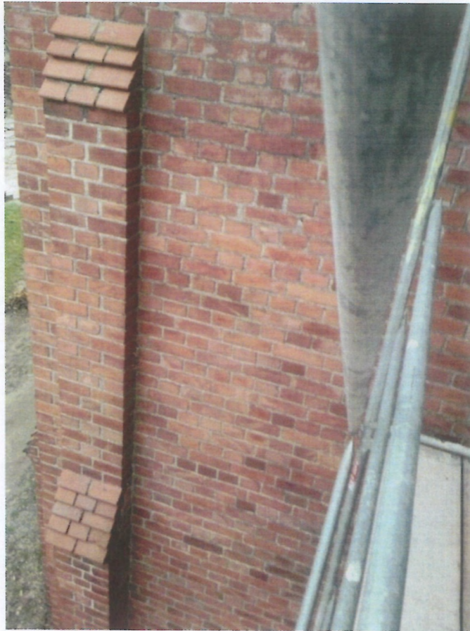
Fot. 17 i 18 (wyk. W. Tomaszewski): Widok stanu zachowania wybranych fragmentów wschodniej ściany szczytowej (od str. południowej). Wątki ceglane ścian pionowych w dobrym stanie zachowania. Całość zwarta i kompletna. Sporadycznie zdarzają się bardzo małe ubytki spoiny (szczeliny i odpryski) oraz przebielenia powstałe z wyptukania zaprawy murarskiej (wysięki wapienne).
