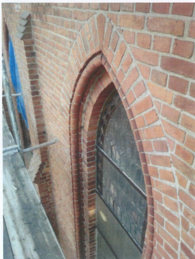
Fot. 56 i 57 (wyk. W. Tomaszewski): Widok stanu zachowania wątków ceglanych i kształtek ceramicznych na poziomie ostrołukowych wnęk okiennych elewacji północnej. Wątki ceglane oraz kształtki ceramiczne są w dobrym stanie zachowania. Całość zwarta i kompletna.
