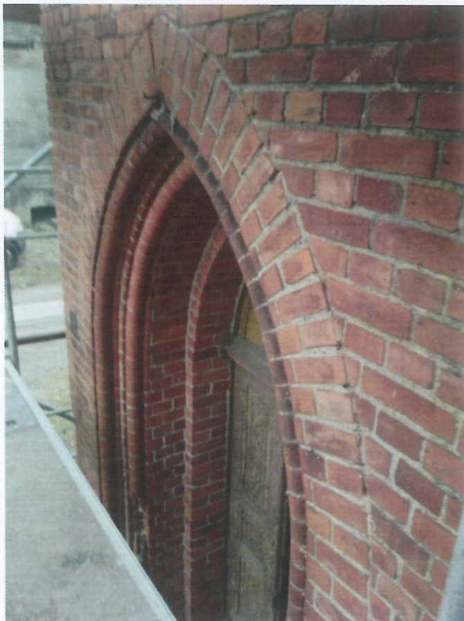
Fot. 31 i 32 (wyk. W. Tomaszewski): Widok stanu zachowania powierzchni portalu. Widoczny istotny ubytek wałka na odcinku kila kształtek ceramicznych. U podstawy brak kształtki ceramicznej.
