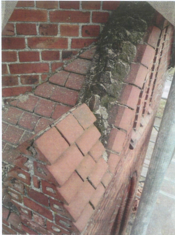
Fot. 19 i 20 (wyk. W. Tomaszewski): Widok stanu zachowania wybranych fragmentów środka elewacji wschodniej. Na skośnej powierzchni brakuje gąsiorów ceramicznych. Wątki ceglane ścian pionowych w dobrym stanie zachowania. Całość zwarta i kompletna. Sporadycznie zdarzają się bardzo małe ubytki spoiny (szczeliny i odpryski) oraz przebielenia powstałe z wypłukania zaprawy murarskiej (wysięki wapienne).
