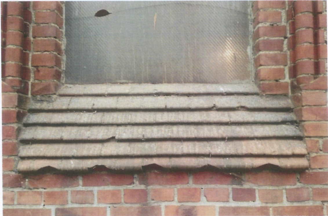
Fot. 58 i 59 (wyk. W. Tomaszewski): Widok ubytków oraz braków w wątkach ceglanych i kształtkach ceramicznych na wybranych fragmentach elewacji północnej.
