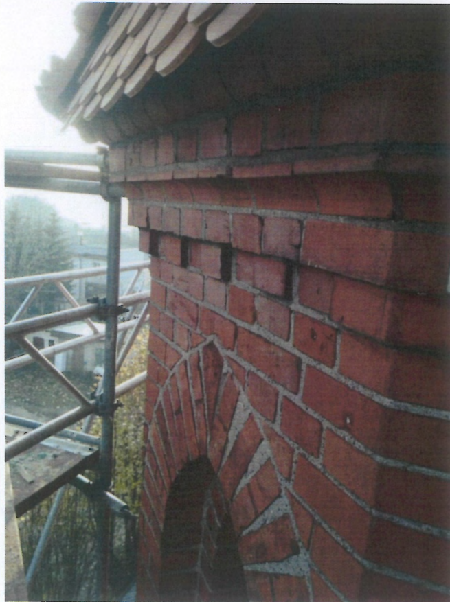
Fot. 6 i 7 (wyk. W. Tomaszewski): Widok stanu zachowania ścian wieży na poziomie gzymsu koronującego. Stan zachowania cegieł i spoin ocenia się jako dobry. Całość zwała i kompletna. Sporadycznie zdarzają się bardzo małe ubytki spoiny (szczeliny i odpryski).
