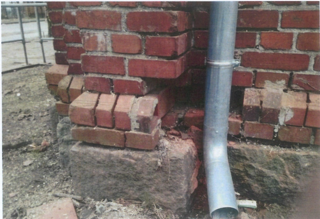
Fot. 58 i 59 (wyk. W. Tomaszewski): Widok ubytków oraz braków w wątkach ceglanych i kształtkach ceramicznych na wybranych fragmentach elewacji północnej.
