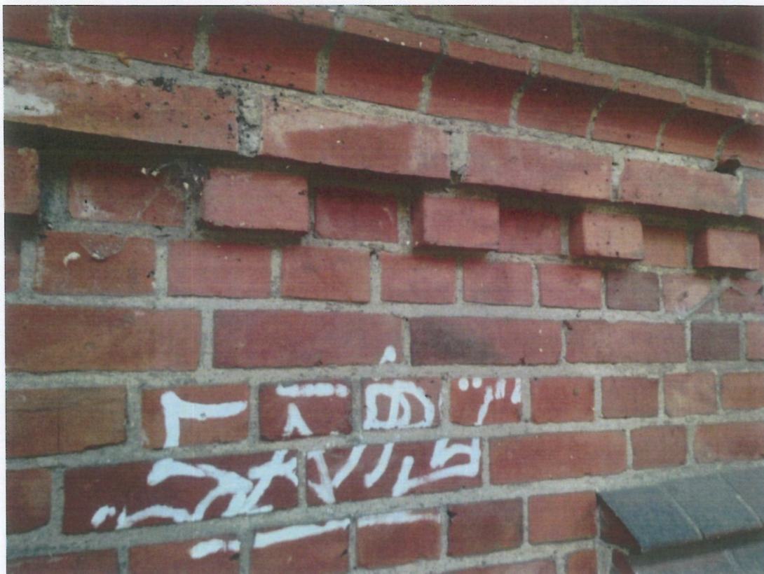
Fot. 54 i 55 (wyk. W. Tomaszewski): Widok stanu zachowania wątków ceglanych i kształtek ceramicznych na poziomie gzymsu koronującego. Wątki ceglane oraz kształtki ceramiczne są w dobrym stanie zachowania. Całość zwarta i kompletna. Sporadycznie zdarzają się bardzo małe ubytki spoiny (szczeliny i odpryski). Widoczny akt wandalizmu w postaci graffiti.
