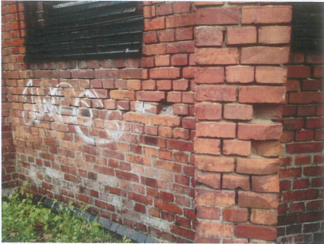
Fot. 44 i 45 (wyk. W. Tomaszewski): Widok stanu zachowania wybranych powierzchni ścian prezbiterium. Zauważa się utracenia narożników cegieł, ubytki odcinków zwietrzałych i wypłukanych spoin. Spotyka się braki pojedynczych cegieł oraz kształtek ceramicznych. Szkliwione kształtki ułożone na parapetach mają poutrącane krawędzie oraz powierzchniowe odpryski i zmatowienia szkliva. Obecne są również śladowe zabrudzenia smołą oraz akty wandalizmu w postaci graffiti.
