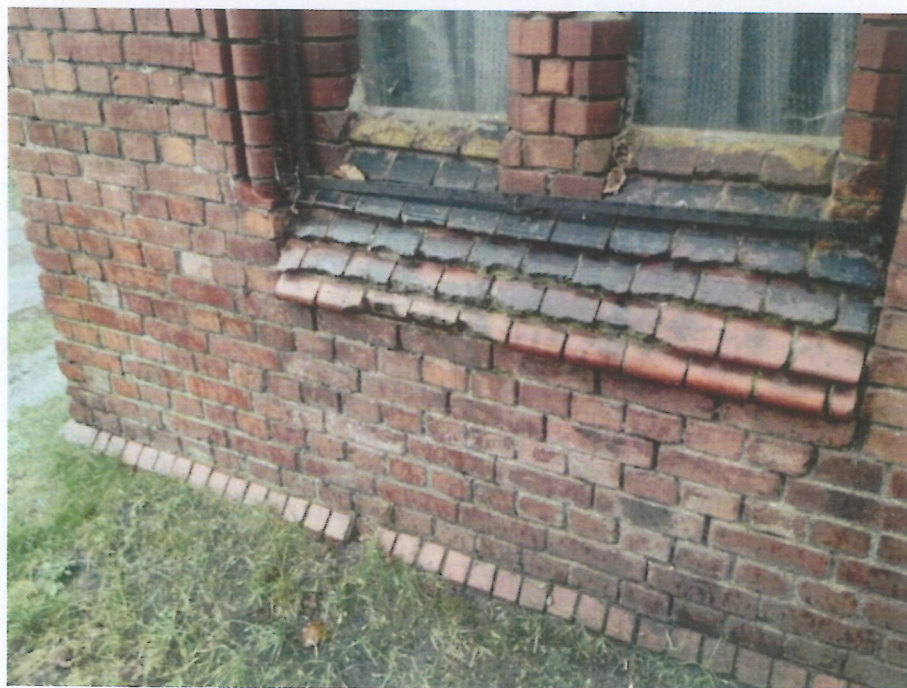
Fot. 38 i 39 (wyk. W. Tomaszewski): Widok stanu zachowania zakrystii. Zauważa się utracenia narożników cegieł, ubytki odcinków zwietrzałych i wypłukanych spoin. Spotyka się braki pojedynczych cegieł oraz kształtek ceramicznych. Szkliwione kształtki ułożone na parapetach mają poutrącane krawędzie oraz powierzchniowe odpryski i zmatowienia szkliva.
