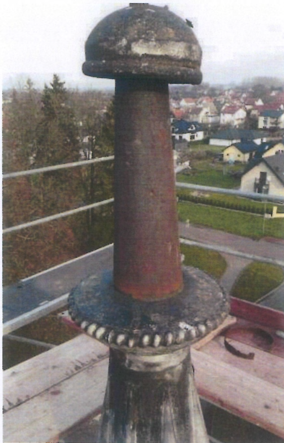
Fot. 2 i 3 (wyk. W. Tomaszewski): Widok metalowych części składowych wieńczących hełm wieży kościoła.
