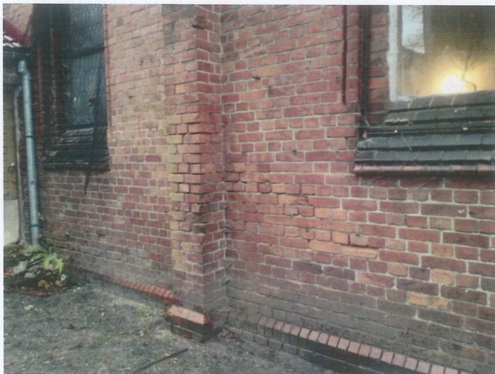
Fot. 35 i 36 (wyk. W. Tomaszewski): Widok stanu zachowania wybranych fragmentów powierzchni elewacji południowej. Ogólny stan zachowania wątków ceglanych ocenia się jako dobry, aczkolwiek występują utracenia narożników cegieł, ubytki odcinków zwietrzałych i wypłukanych spoin. Sporadycznie występuje dezintegracja pojedynczych cegieł, które warstwowo osypują się. Szklwiorkształtki ułożone na parapetach mają poutrącone krawędzie oraz powierzchniowe odpryski i zmatowienia szkliska.
