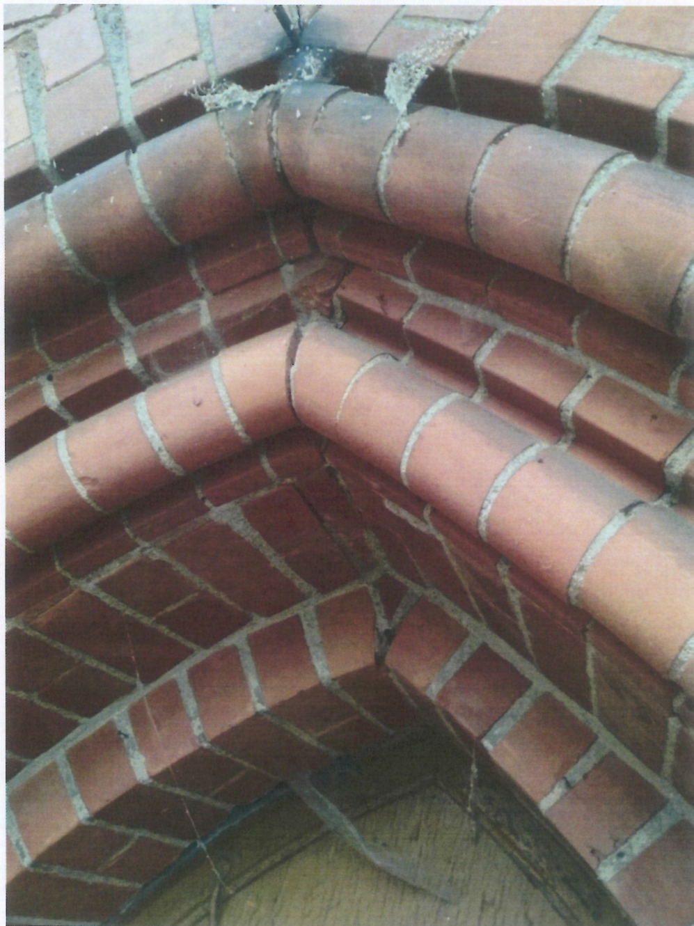
Fot. 28 (wyk. W. Tomaszewski): Widok stanu zachowania zwieńczenia ostrołuku portalu. Wątki ceramiczne w dobrym stanie zachowania, aczkolwiek występują ich niewielkie odpryski. Ogólnie całość zwarta i kompletna. Na powierzchni występuje patyna powstała z zanieczyszczeń atmosferycznych (sadzy kominowej). Wątki ceglane ścian pionowych w dobrym stanie zachowania. Sporadycznie zdarzają się bardzo małe ubytki spoiny (szczeliny i odpryski).
