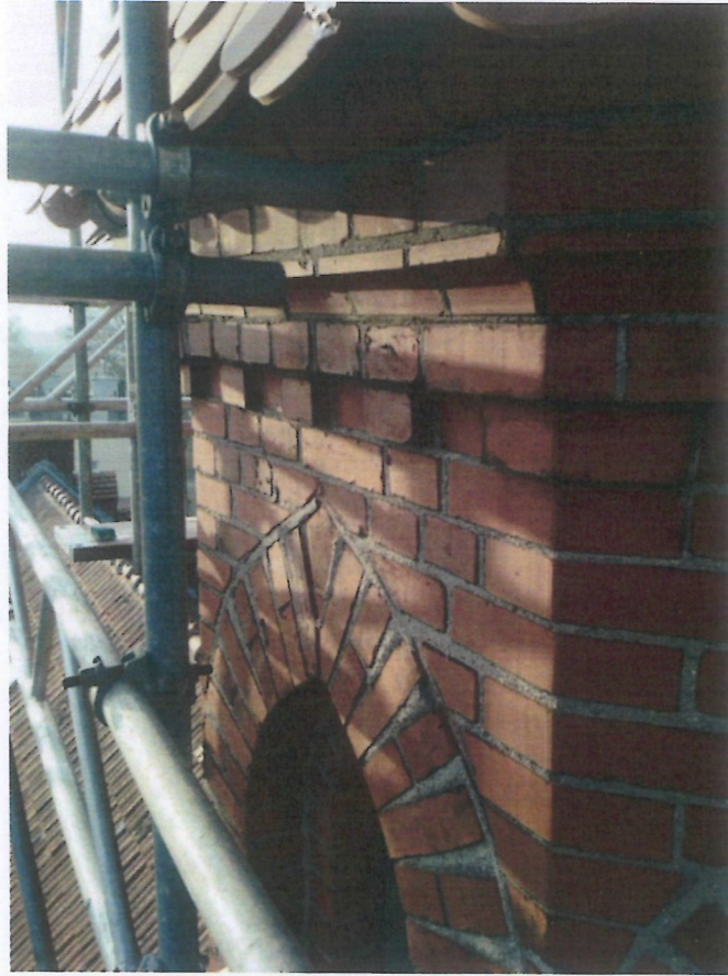
Fot. 6 i 7 (wyk. W. Tomaszewski): Widok stanu zachowania ścian wieży na poziomie gzymsu koronującego. Stan zachowania cegieł i spoin ocenia się jako dobry. Całość zwała i kompletna. Sporadycznie zdarzają się bardzo małe ubytki spoiny (szczeliny i odpryski).
