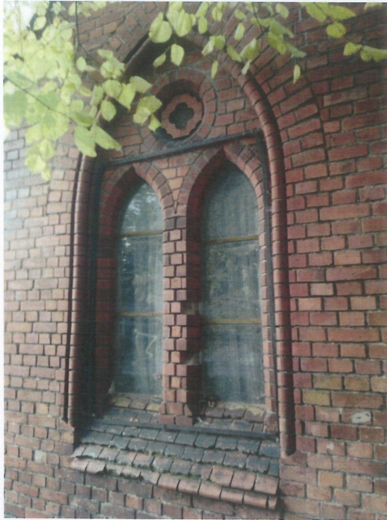
Fot. 38 i 39 (wyk. W. Tomaszewski): Widok stanu zachowania zakrystii. Zauważa się utracenia narożników cegieł, ubytki odcinków zwietrzałych i wypłukanych spoin. Spotyka się braki pojedynczych cegieł oraz kształtek ceramicznych. Szkliwione kształtki ułożone na parapetach mają poutrącane krawędzie oraz powierzchniowe odpryski i zmatowienia szkliva.
