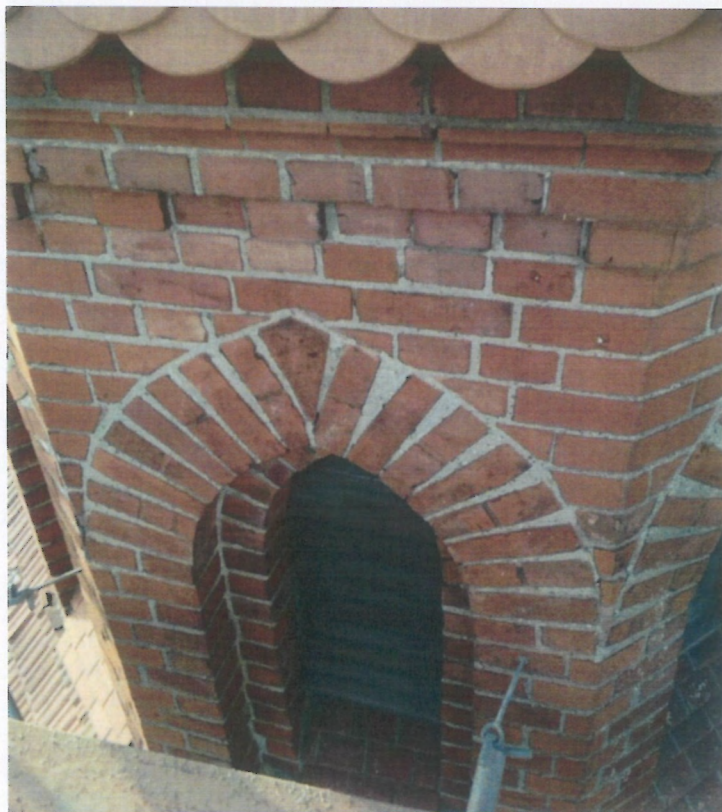
Fot. 8 i 9 (wyk. W. Tomaszewski): Widok stanu zachowania ścian wieży na poziomie gzymsu koronującego. Stan zachowania cegieł i spoin ocenia się jako dobry. Całość zwarta i kompletna. Sporadycznie zdarzają się bardzo małe ubytki spoiny (szczeliny i odpryski).
