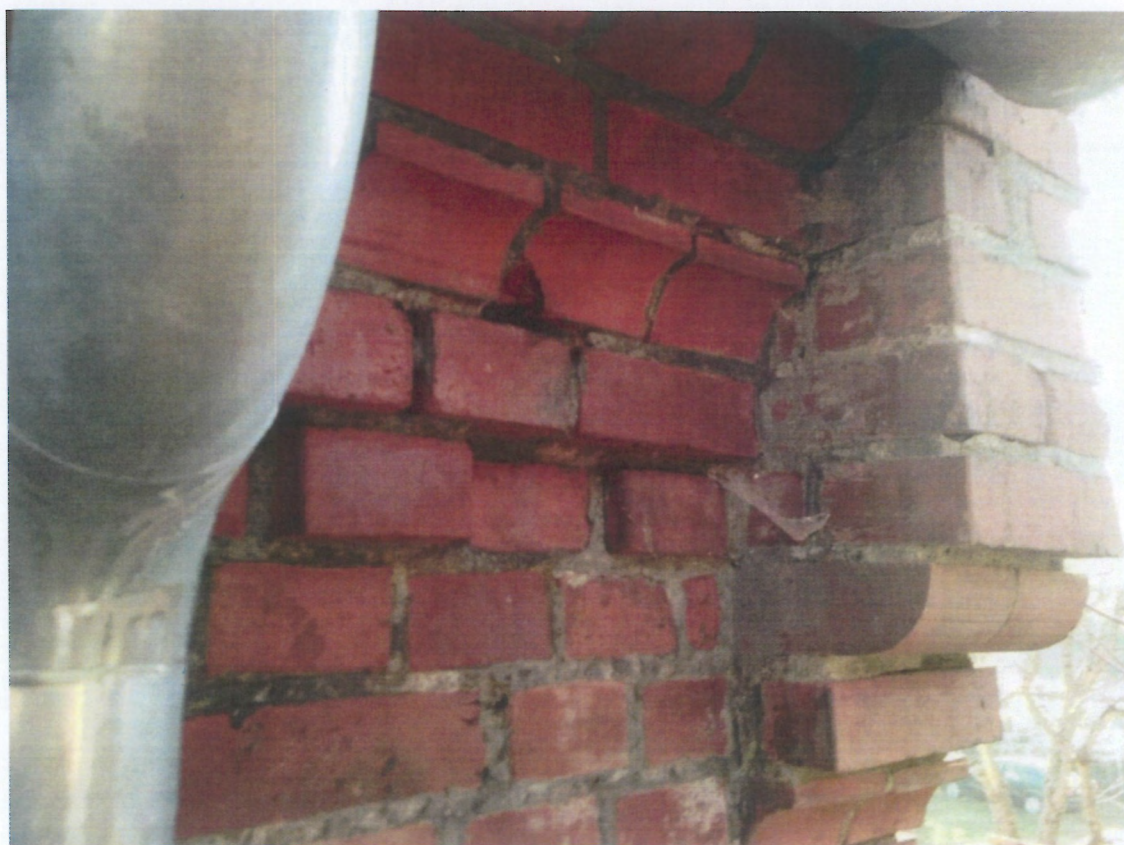
Fot. 54 i 55 (wyk. W. Tomaszewski): Widok stanu zachowania wątków ceglanych i kształtek ceramicznych na poziomie gzymsu koronującego. Wątki ceglane oraz kształtki ceramiczne są w dobrym stanie zachowania. Całość zwarta i kompletna. Sporadycznie zdarzają się bardzo małe ubytki spoiny (szczeliny i odpryski). Widoczny akt wandalizmu w postaci graffiti.
