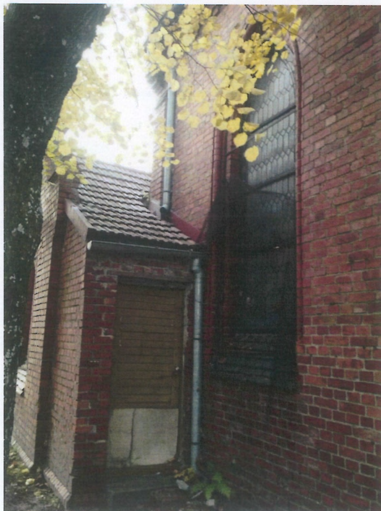
Fot. 35 i 36 (wyk. W. Tomaszewski): Widok stanu zachowania wybranych fragmentów powierzchni elewacji południowej. Ogólny stan zachowania wątków ceglanych ocenia się jako dobry, aczkolwiek występują utracenia narożników cegieł, ubytki odcinków zwietrzałych i wypłukanych spoin. Sporadycznie występuje dezintegracja pojedynczych cegieł, które warstwowo osypują się. Szklwiorkształtki ułożone na parapetach mają poutrącone krawędzie oraz powierzchniowe odpryski i zmatowienia szkliska.
