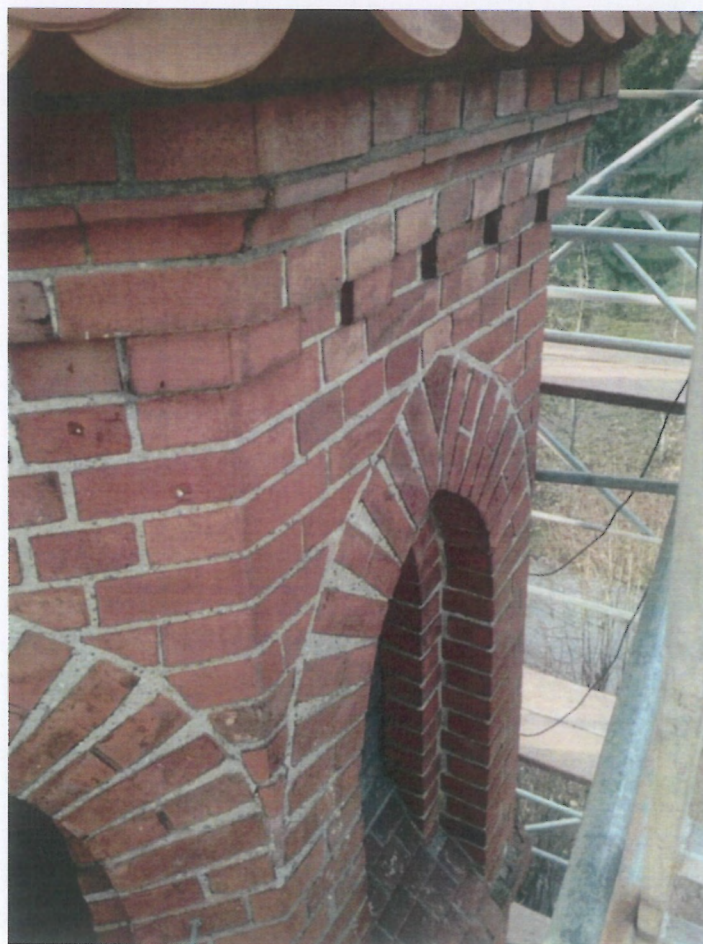
Fot. 8 i 9 (wyk. W. Tomaszewski): Widok stanu zachowania ścian wieży na poziomie gzymsu koronującego. Stan zachowania cegieł i spoin ocenia się jako dobry. Całość zwarta i kompletna. Sporadycznie zdarzają się bardzo małe ubytki spoiny (szczeliny i odpryski).
