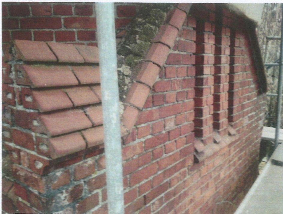
Fot. 19 i 20 (wyk. W. Tomaszewski): Widok stanu zachowania wybranych fragmentów środka elewacji wschodniej. Na skośnej powierzchni brakuje gąsiorów ceramicznych. Wątki ceglane ścian pionowych w dobrym stanie zachowania. Całość zwarta i kompletna. Sporadycznie zdarzają się bardzo małe ubytki spoiny (szczeliny i odpryski) oraz przebielenia powstałe z wypłukania zaprawy murarskiej (wysięki wapienne).
