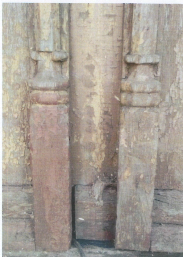
Fot. 65 i 66 (wyk. W. Tomaszewski): Widok stanu zachowania elementów dekoracji stolarsko – snycerskiej oraz warstw farby olejnej odpajającej się od podłoża drewnianego.
