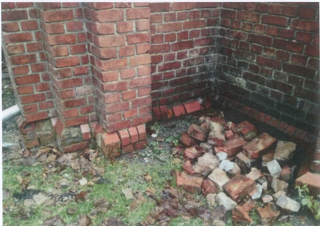
Fot. 46 i 47 (wyk. W. Tomaszewski): Widok stanu zachowania wybranych powierzchni ścian prezbiterium. Zauważa się utracenia narożników cegieł, ubytki odcinków zwietrzałych i wypłukanych spoin. Spotyka się braki pojedynczych cegieł oraz kształtek ceramicznych u podstawy.
