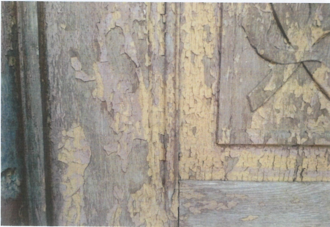
Fot. 67 i 68 (wyk. W. Tomaszewski): Widok stanu zachowania elementów dekoracji stolarsko – snycerskiej oraz warstw farby olejnej odspajającej się od podłoża drewnianego.
