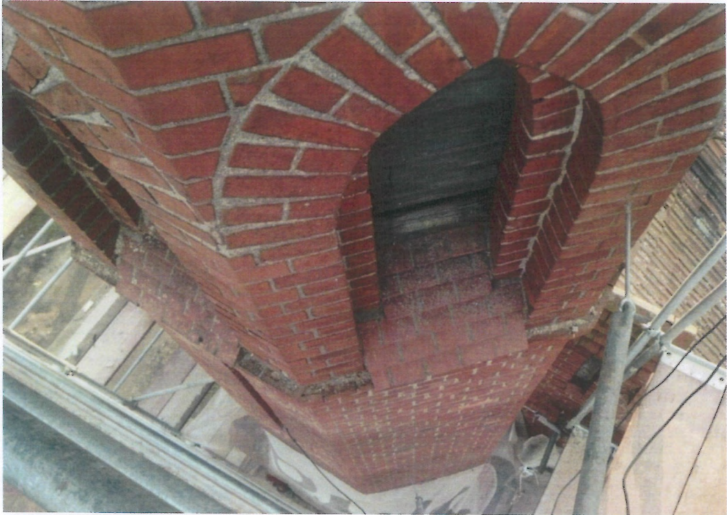
Fot. 12 i 13 (wyk. W. Tomaszewski): Widok stanu zachowania ścian wieży na poziomie gzymsu koronującego. Stan zachowania cegieł i spoin ocenia się jako dobry. Całość zwała i kompletna. Sporadycznie zdarzają się bardzo małe ubytki spoiny (szczeliny i odpryski).
