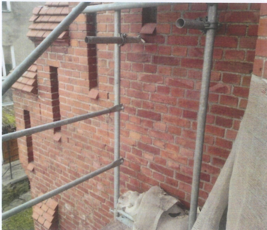
Fot. 15 i 16 (wyk. W. Tomaszewski): Widok stanu zachowania wybranych fragmentów wschodniej ściany szczytowej (od str. południowej). Widoczne są: braki kształtek ceramicznych, ich pęknięcia i uszczerbienia, zabrudzenia zaprawą murarską oraz patyna powstała z zanieczyszczeń atmosferycznych (sady kominowej). Wątki ceglane ścian pionowych w dobrym stanie zachowania. Całość zwarta i kompletna. Sporadycznie zdarzają się bardzo małe ubytki spoiny (szczeliny i odpryski).
