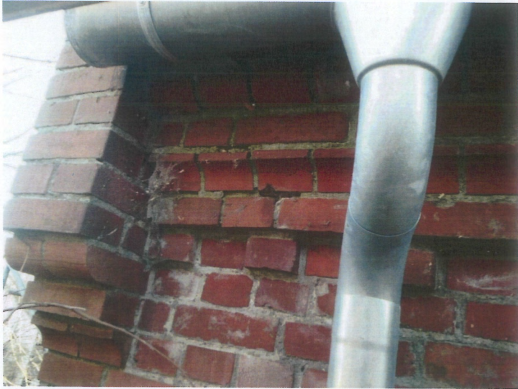
Fot. 52 i 53 (wyk. W. Tomaszewski): Widok stanu zachowania wątków ceglanych i kształtek ceramicznych na poziomie gzymsu koronującego. Wątki ceglane oraz kształtki ceramiczne są w dobrym stanie zachowania. Całość zwarta i kompletna. Sporadycznie zdarzają się bardzo małe ubytki spoiny (szczeliny i odpryski) oraz przebielenia powstałe z wyfukania zaprawy murarskiej (wysięki wapienne).
