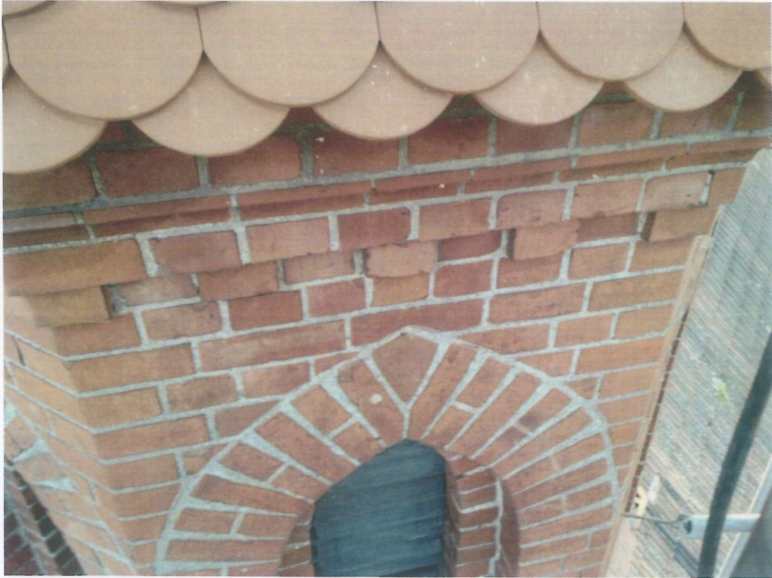
Fot. 10 i 11 (wyk. W. Tomaszewski): Widok stanu zachowania ścian wieży na poziomie gzymsu koronującego. Stan zachowania cegieł i spoin ocenia się jako dobry. Całość zwała i kompletna. Sporadycznie zdarzają się bardzo małe ubytki spoiny (szczeliny i odpryski).
