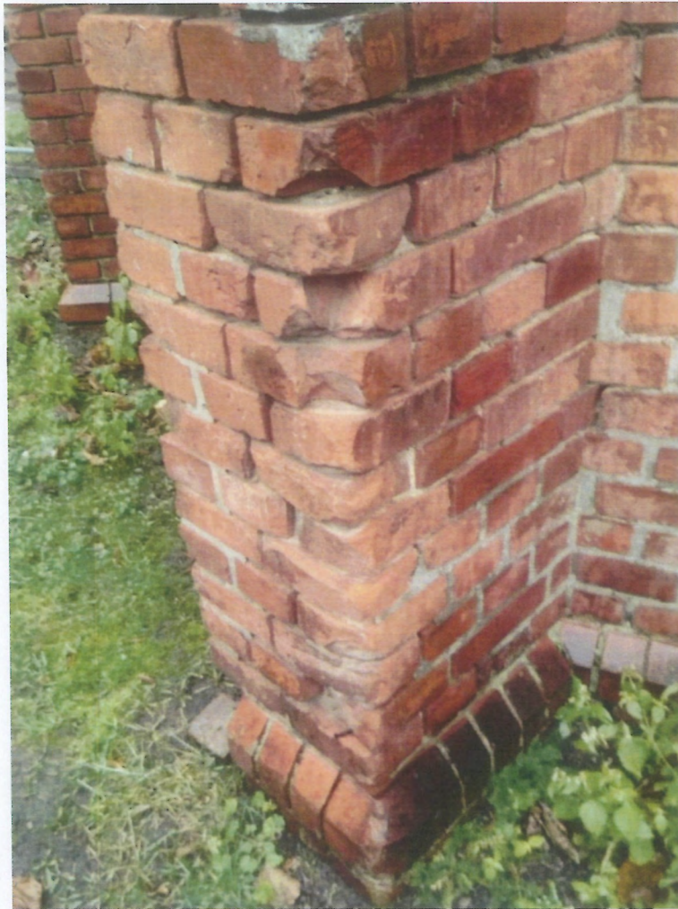
Fot. 46 i 47 (wyk. W. Tomaszewski): Widok stanu zachowania wybranych powierzchni ścian prezbiterium. Zauważa się utracenia narożników cegieł, ubytki odcinków zwietrzałych i wypłukanych spoin. Spotyka się braki pojedynczych cegieł oraz kształtek ceramicznych u podstawy.
