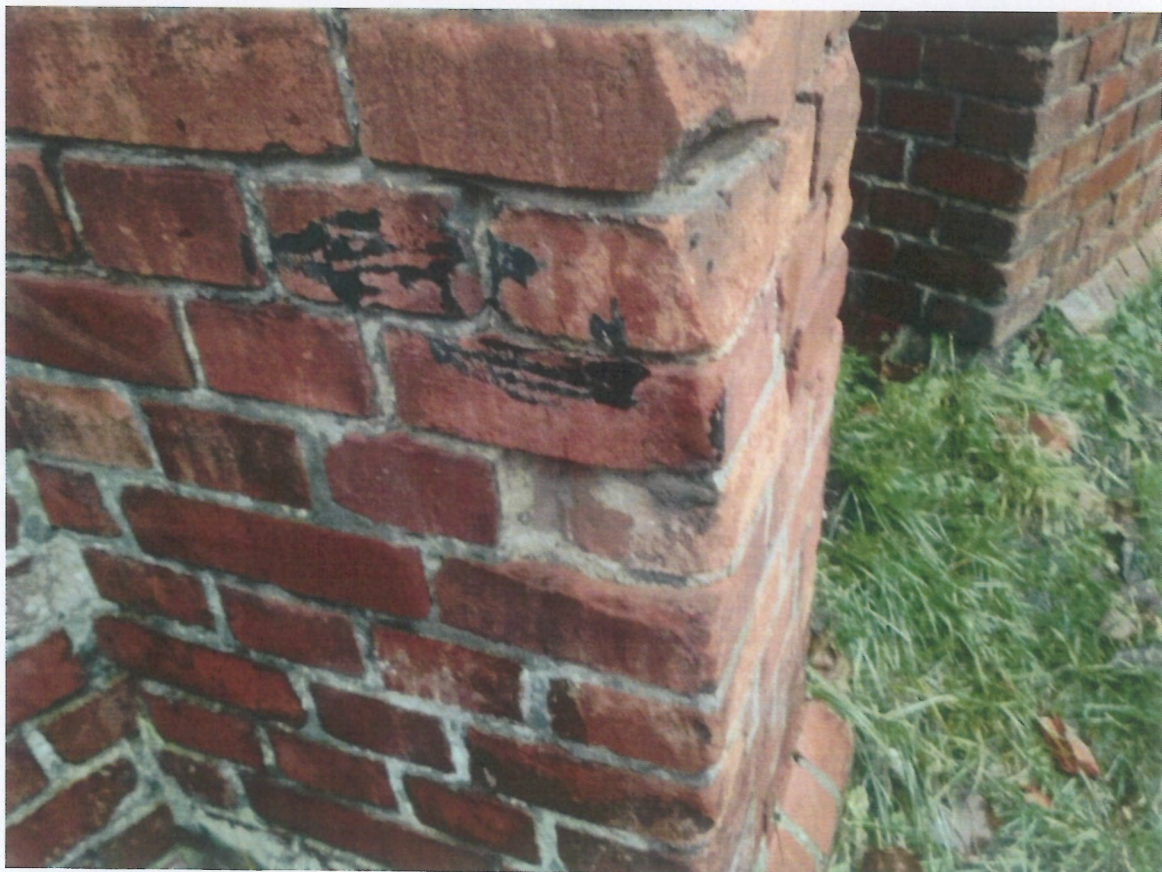
Fot. 44 i 45 (wyk. W. Tomaszewski): Widok stanu zachowania wybranych powierzchni ścian prezbiterium. Zauważa się utracenia narożników cegieł, ubytki odcinków zwietrzałych i wypłukanych spoin. Spotyka się braki pojedynczych cegieł oraz kształtek ceramicznych. Szkliwione kształtki ułożone na parapetach mają poutrącane krawędzie oraz powierzchniowe odpryski i zmatowienia szkliva. Obecne są również śladowe zabrudzenia smołą oraz akty wandalizmu w postaci graffiti.
