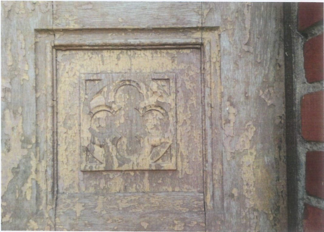
Fot. 67 i 68 (wyk. W. Tomaszewski): Widok stanu zachowania elementów dekoracji stolarsko – snycerskiej oraz warstw farby olejnej odspajającej się od podłoża drewnianego.
