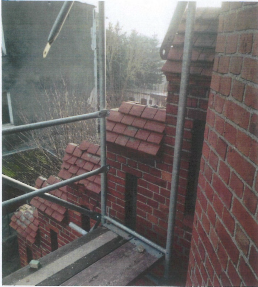
Fot. 15 i 16 (wyk. W. Tomaszewski): Widok stanu zachowania wybranych fragmentów wschodniej ściany szczytowej (od str. południowej). Widoczne są: braki kształtek ceramicznych, ich pęknięcia i uszczerbienia, zabrudzenia zaprawą murarską oraz patyna powstała z zanieczyszczeń atmosferycznych (sady kominowej). Wątki ceglane ścian pionowych w dobrym stanie zachowania. Całość zwarta i kompletna. Sporadycznie zdarzają się bardzo małe ubytki spoiny (szczeliny i odpryski).
