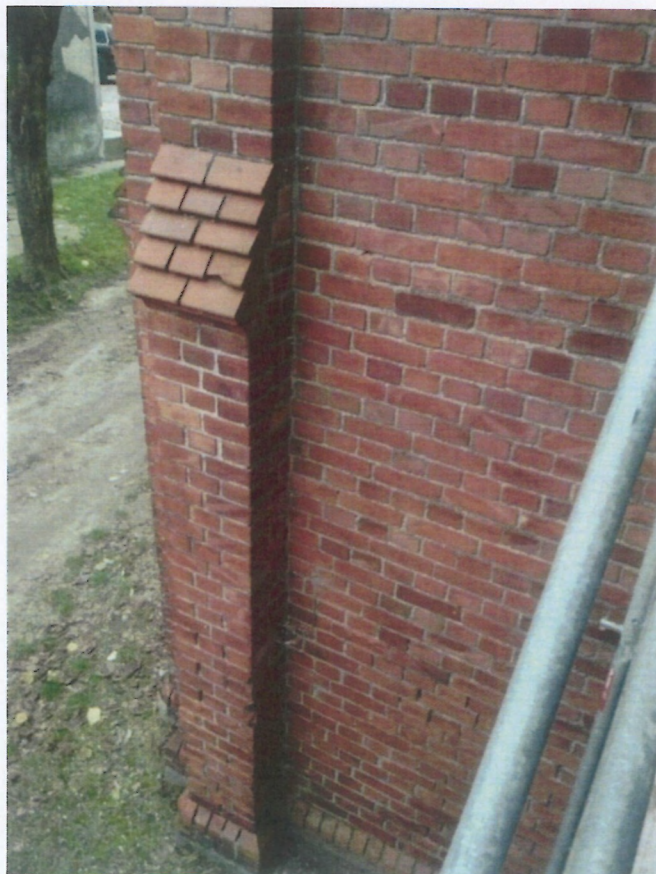
Fot. 17 i 18 (wyk. W. Tomaszewski): Widok stanu zachowania wybranych fragmentów wschodniej ściany szczytowej (od str. południowej). Wątki ceglane ścian pionowych w dobrym stanie zachowania. Całość zwarta i kompletna. Sporadycznie zdarzają się bardzo małe ubytki spoiny (szczeliny i odpryski) oraz przebielenia powstałe z wyptukania zaprawy murarskiej (wysięki wapienne).
