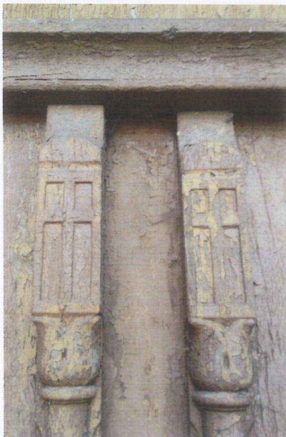
Fot. 65 i 66 (wyk. W. Tomaszewski): Widok stanu zachowania elementów dekoracji stolarsko – snycerskiej oraz warstw farby olejnej odpajającej się od podłoża drewnianego.
