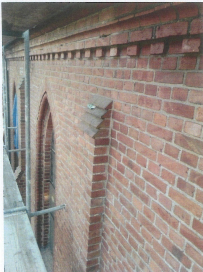
Fot. 56 i 57 (wyk. W. Tomaszewski): Widok stanu zachowania wątków ceglanych i kształtek ceramicznych na poziomie ostrołukowych wnęk okiennych elewacji północnej. Wątki ceglane oraz kształtki ceramiczne są w dobrym stanie zachowania. Całość zwarta i kompletna.
