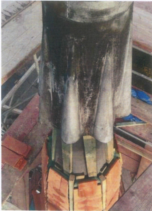
Fot. 4 i 5 (wyk. W. Tomaszewski): Widok metalowych części składowych wieńczących hełm wieży kościoła.
