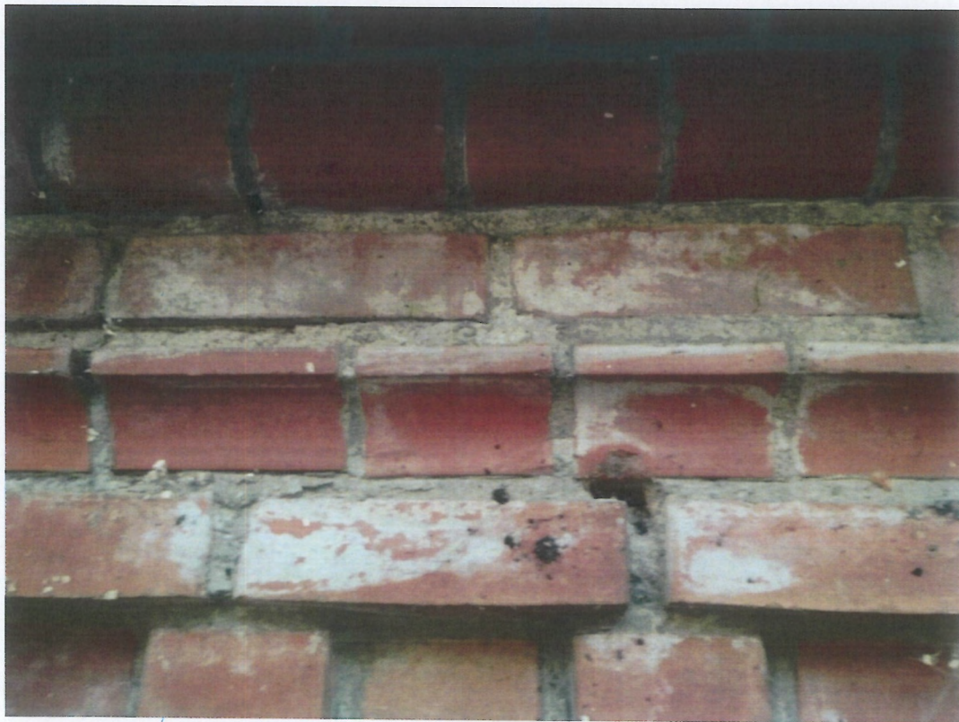
Fot. 52 i 53 (wyk. W. Tomaszewski): Widok stanu zachowania wątków ceglanych i kształtek ceramicznych na poziomie gzymsu koronującego. Wątki ceglane oraz kształtki ceramiczne są w dobrym stanie zachowania. Całość zwarta i kompletna. Sporadycznie zdarzają się bardzo małe ubytki spoiny (szczeliny i odpryski) oraz przebielenia powstałe z wyfukania zaprawy murarskiej (wysięki wapienne).
