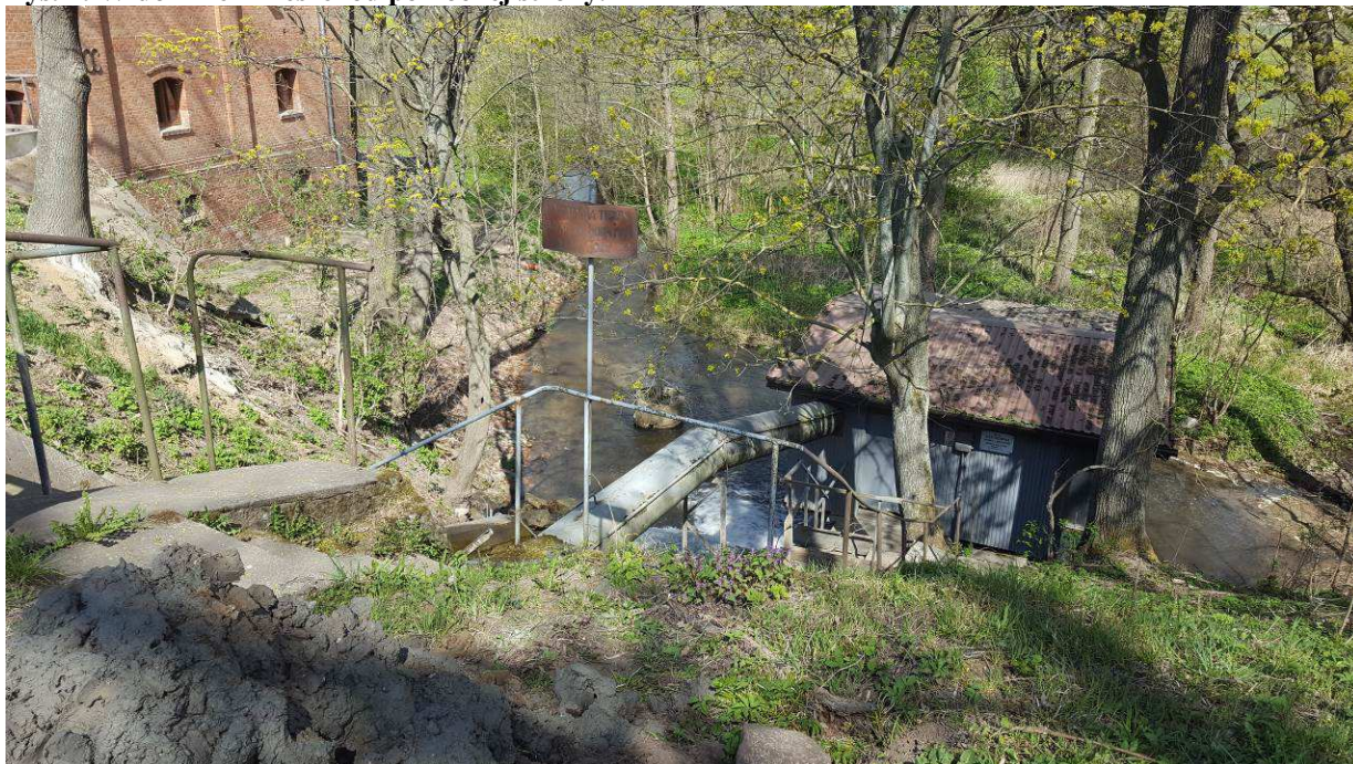
Rys. 4: Widok rzeki Reszel od północnej strony.
