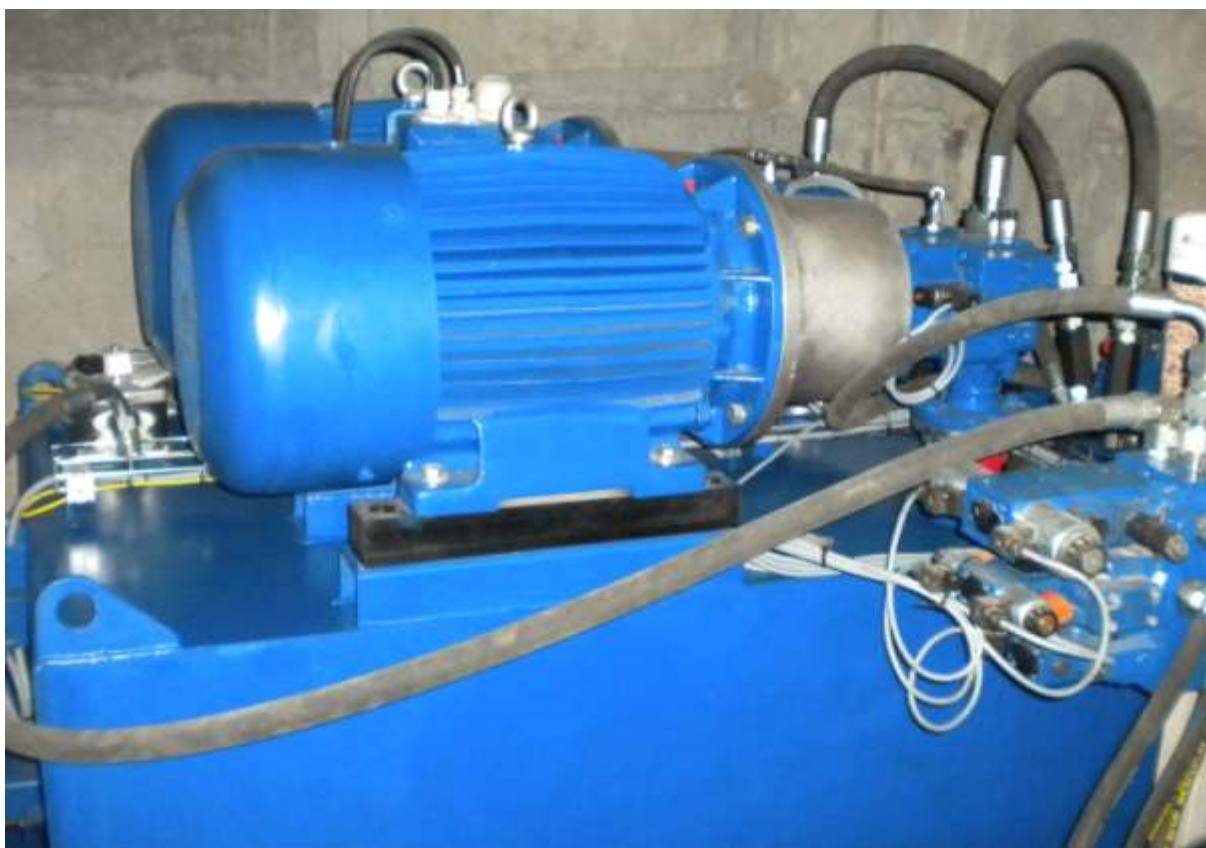
I.2.2_Agregat hydrauliczny z podwójnym zespołem pompowym
