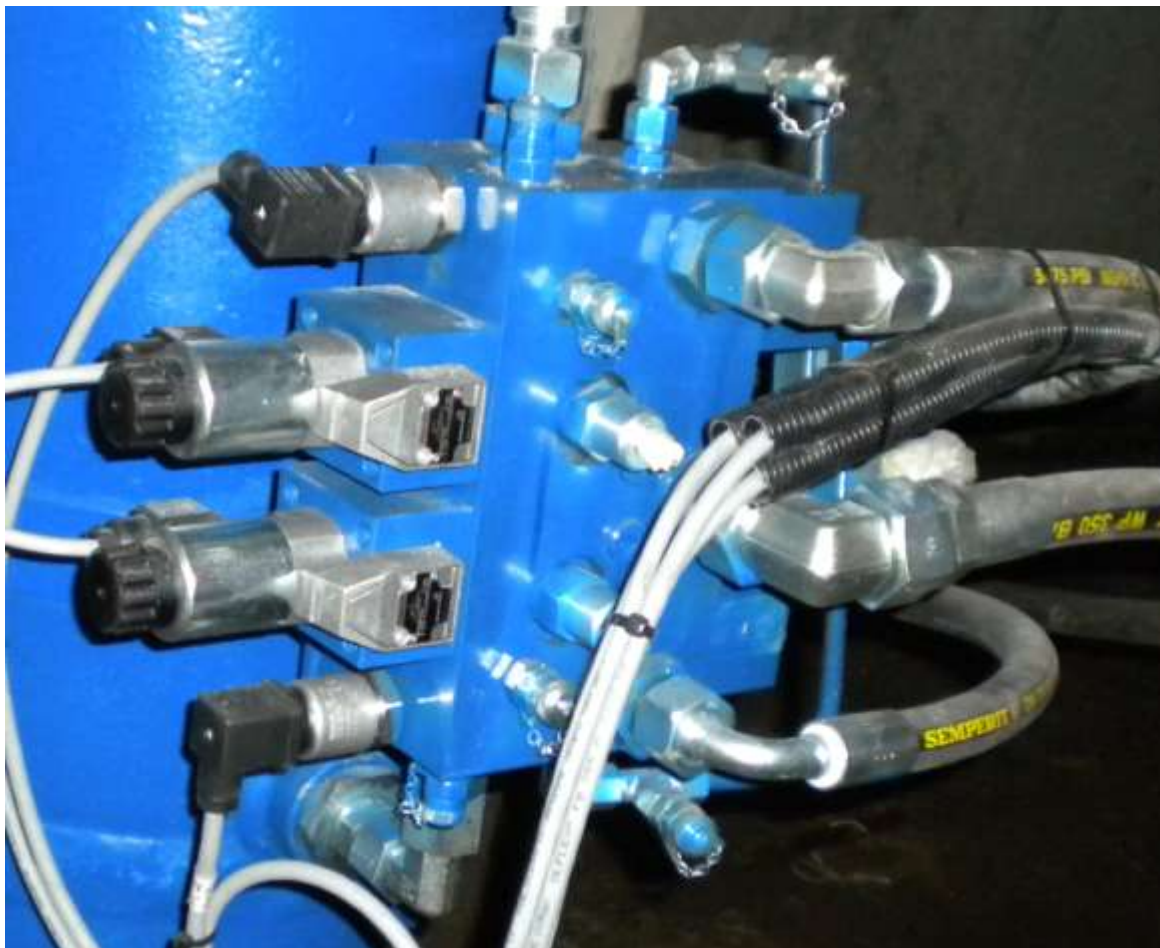
I.2.1_Blok zaworowy IV na siłowniku Ø320/180x1550
