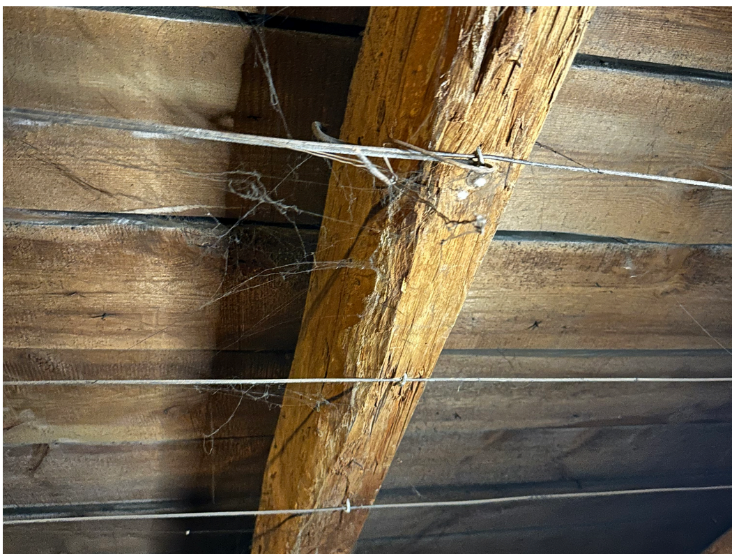
krokiew wraz z deskowaniem i prześwitującym pokryciem z papy
