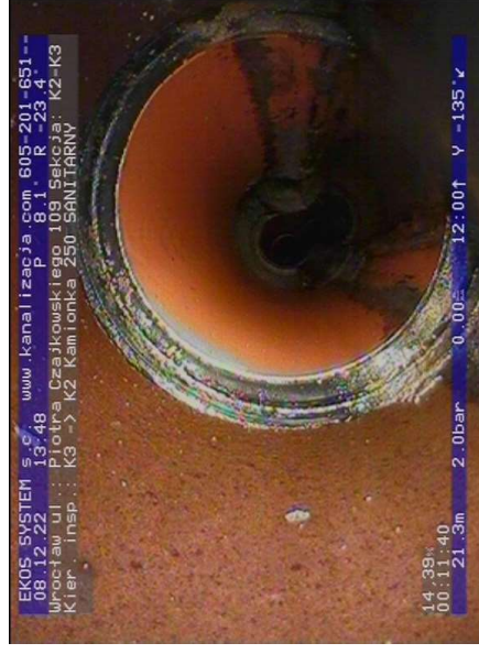
K2-K3-foto_nr-057.jpg, 00:11:40, 21,35 m Zmiana materiału: PVC
