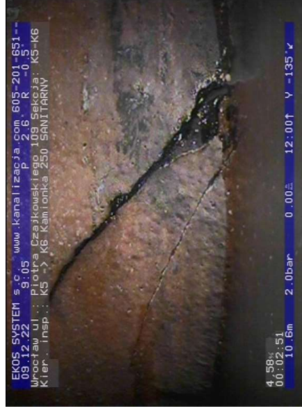
K5-K6-foto_nr-068.jpg, 00:02:52, 10.64 m Złamanie złożone - wyraźne otwarcie ścian przewodu, fragmenty obecne na swoim miejscu, szer.: 1mm od 1 godz. do 6 godz., Początek obserwacji
