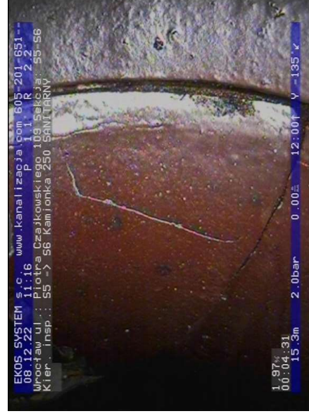
S5-S6-foto_nr-023.jpg, 00:04:31, 15.36 m Złamanie obwodowe - wyraźne otwarcie ścian przewodu, fragmenty obecne na swoim miejscu, szer.: 1mm od 1 godz. do 5 godz.
