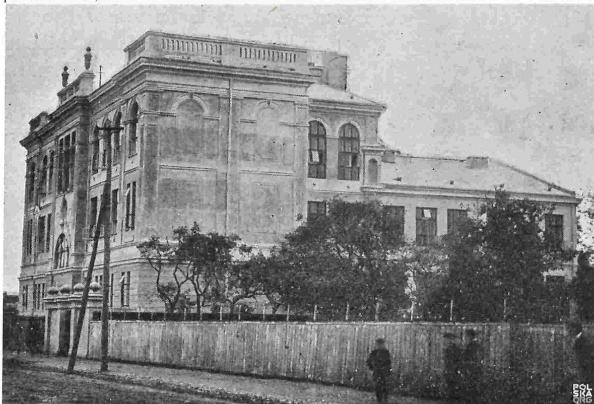
Budynek szkoły ok. 1920 roku. Widok od strony północno-zachodniej. Zauważalny monochromatyczny kolor tynku z cementu romańskiego, który położono na elewacjach szkoły. Brak podziałów detal, tło.
