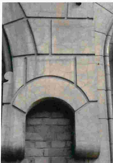
Fot. 1. Przykład tynku z cementu romańskiego o lekko spękanej powierzchni i kolorze przypominającym kamień naturalny.
