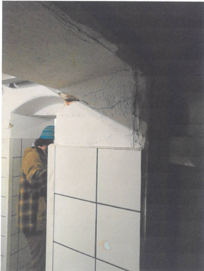
4. Przedśionek przed wejściem do siłowni (widok w kier. południowo-wsch.)
