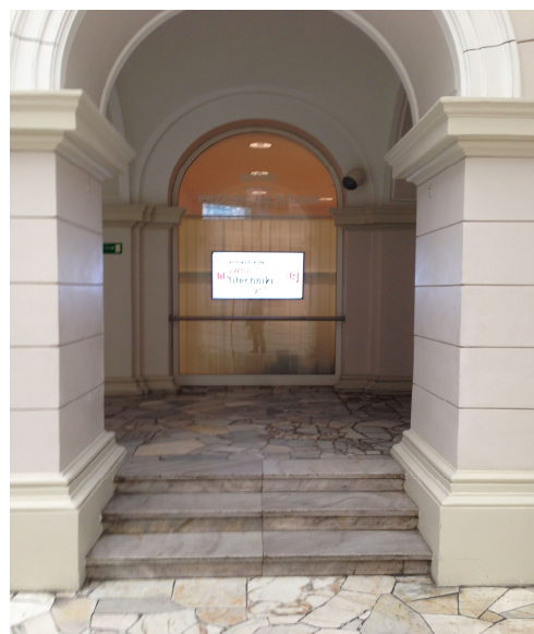
Przeszklenia szkłem bez odporności ogniowej pomieszczenia księgarni i biura- od strony Dużej Auli.
