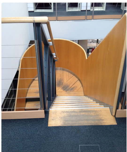
Schody wewnętrzne (dodatkowe) biblioteki, z antresoli na II i III piętro – stalowe.
