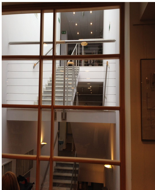
Schody wewnętrzne główne biblioteki (II piętro-Antresola- III piętro) – żelbetowe.
