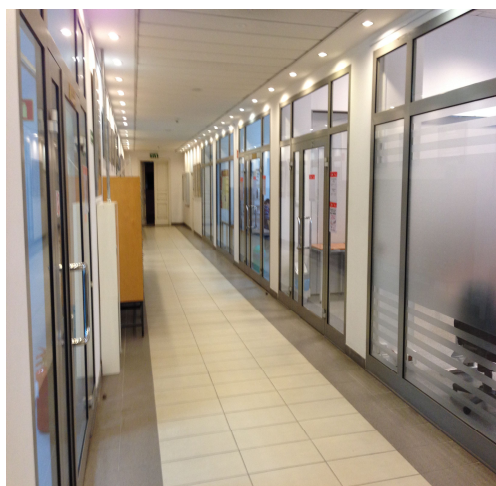
Przeszklenia szkłem bez odporności ogniowej korytarzy biblioteki na parterze i I piętrze.
