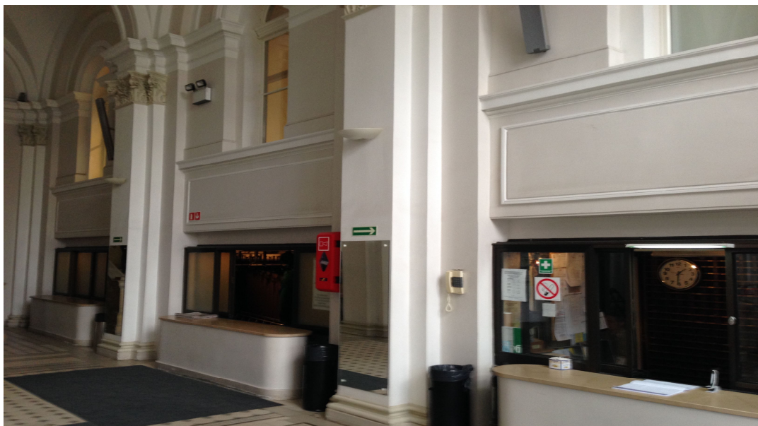
Przeszklenia szkłem bez odporności ogniowej pomieszczenia szatni i biur w holu wyjściowym z Dużej Auli.
