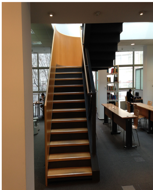
Schody wewnętrzne (dodatkowe) biblioteki, z antresoli na II i III piętro – stalowe.
