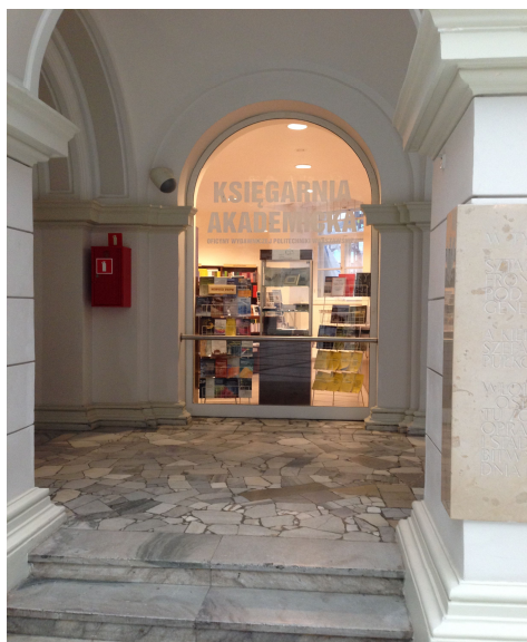
Przeszklenia szkłem bez odporności ogniowej pomieszczenia księgarni i biura- od strony Dużej Auli.
