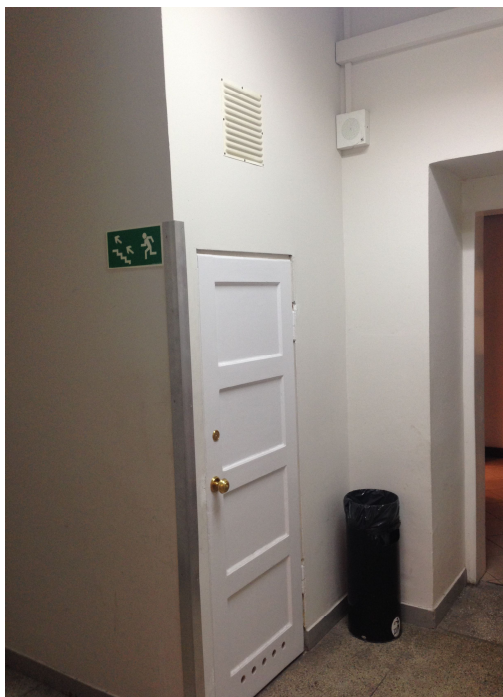
Pomieszczenia gospodarcze pod biegami klatek schodowych A i C – drzwi i kratki wentylacyjne, bez odporności ogniowej.
