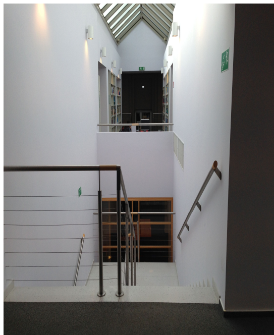
Schody wewnętrzne główne biblioteki (II piętro-Antresola- III piętro) – żelbetowe.
