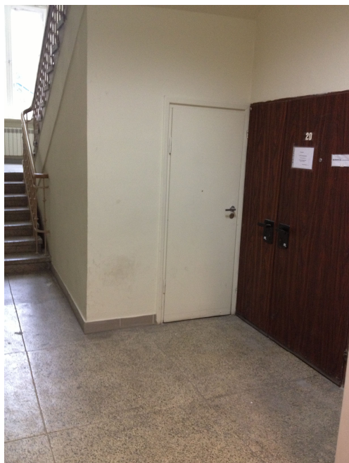
Pomieszczenia techniczne i gospodarcze na parterze klatki schodowej B – drzwi bezklasowe.
