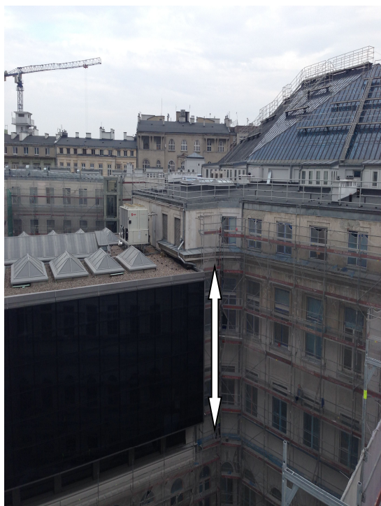
Okna bezklasowe na projektowanej granicy strefy pożarowej Biblioteki Głównej - okna z dwóch stron budynku.
