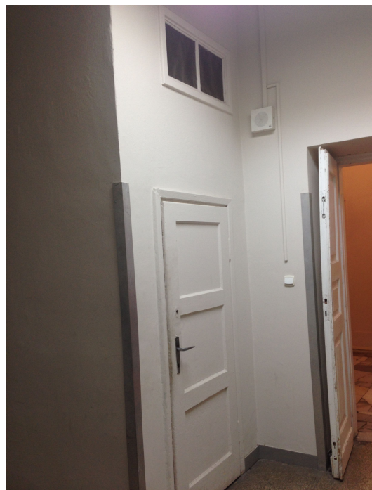
Pomieszczenia gospodarcze pod biegami klatek schodowych A i C – drzwi i kratki wentylacyjne, bez odporności ogniowej.
