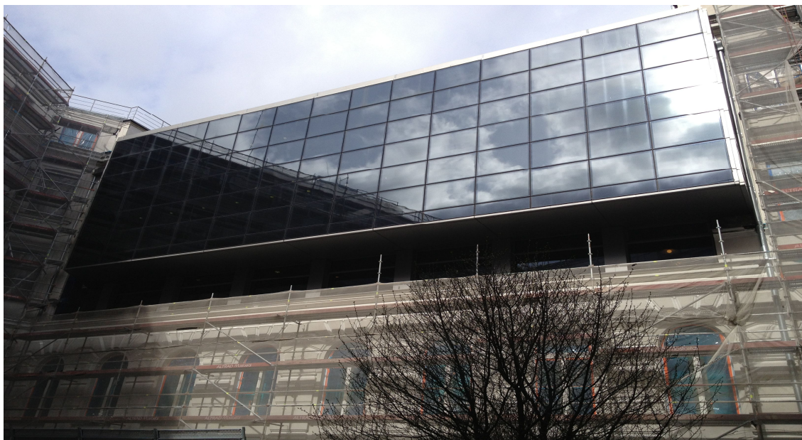
Nadbudowa Biblioteki Głównej – ściana osłonowa przeszklona w systemie SCHUCO II piętro ,Antresola, III piętro.
