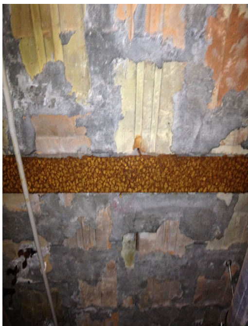
Skorodowane, nie zabezpieczone belki stalowe stropu podziemia.
