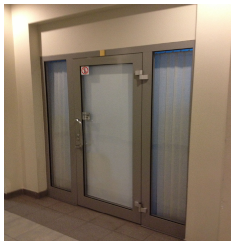
Przeszklenia szkłem bez odporności ogniowej korytarzy biblioteki na parterze i I piętrze.
