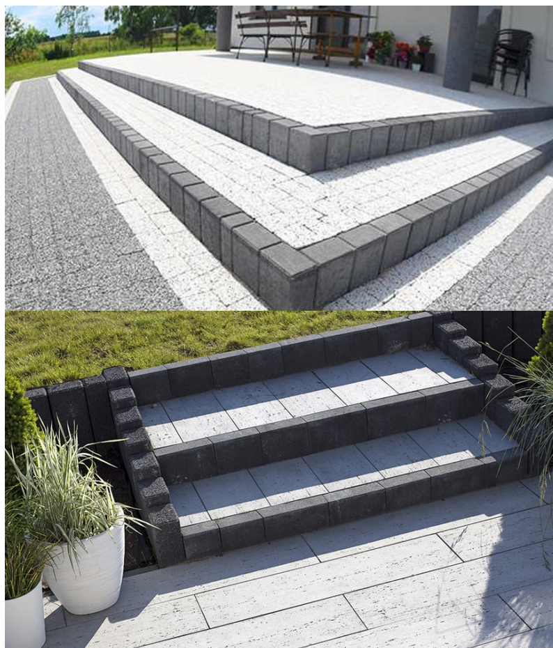
Fotografia nr 8 – palisady (sposób wykonania podstopnicy schodów terenowych)
