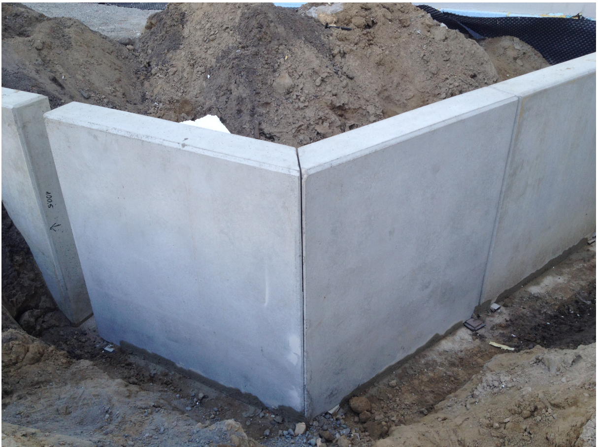
Fotografia nr 5 – mury oporowe, strona zewnętrzna licowa gładka, ręcznie zacierana
