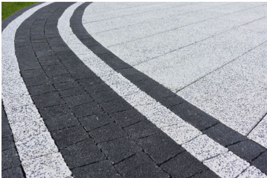
Fotografia nr 2 - bezfazowa kostka betonowa, trapezowa, płukana gr. 6cm (zastosowana do wyrobienia łuków poziomych)
