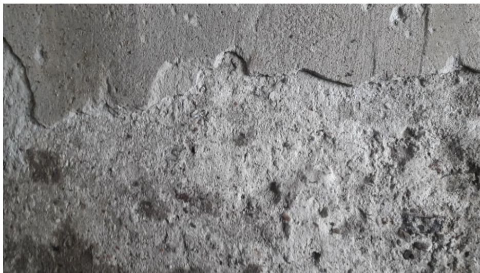
Fot.2: Przykładowe miejsca korozji powierzchniowej betonu
