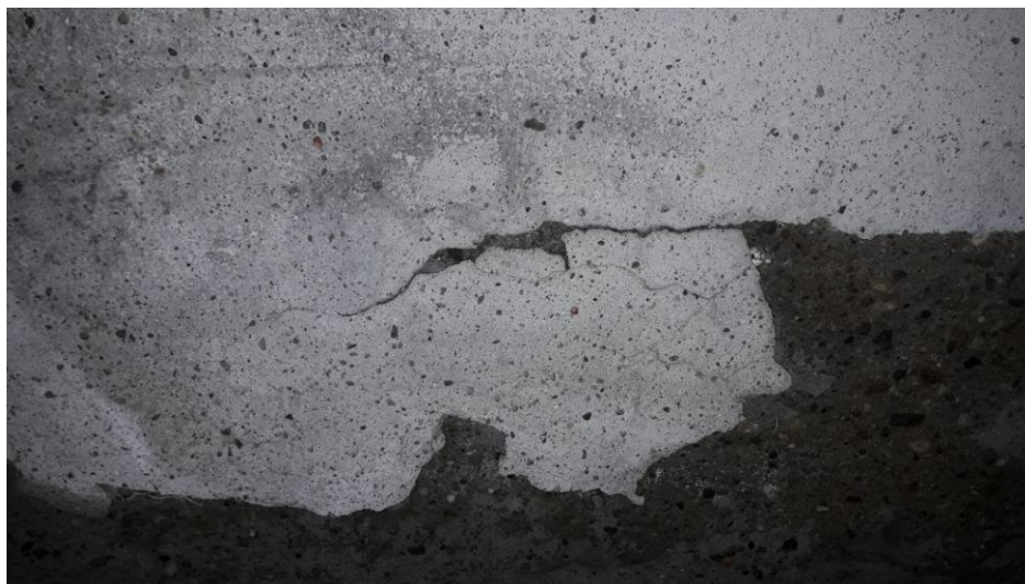
Fot.5: Przykładowe miejsca uszkodzenia napraw powierzchniowych
