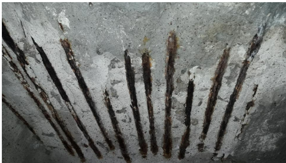
Fot.1: Przykładowe miejsca korozji stali zbrojeniowej
