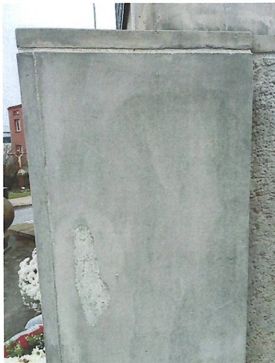
Fot. 9. Widoczne na fotografii: Widok na fragment podstawy z płytą pionową od strony północno-wschodniej odwarstwienia warstwy kamiennej, zabrudzenia wierzchnie.
