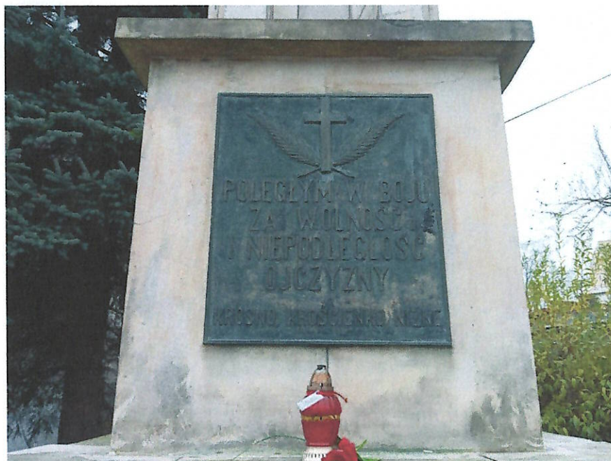
Fot. 3. Widoczne na fotografii: widok na tablicę inskrypcyjną umieszczoną na cokole od strony poł.-wsch. pomnika, widoczne odbarwienia powierzchni.
