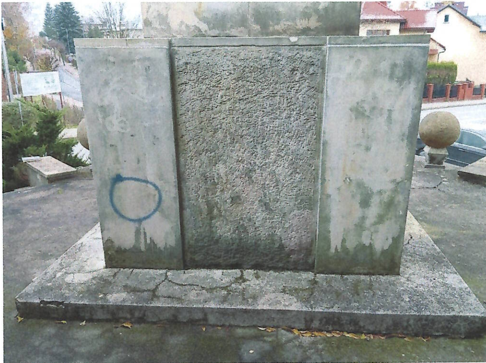
Fot. 16. Widoczne na fotografii: Tył pomnika, od strony północno-zachodniej, układ płyt na podstawie, zniszczenia mechaniczne, zielonkawe odbarwienia biologiczne, uszkodzenia betonowej opaski, spękania.
