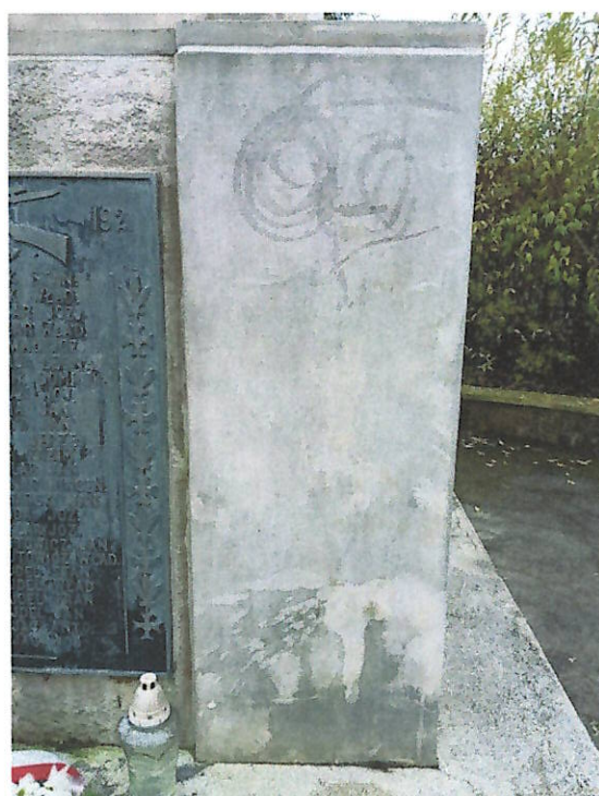
Fot. 10. Widoczne na fotografii: widok z przodu na fragmencie podstawy z płytą, widoczne zabrudzenia mechaniczne oraz biologiczne.
