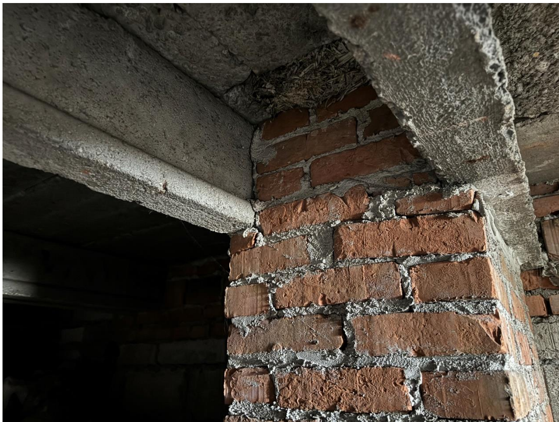
Fot.7. Rozstaw belek okalających kominy.
