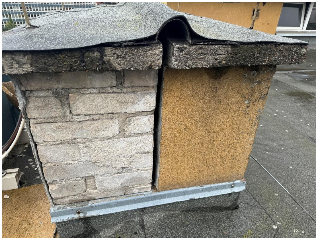
Fot.3. Zły stan techniczny wypraw elewacyjnych kominów.
