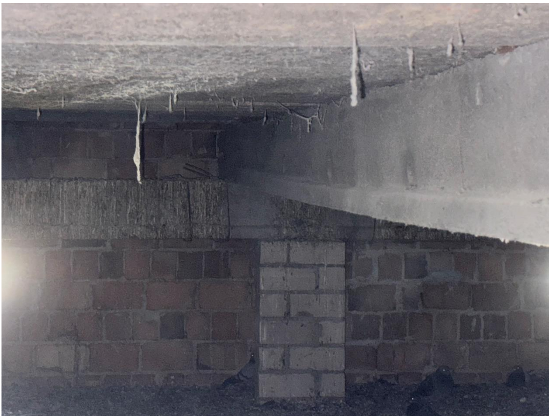
Fot. 13. Zbliżenie na miejsce oparcia belek dachu bloku A.
