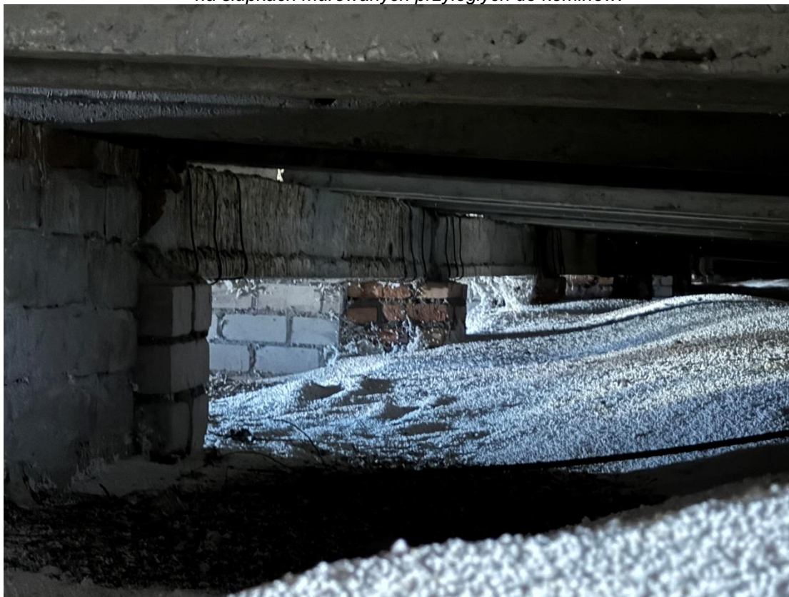
Fot.9. Widoczny układ belek poprzecznych opartych na belce podłużnej. Belka podłużna oparta na słupkach murowanych przyległych do kominów.
