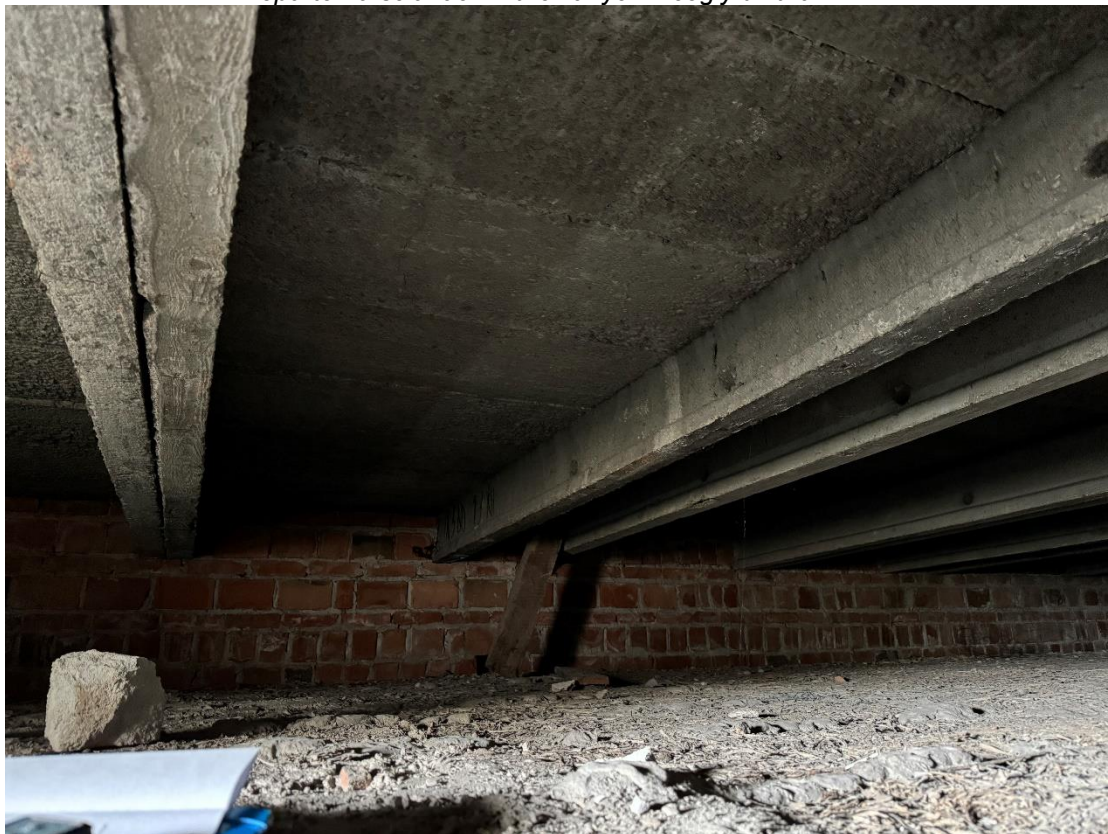
Fot.7. Rozstaw belek okalających kominy.
