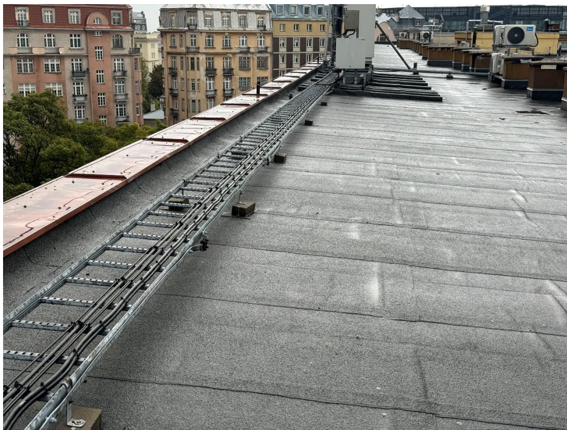
Fot.1. Widok połąci dachowej na bloku S1.
