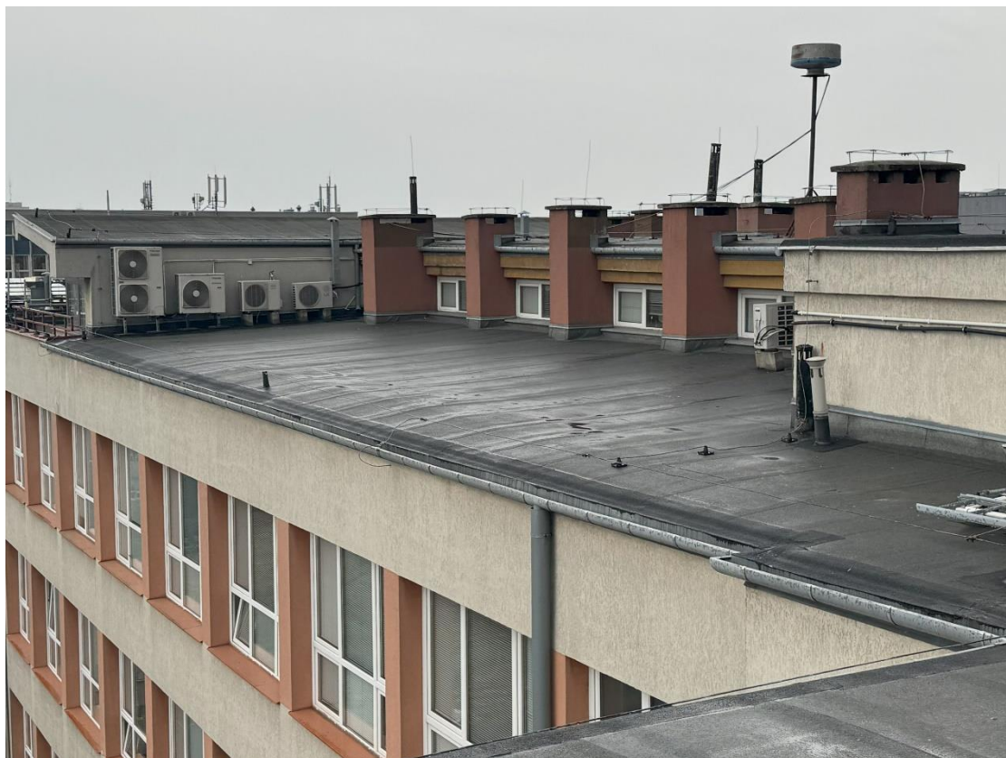
Fot.3. Zły stan techniczny wypraw elewacyjnych kominów.
