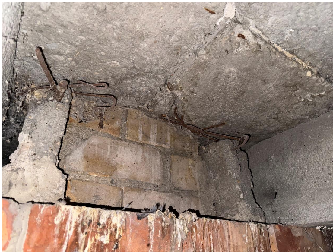
Fot. 11. Belki okalające komin oparte na murowanej ścianie kolankowej.
