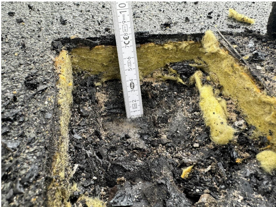
Fot.5. Przekrój warstw pokrycia dachowego. Odkrywka na dachu bloku S1.
