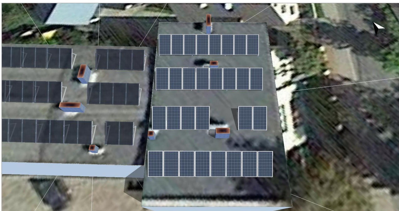
Ilustracja: 3. Powierzchnię modułu - Budynek 03-Powierzchnia dachu Południowy-Wschód
