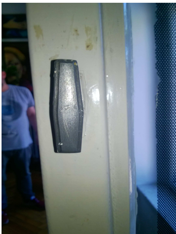
Klamka metalowa ocynkowana – dwuramienna – w oknach wymienianych w XX wieku
