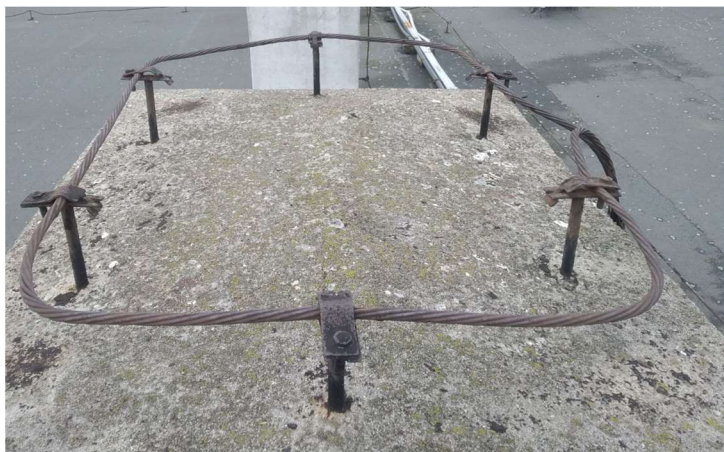
Rys. 3.1. Widok fragmentów dachu budynku A ze wskazaniem istniejących zwodów do ochrony nadbudówek (kominków wentylacyjnych)..
