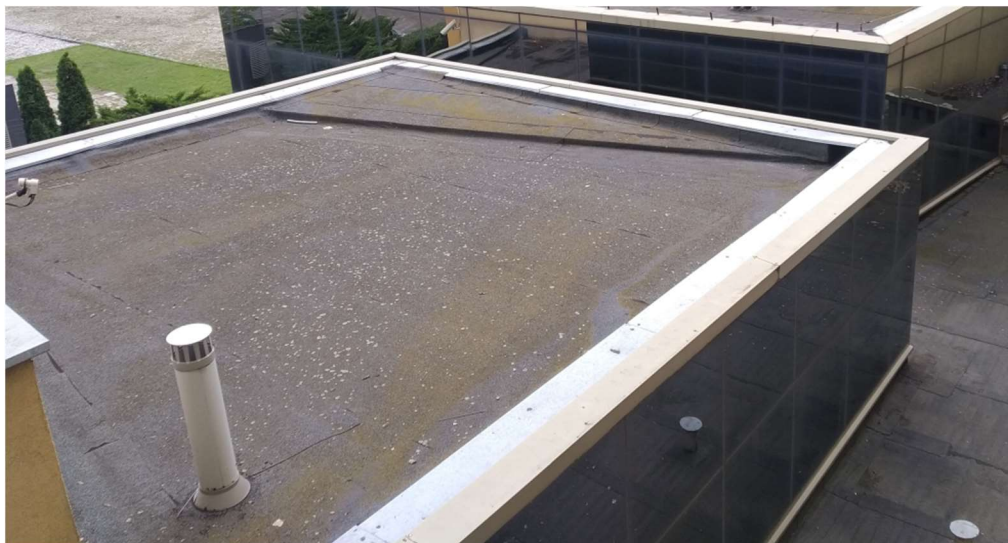
Rys. 3.6. Widok fragmentów dachu budynku C ze wskazaniem istniejącego dachu bez zwodów pełniących rolę ochrony odgromowej..
