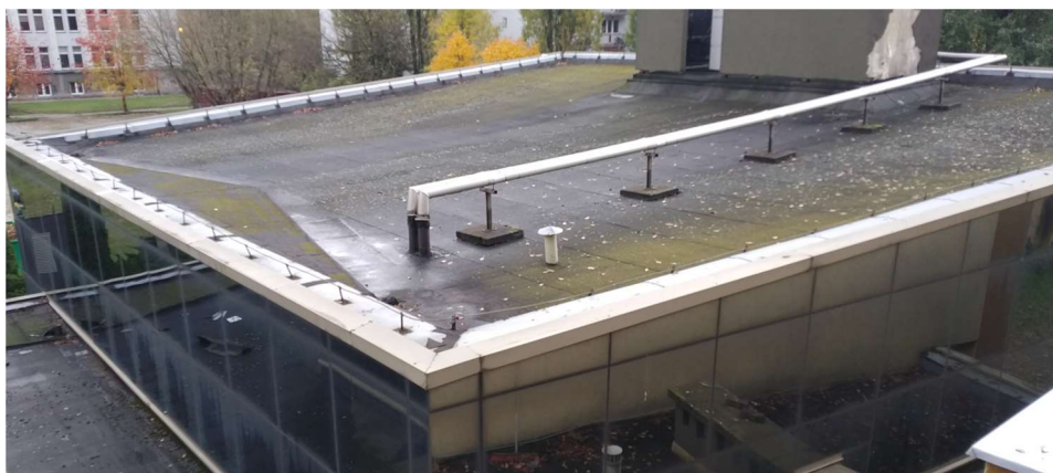
Rys. 3.4. Widok fragmentów dachu budynku C ze wskazaniem istniejących zwodów poziomych niskich.
