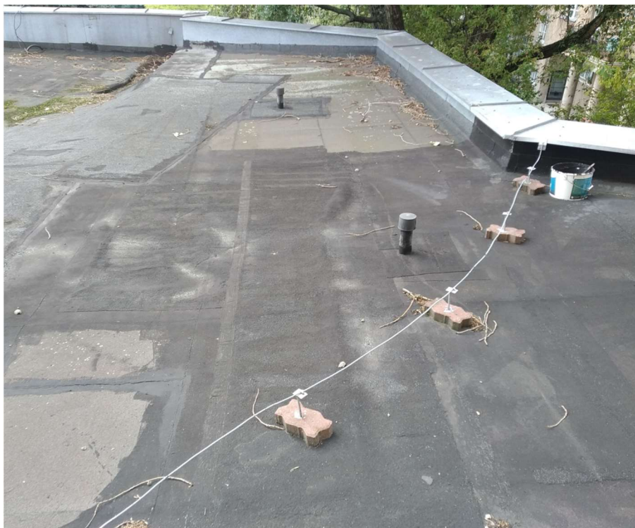
Rys. 3.5. Widok fragmentów dachu budynku C ze wskazaniem istniejące połączenia obróbki metalowej dachu ze zwodem poziomym niskim..
