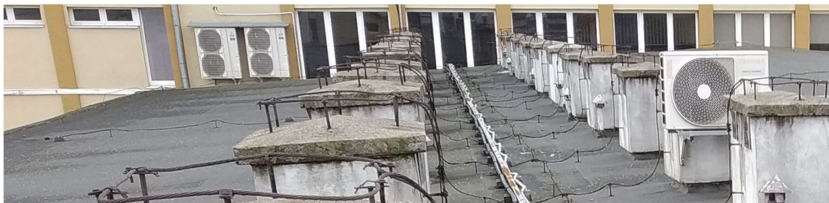
Rys. 3.3. Widok fragmentów dachu budynku A ze wskazaniem istniejących podpór dla zwodów poziomych niskich.
