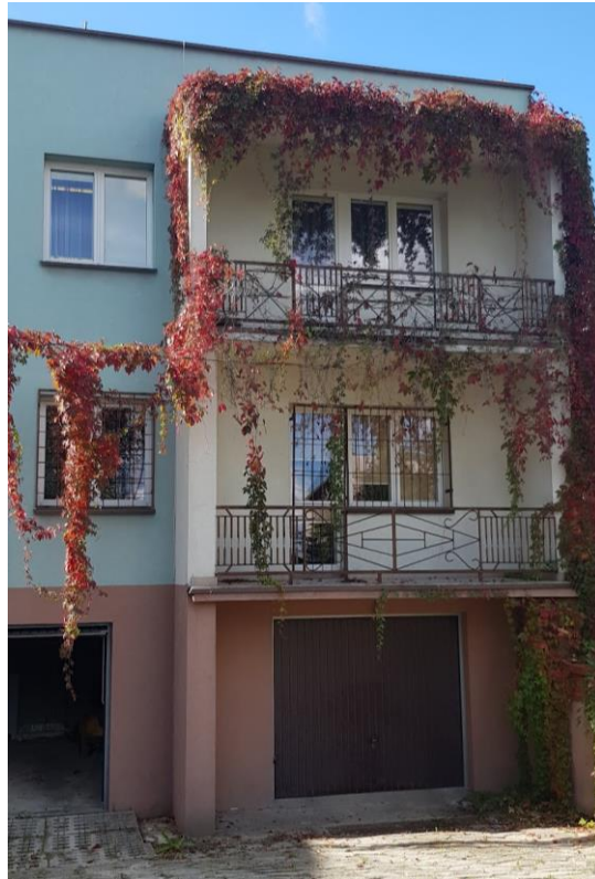
Fot. nr 4. Widok fragmentu elewacji wschodniej
