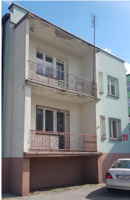
Fot. nr 2. Widok elewacji zachodniej
