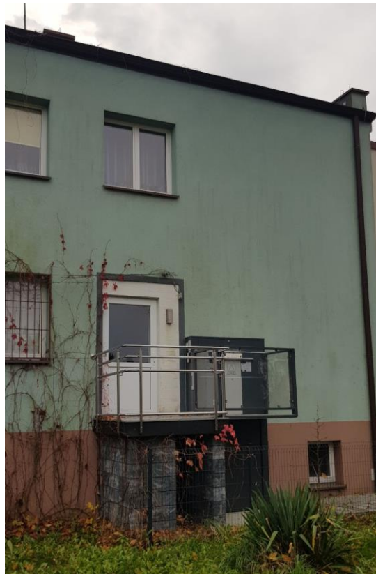
Fot. nr 3. Widok fragmentu elewacji północnej
