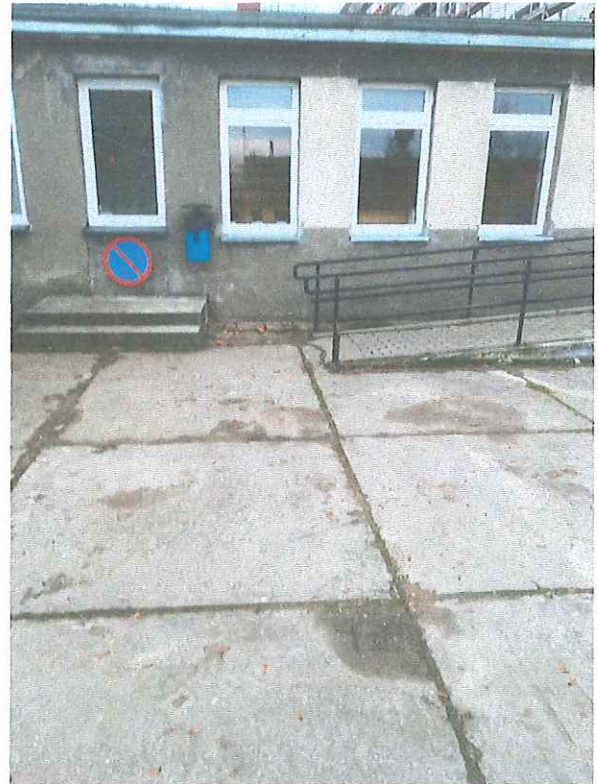
Zdjęcie nr 7, 8 Nawierzchnia z betonowych płyt – brak zorganizowanego odwodnienia
