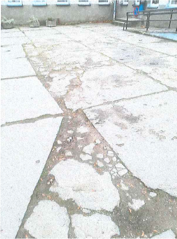
Zdjęcie nr 7, 8 Nawierzchnia z betonowych płyt – brak zorganizowanego odwodnienia
