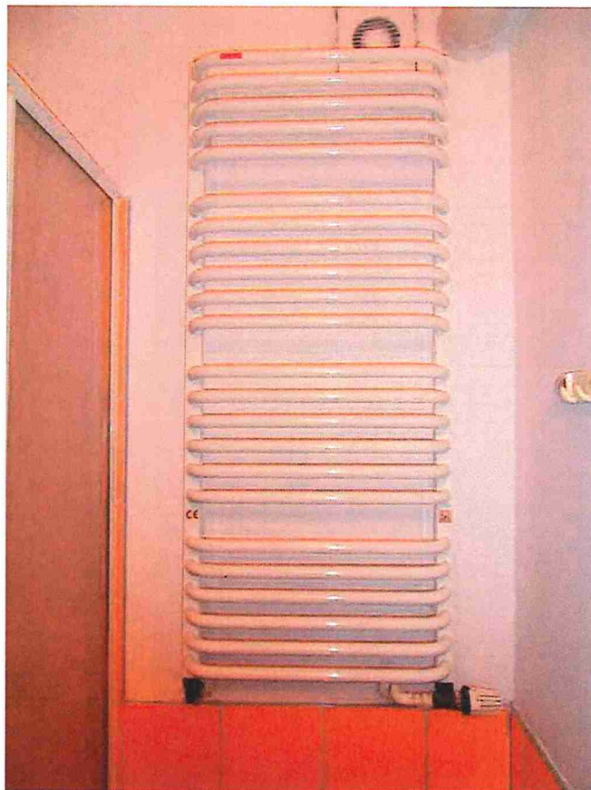
Fot. 4. Stan istniejący – widok na grzejnik
