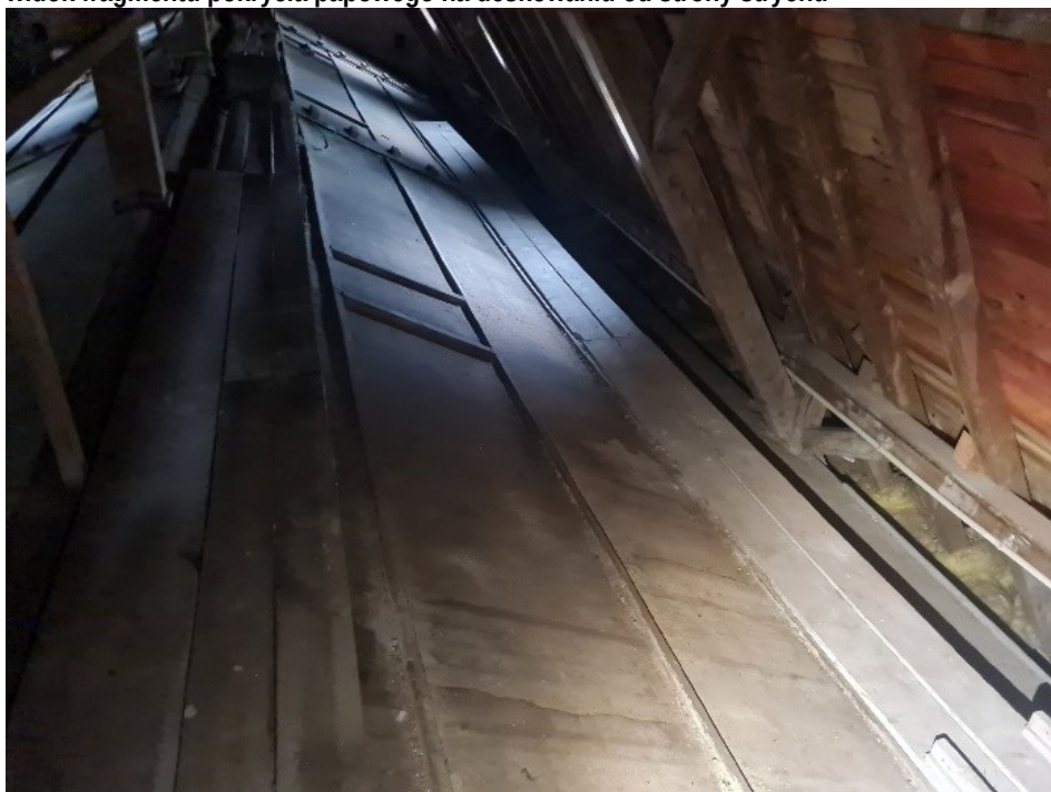
widok fragmentu pokrycia papowego na deskowaniu od strony strychu
