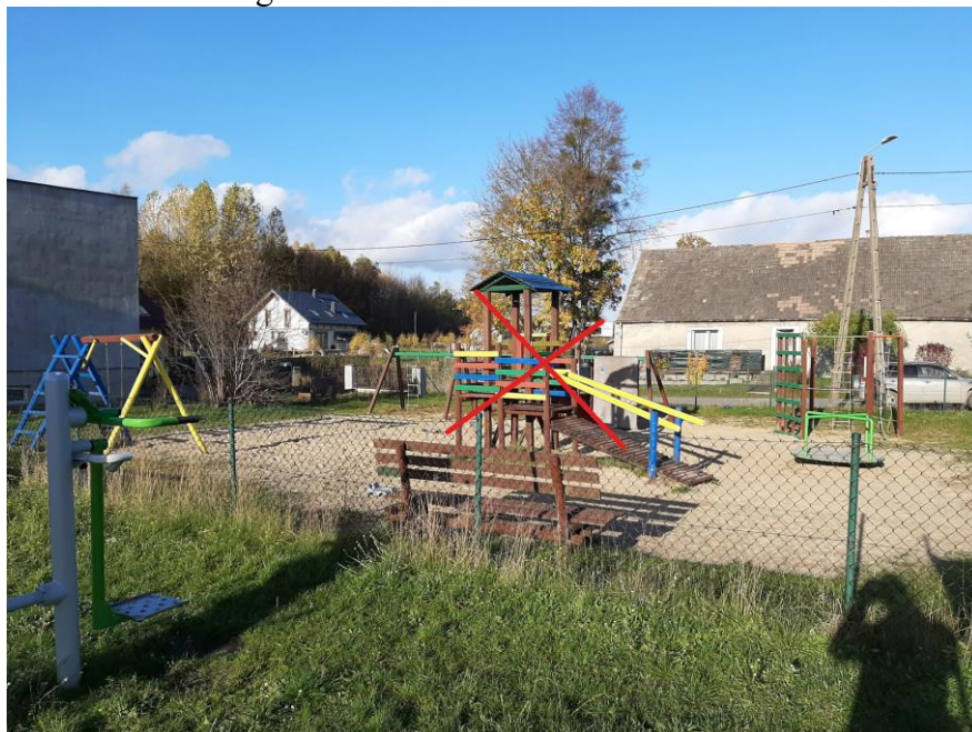
Urządzenie przeznaczone do rozbiórki
