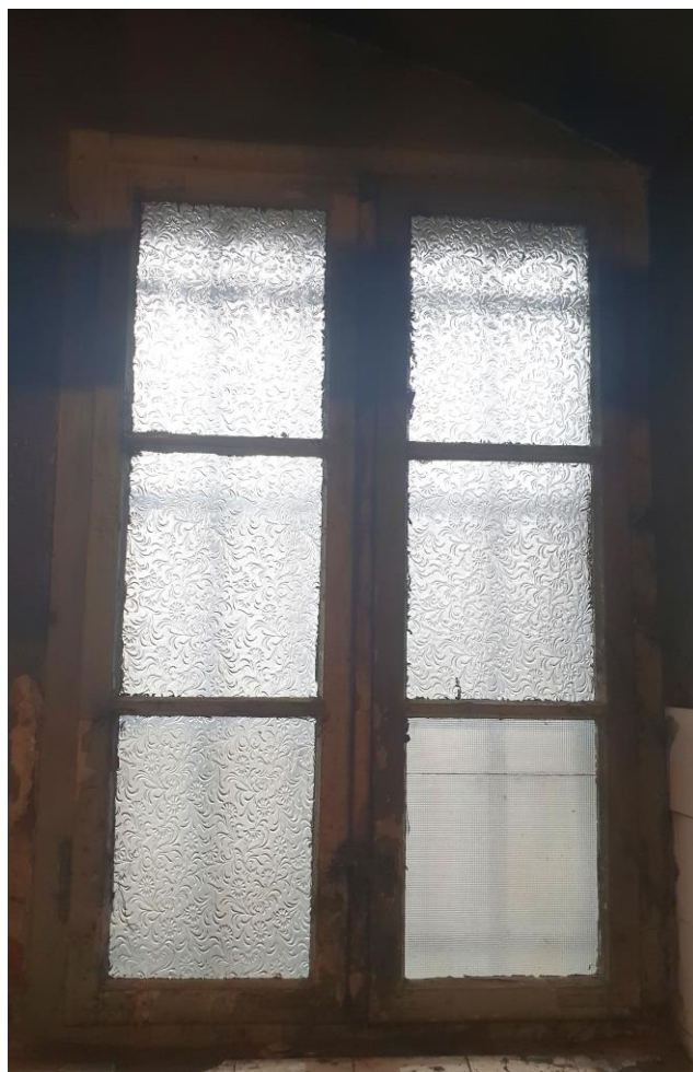
Zdjęcie nr 89 okno jednoramowe szklone szybami ornamentowymi
