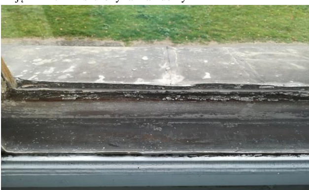
Zdjęcie nr 73 widok zniszczonego okna szczególnie w części dolnej
