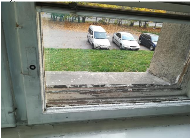
Zdjęcie nr 69 widok całkowicie zniszczonego ramiaka
