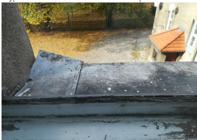
Zdjęcie nr 68 widok zniszczonego ramiaka dolnego i płachy
