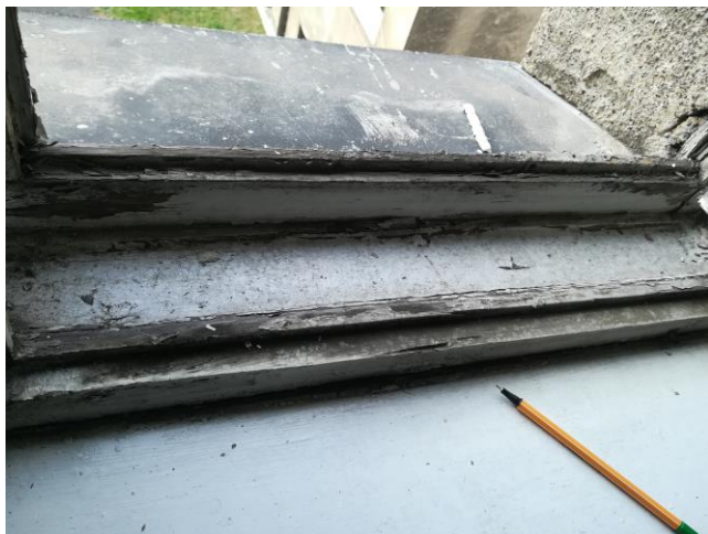
Zdjęcie nr 74 i 75 widok okna z zniszczonym ramiakiem dolnym i okapnikiem
