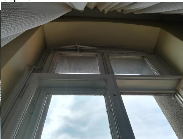
Zdjęcie 76 widok zniszczonego okna szczególnie w części dolnej Zdjęcie nr 77 brak górnych skrzydeł okiennych
