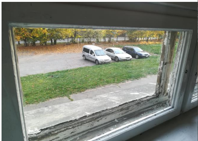
Zdjęcie 76 widok zniszczonego okna szczególnie w części dolnej Zdjęcie nr 77 brak górnych skrzydeł okiennych
