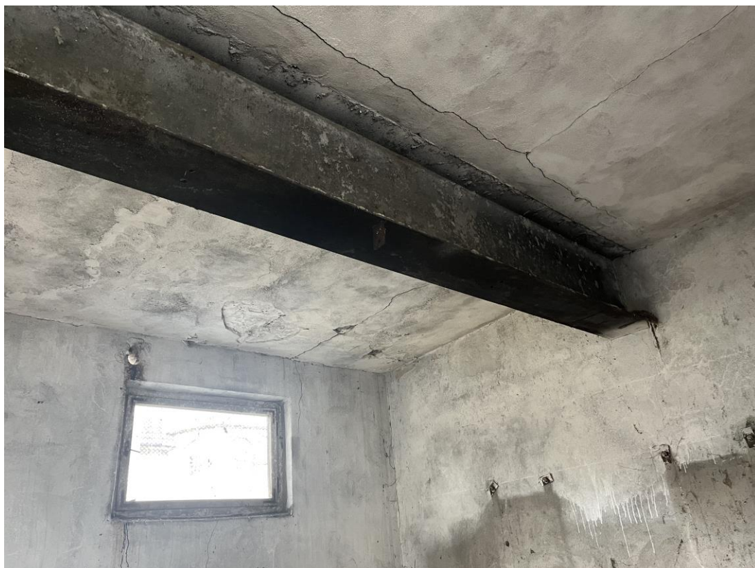
Widok na podciąg dwuteownikowy o wymiarach 50x35 cm
