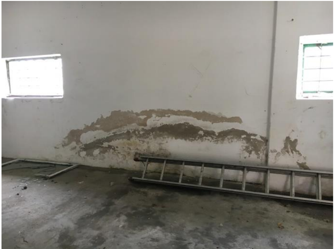
Fot. 13 zawilgocenie cian parteru
