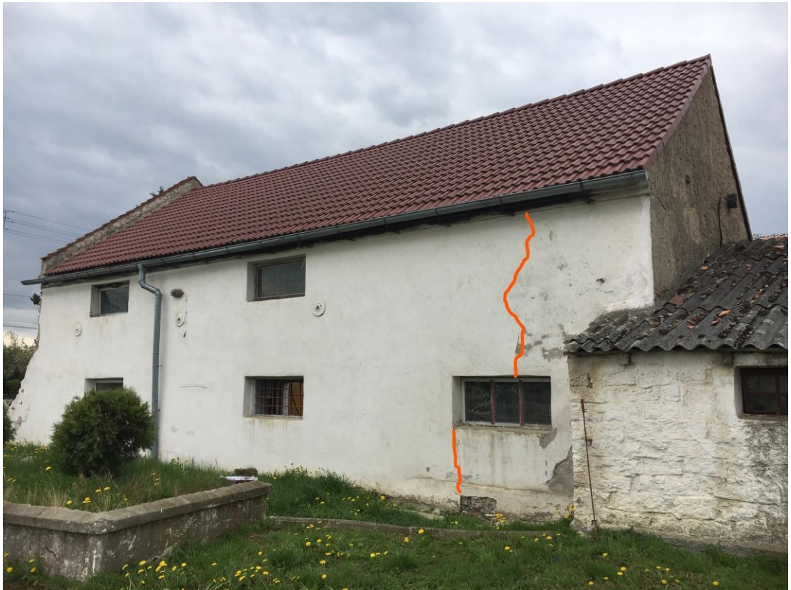
Fot. 7 zarysowania na cianie wschodniej
