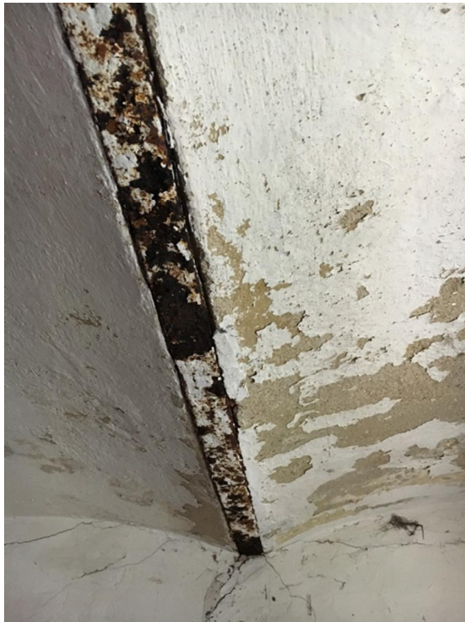
Fot. 17 Korozja belek stropowych
