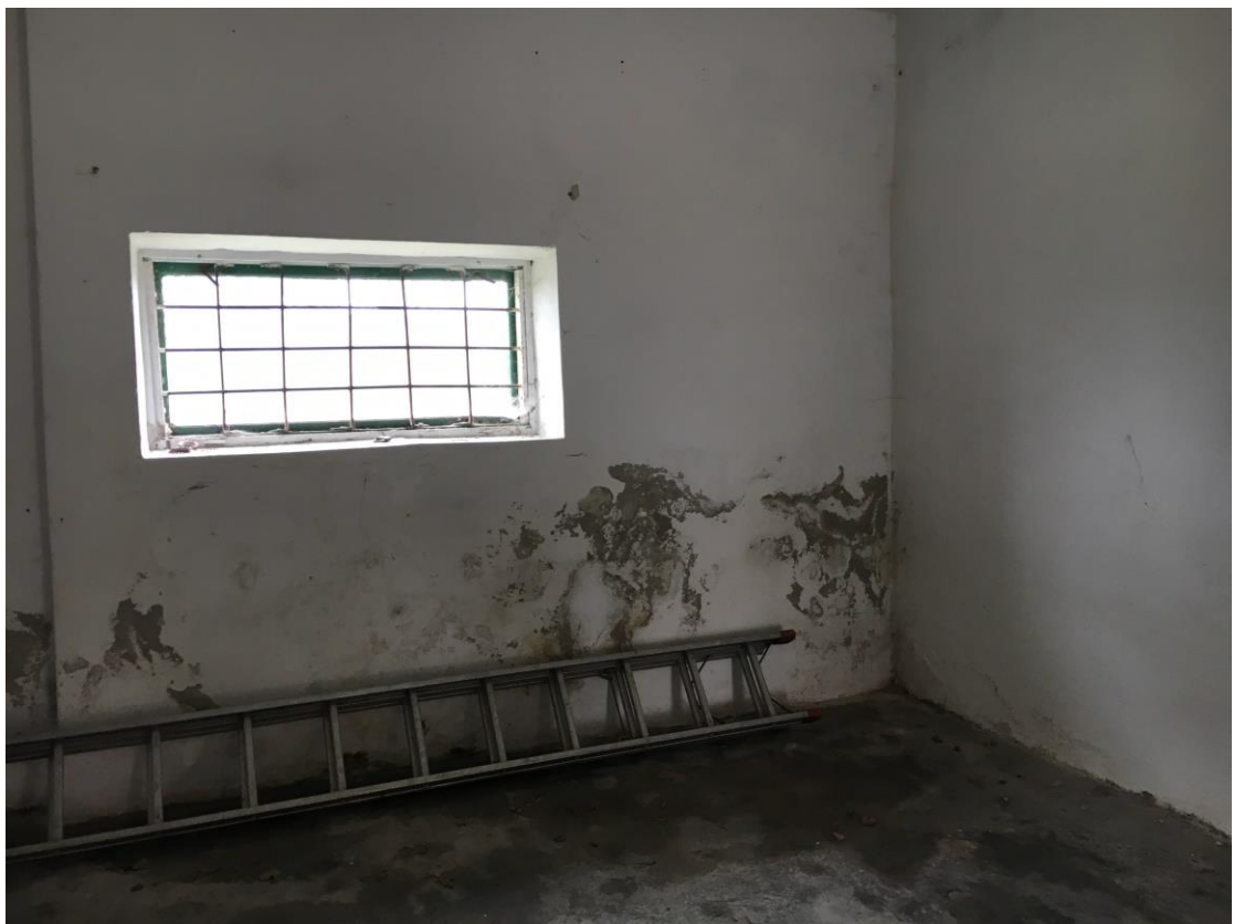
Fot. 14 Zawilgocenie cian parteru
