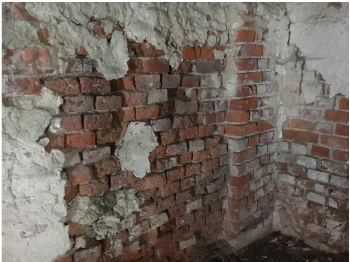
Fot. 10 zniszczenia spoin i cegieł ciany szczytowej północnej na poddaszu
