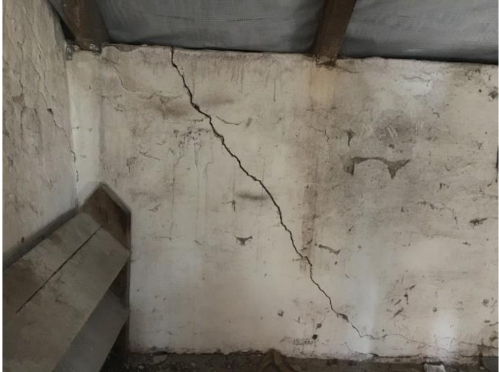
Fot. 11 Pęknięcie ściany kolankowej przy szczycie południowym na ścianie zachodniej
