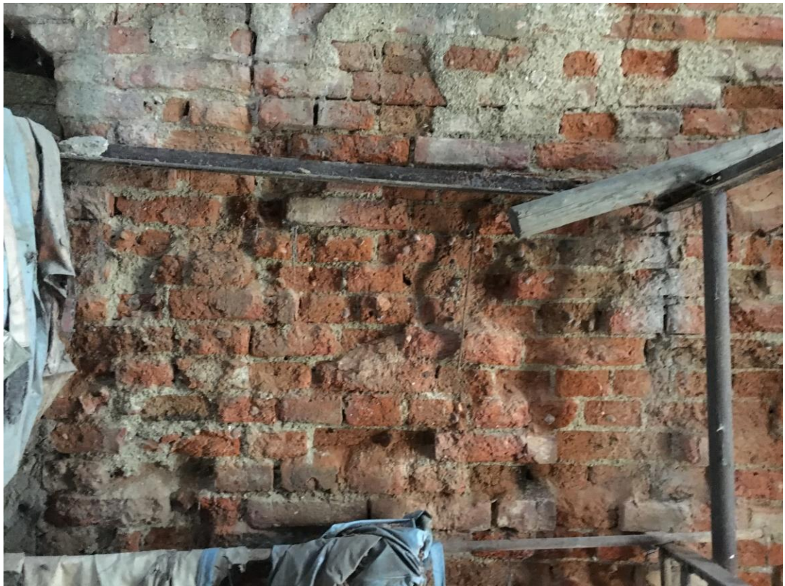
Fot. 9 degradacja cegieł ciany szczytowej północnej od strony komórki
