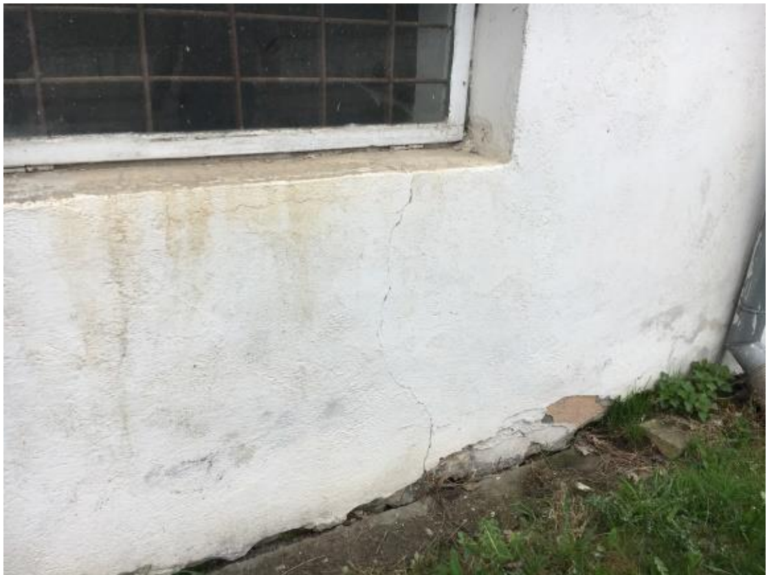
Fot. 5 zarysowanie ściany pod oknem nr 1
