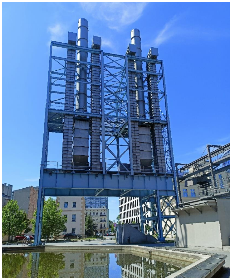
c) Konstrukcje odpylania 201 i 202 umiejscowione w zachodniej części kompleksu
