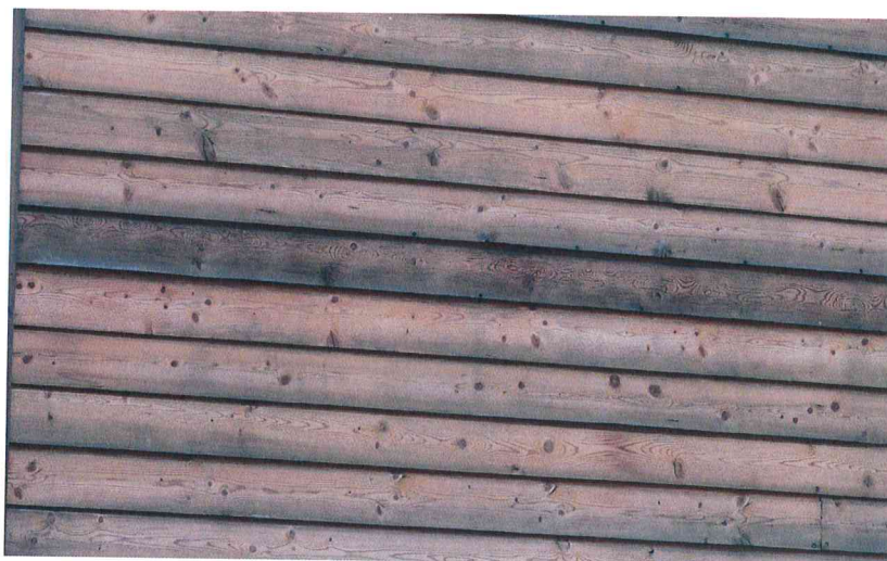
Fot. nr12. Fragment powierzchni elewacji – intensywnie wybarwione deski elewacji w miejscach przylegania (tylną powierzchnią) do warstwy izolacji cieplnej, potencjalne miejsce wystąpienia korozji biologicznej.
