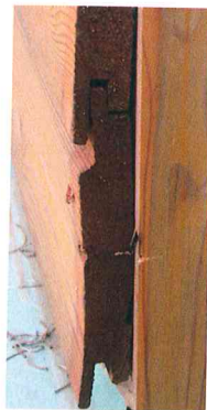
Fot. nr 3 i nr 4 Układy włókien w deskach: odrdzeniowa i dordzeniowa – oraz konsekwencje
