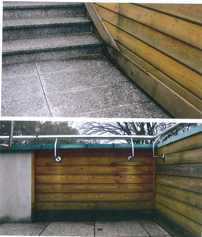
Fot. nr14 i nr 15 Fragmenty powierzchni elewacji na tarasie widokowym i wzdłuż wejścia na taras z intensywnie przebarwionymi deskami w dolnych partiach elewacji (potencjalne miejsce wystąpienia korozji biologicznej)
