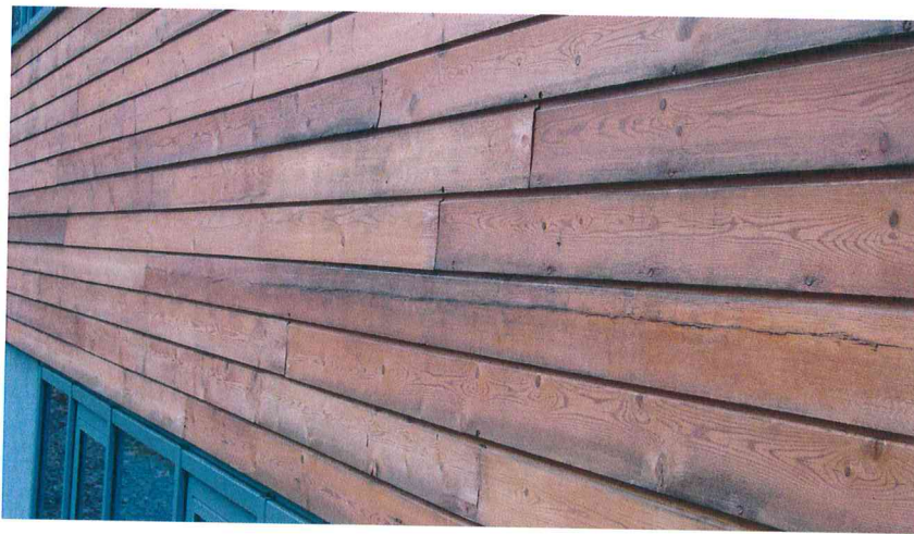
Fot. nr 6 Pęknięcie wzdłuż rdzenia otwartego – miejsca odsłonięte szczególnie podatne na wybarwienie, wypłukiwanie impregnatu i korozję biologiczną
