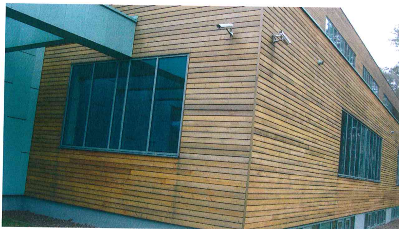
Fot. nr 16 Wybarwienia i zabarwienia powierzchni elewacji pod kamerami i stolarką otworową
