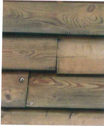
Fot. nr 10 Fragment powierzchni elewacji – zbliżenie, uskoki i nierówności na styku wraz z przykładem naprawy połączenia
