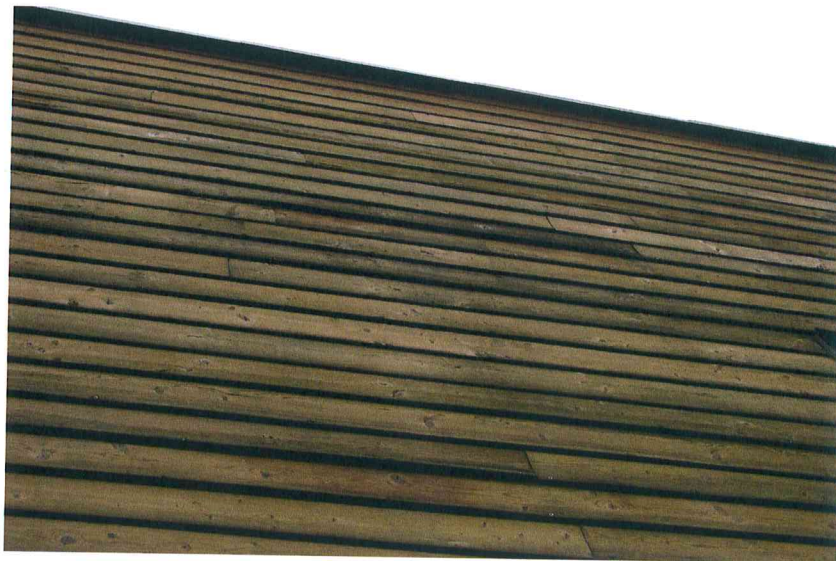
Fot. nr 11 Fragment powierzchni elewacji – powierzchnia elewacji silnie pofalowana z deskami intensywnie przebarwionymi
