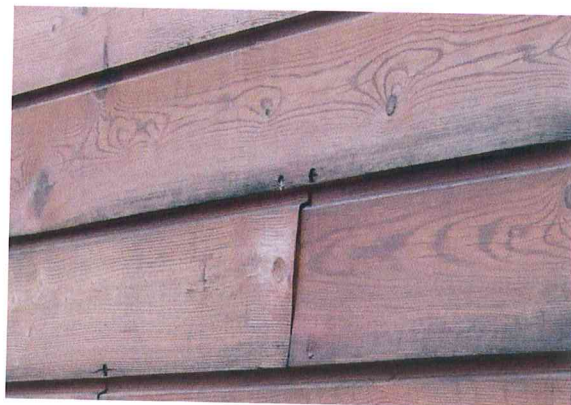
Fot. nr 5 Odształcenie, spowodowane układem włókien w przekrojach stykających się desek (deski do i odrdzeniowa –wygięte w przeciwnych kierunkach)
