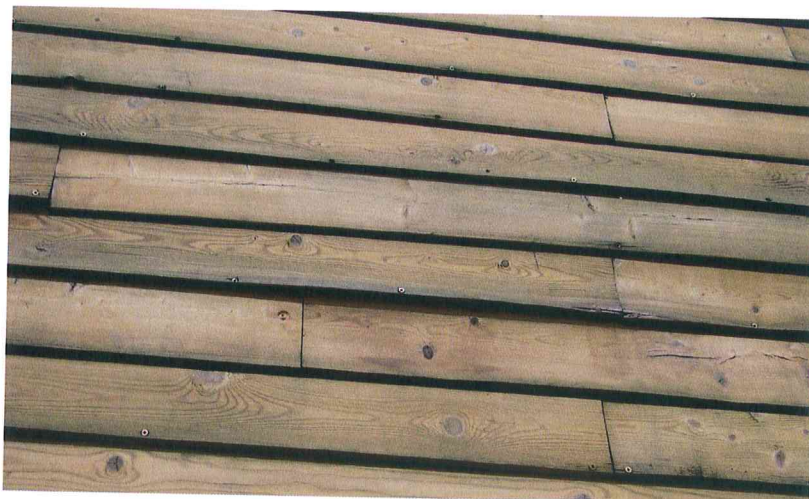
Fot. nr 7 Pęknięcia od czoł desek – miejsca odsłonięte podatne na wybarwienia, wypłukiwanie impregnatu i korozję biologiczną
