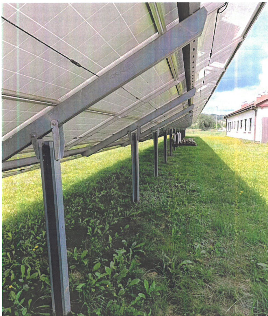
Zdjęcie nr 1- przykładowy montaż konstrukcji naziemnej
