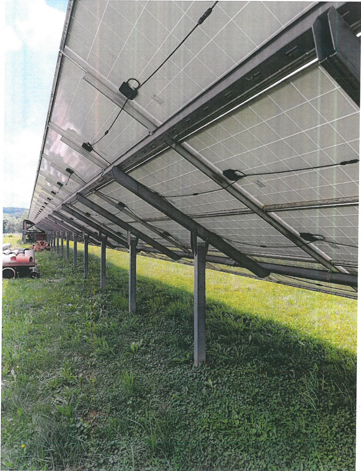
Zdjęcie nr 2- przykładowy montaż konstrukcji naziemnej
