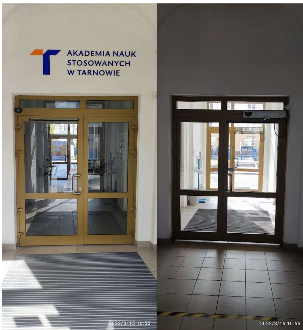
Rysunek 3. Element numer 2 (drzwi nr 2) wewnętrzne w budynku A.
