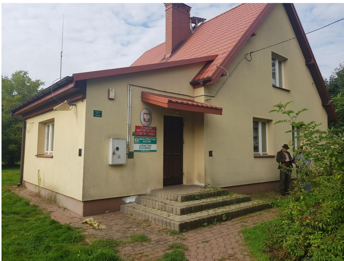
Zdjęcie 1 – Elewacja budynku leśniczówki.
