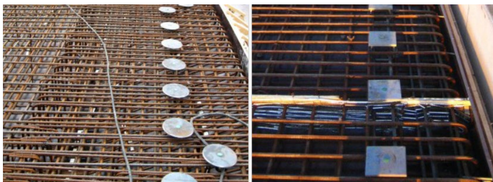
Rys. 7. Mocowanie dolnych części kotew do zbrojenia
