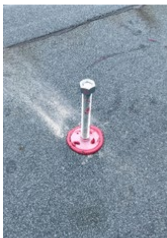
Rys. 13. Zamontowana kotew z elementem uszczelniającym
