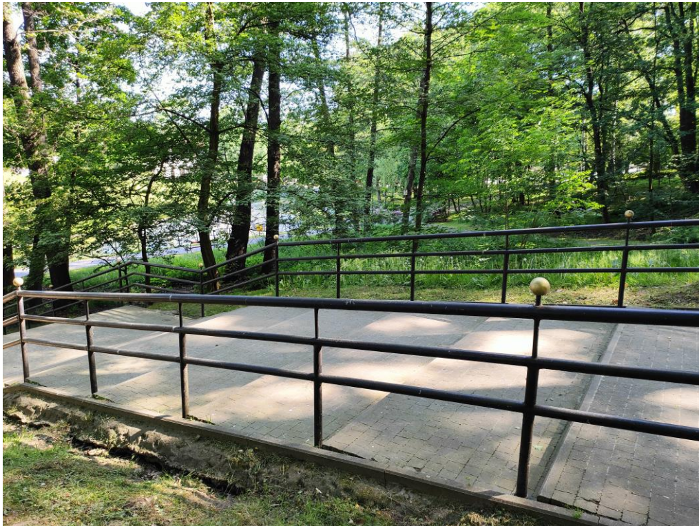
Fot. 7 Stalowa balustrada w Parku Planty [fot. własna]
