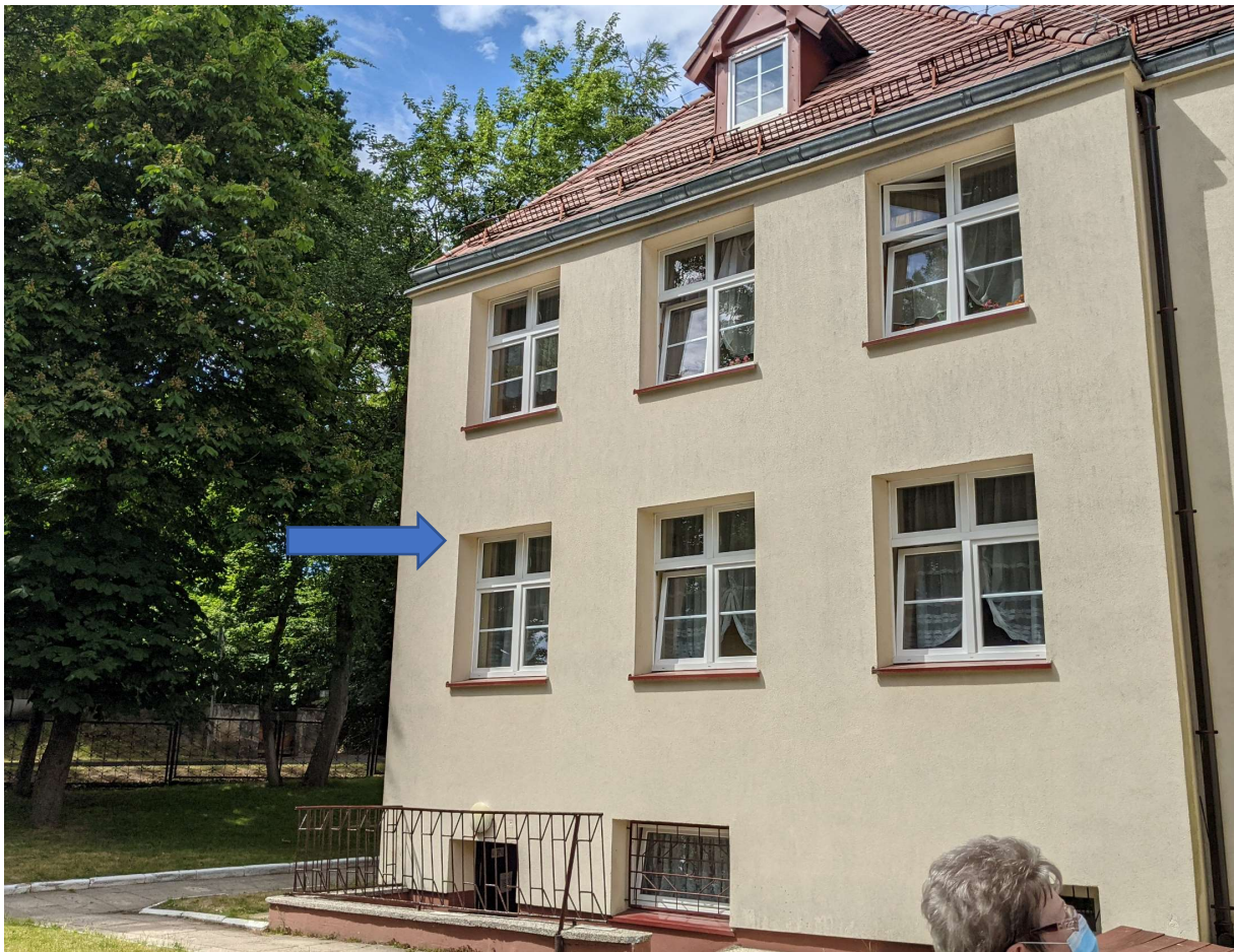
Rysunek 50: Miejsce instalacji na elewacji budynku
