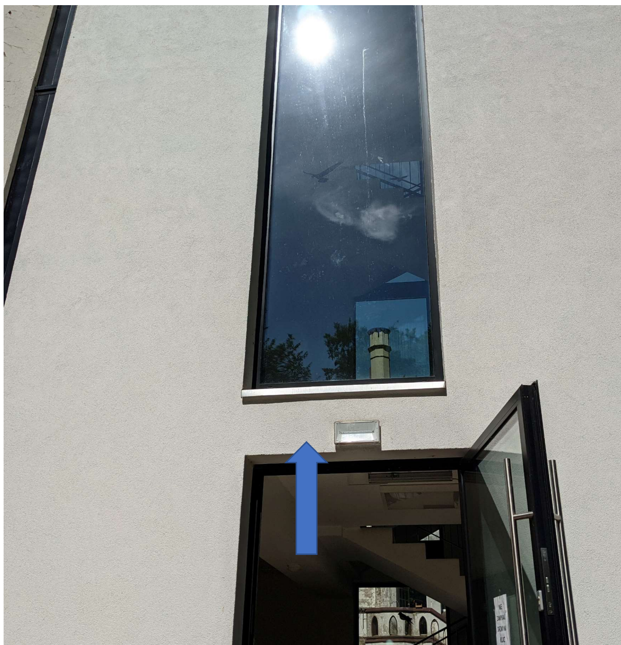
Rysunek 52: Urządzenie powinno zostać umieszczone obok lampy ewakuacyjnej, okablowanie do PD na niskim parterze.
