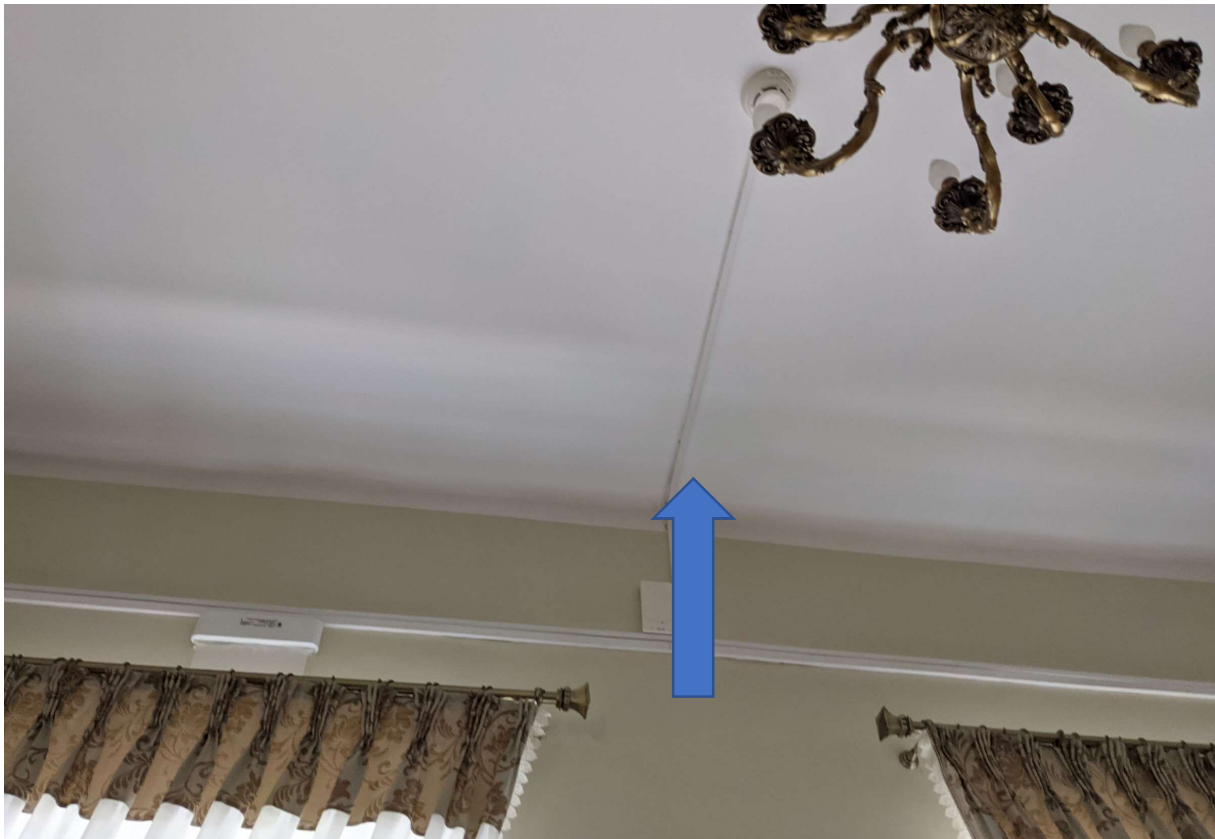
Rysunek 45: Wybrane miejsce instalacji access pointa w czytelnym jak najbliższej ścianie obok listwy
