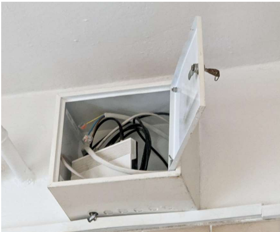
Rysunek 11: Szafa w kuchni, która jest zakończeniem radiolinii
