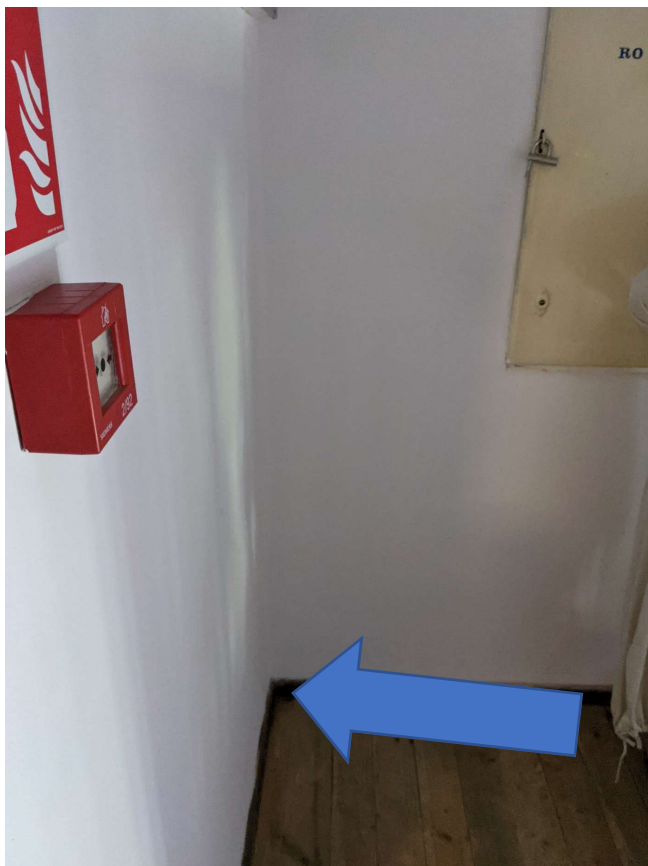
Rysunek 40: Miejsce przebicia stropu
