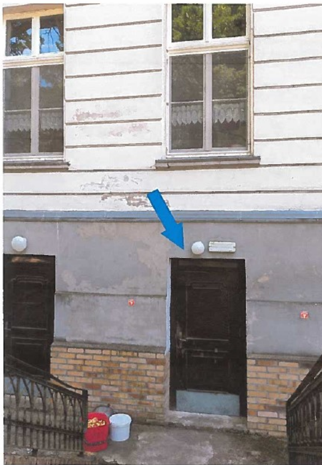
Część boczna pałacu
