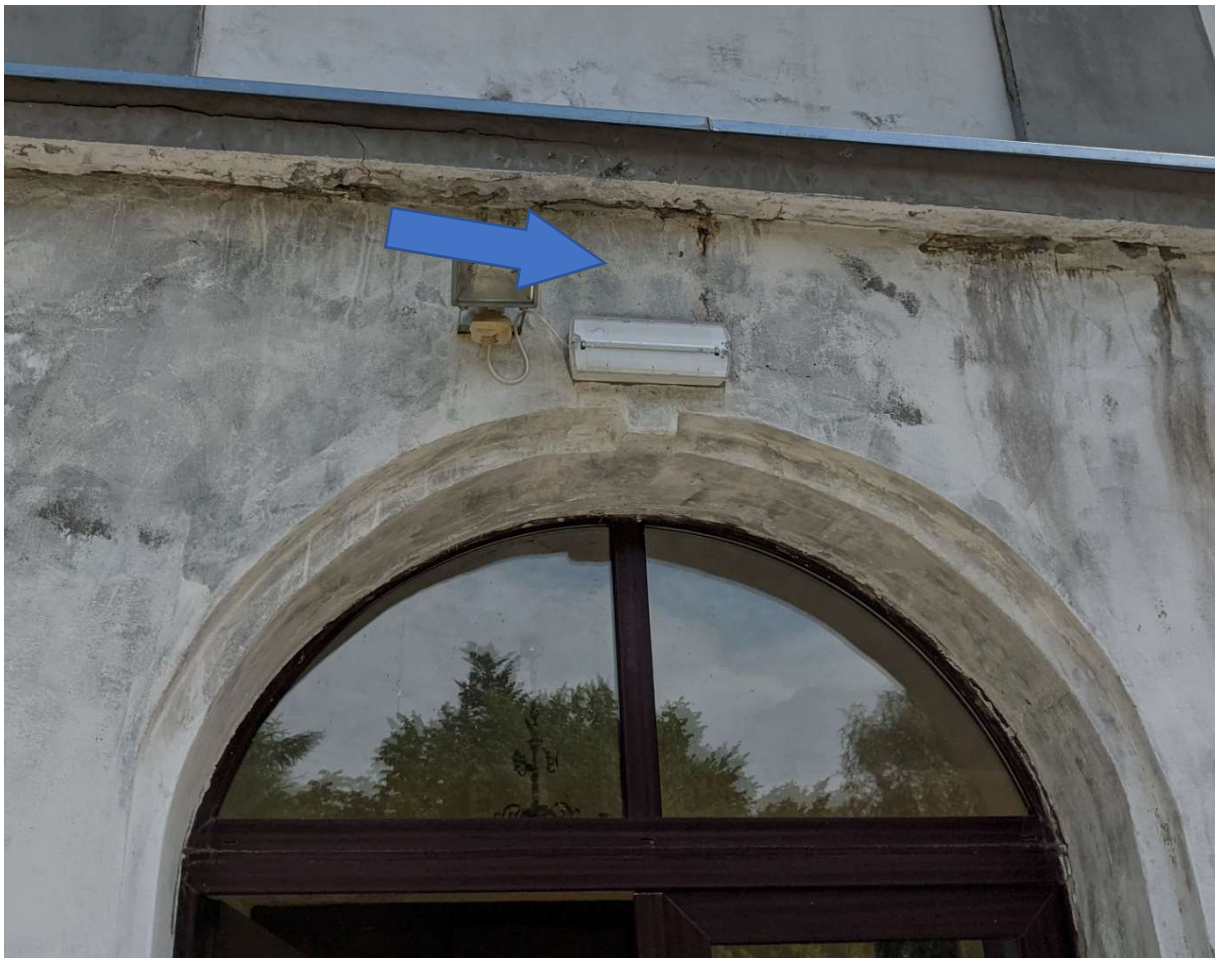
Rysunek 62: Access point możliwy do instalacji nad lampą ewakuacyjną, zlicowany do elewacji, okablowanie do PD na parterze
