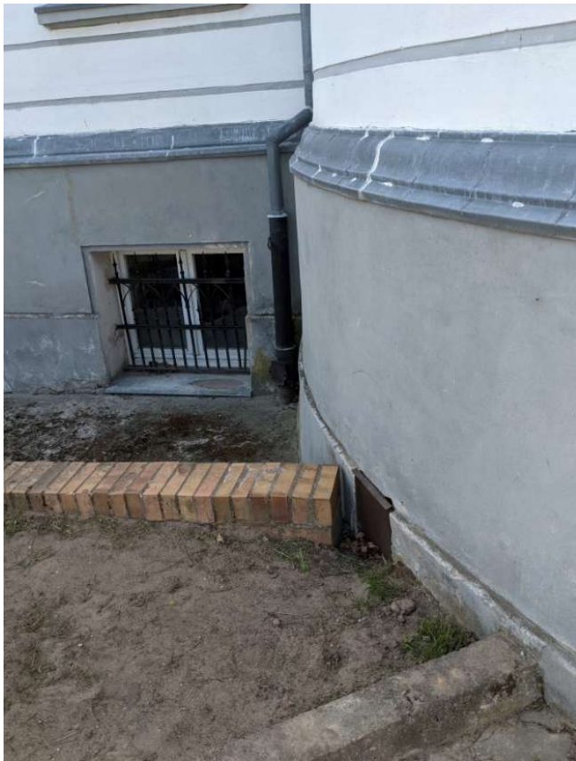
Rysunek 10: Miejsce wejścia przepustu do części pałacowej
