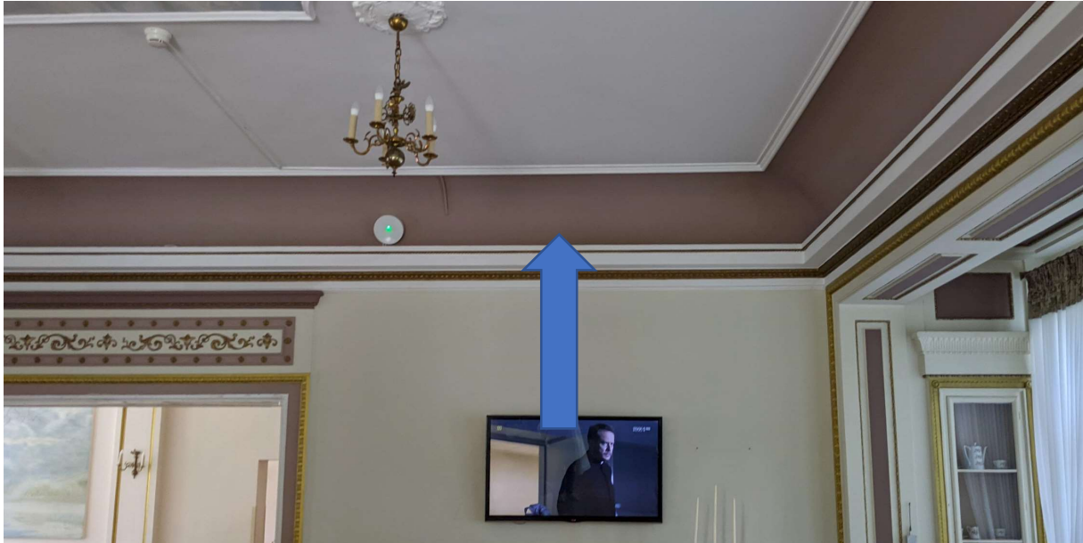
Rysunek 47: Gzyms na jakim musi zostać położone okablowanie
