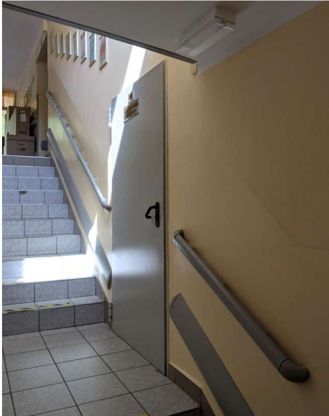
Rysunek 25: Miejsce pod nową główną serwerownią zostało zaproponowane przez pracowników administracyjnych DPS Żydowo. Jest to pomieszczenie odizolowane, przy ścianie szczytowej, gdyby zaszła potrzeba podłączenie klimatyzacji.
