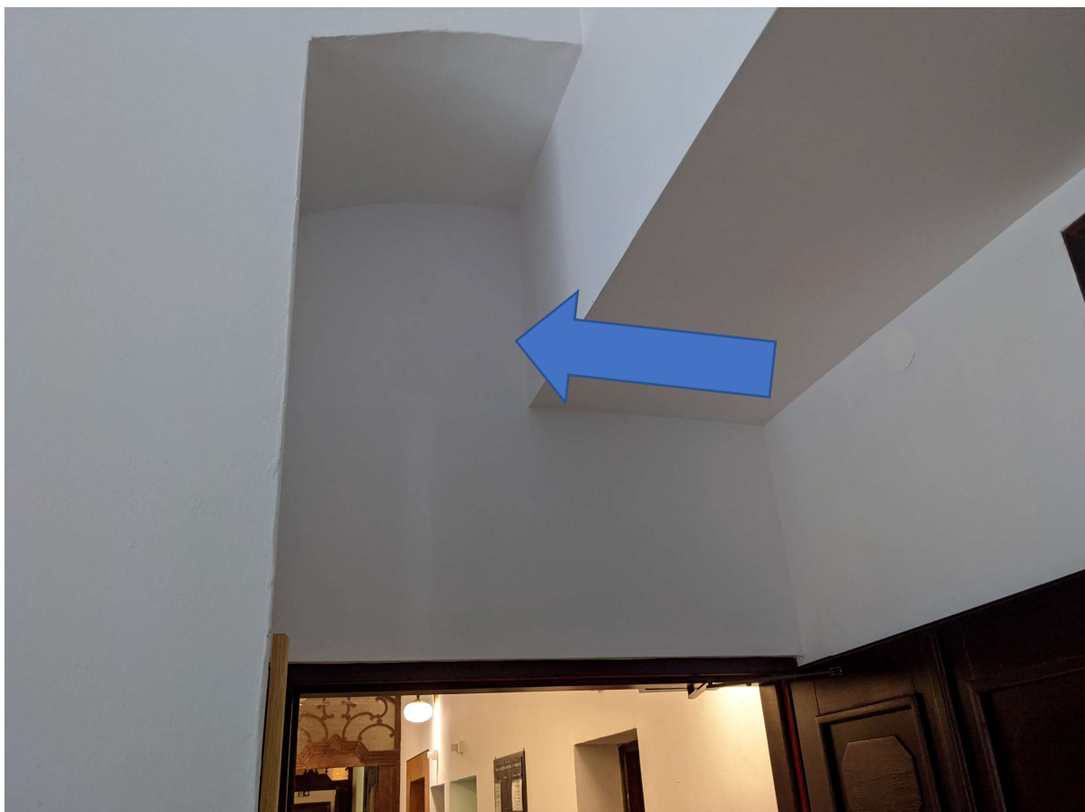
Rysunek 34: Miejsce instalacji szafy PD5
