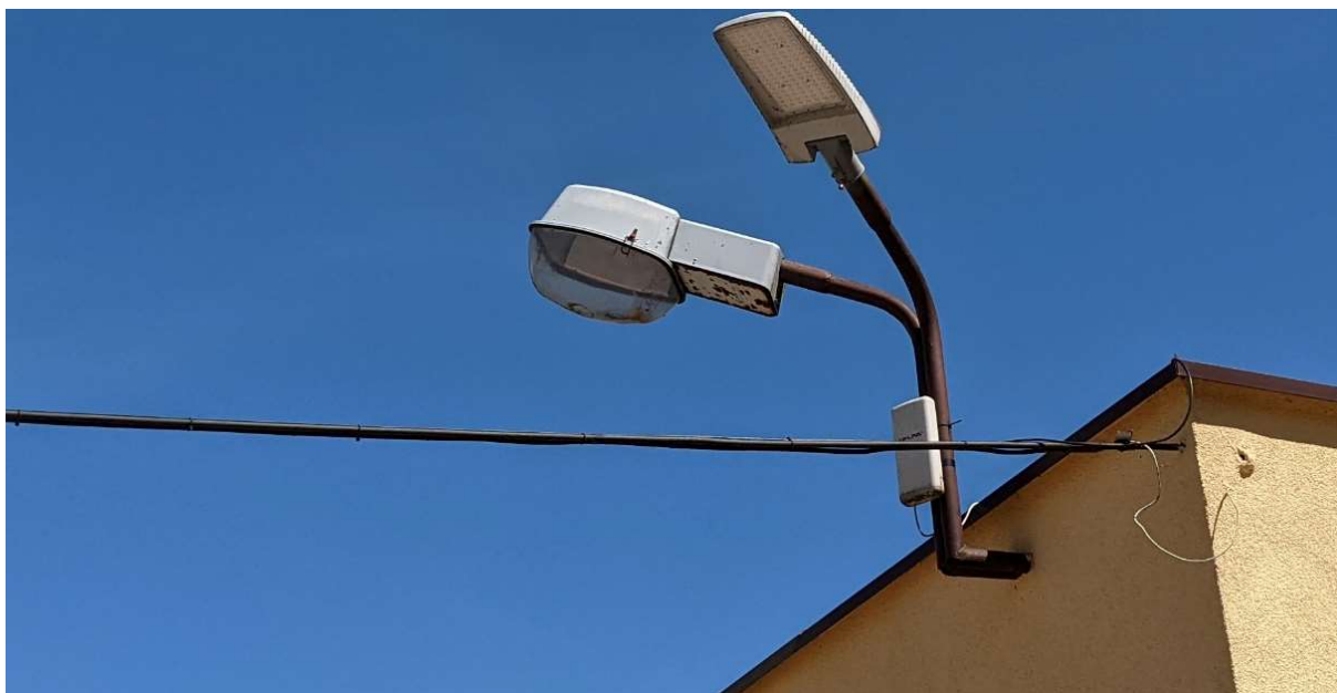
Rysunek 8: Radiolinia łącząca budynek główny z pomieszczeniem strażników na wjeździe
