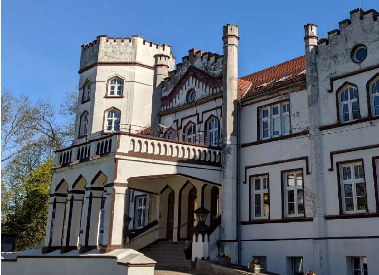
Rysunek 9: Miejsce instalacji anteny satelitarnej na tarasie na pierwszym piętrze
