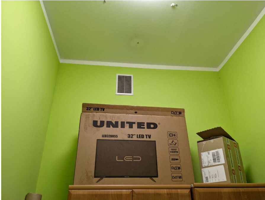
Rysunek 23: Miejsce instalacji szafy GDP
