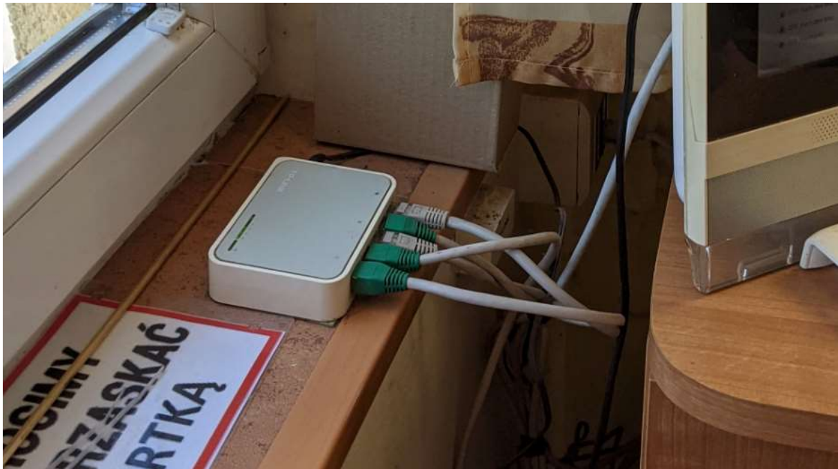
Rysunek 12: Małe niezarządzone switchy w części biurowej
