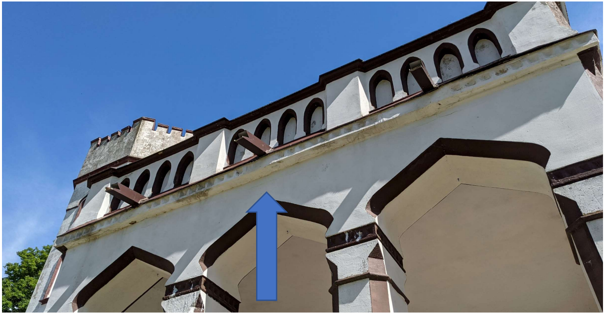
Rysunek 53: Miejsce instalacji access pointa
