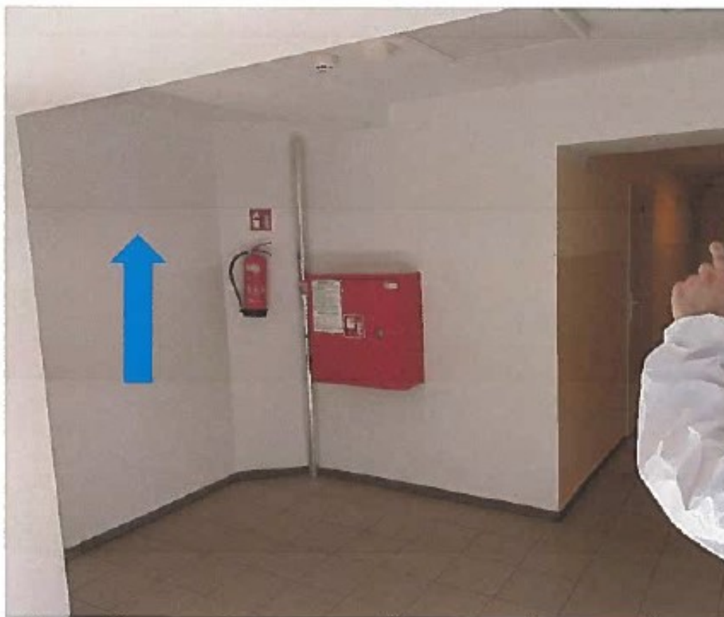
Przykładowe miejsce instalacji nowej szafy na niskim parterze.
