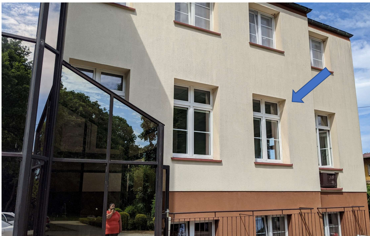
Rysunek 51: Miejsce instalacji na elewacji budynku
