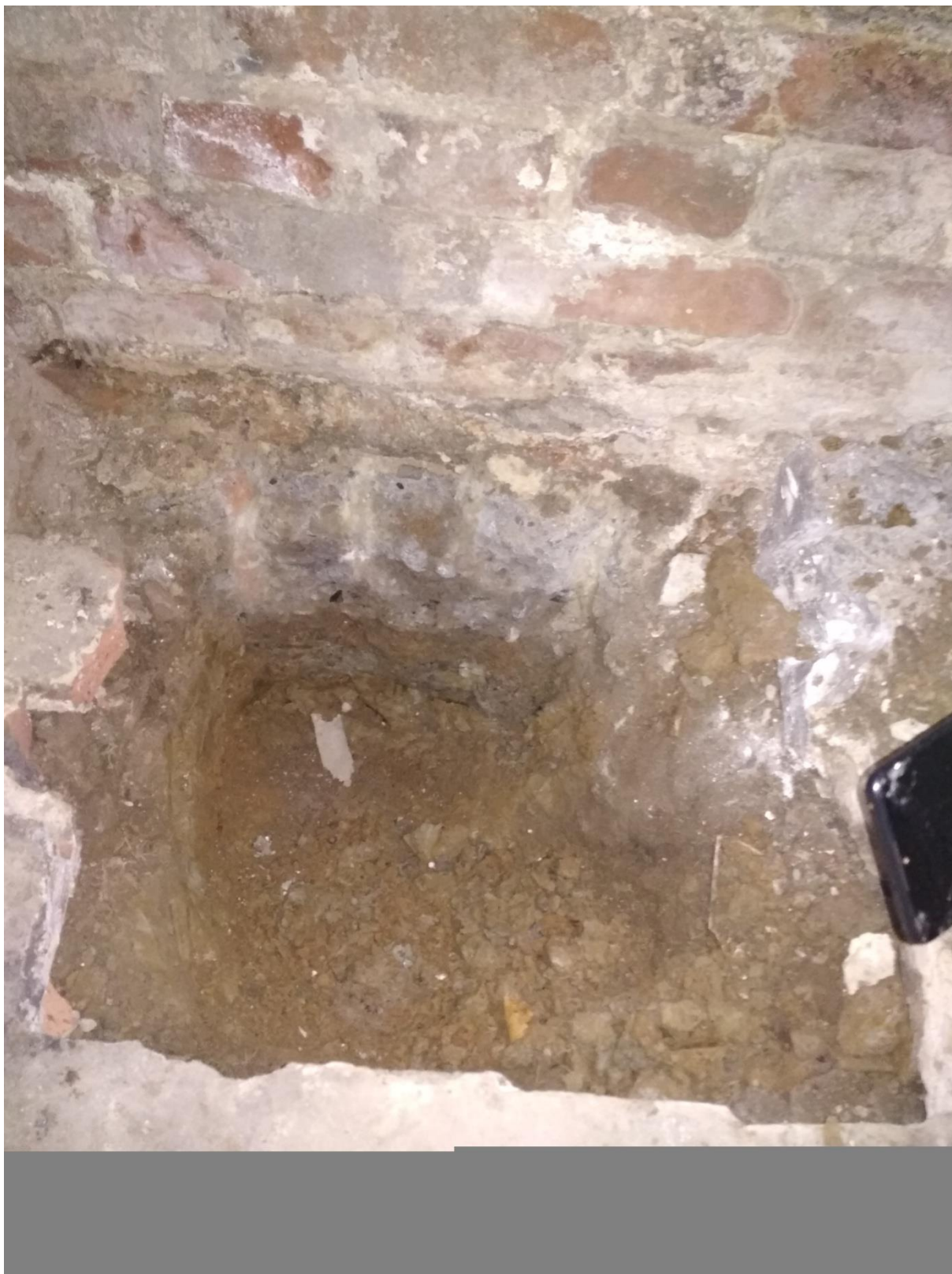
Fot. 1 - odkrywka fundamentów w pom. -1.14 (zgodnie z opisem pomieszczeń wg inwentaryzacji)
