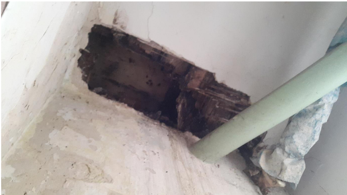
Fot. 6 – Widok zbutwiałego stropu drewnianego nad piętrem
