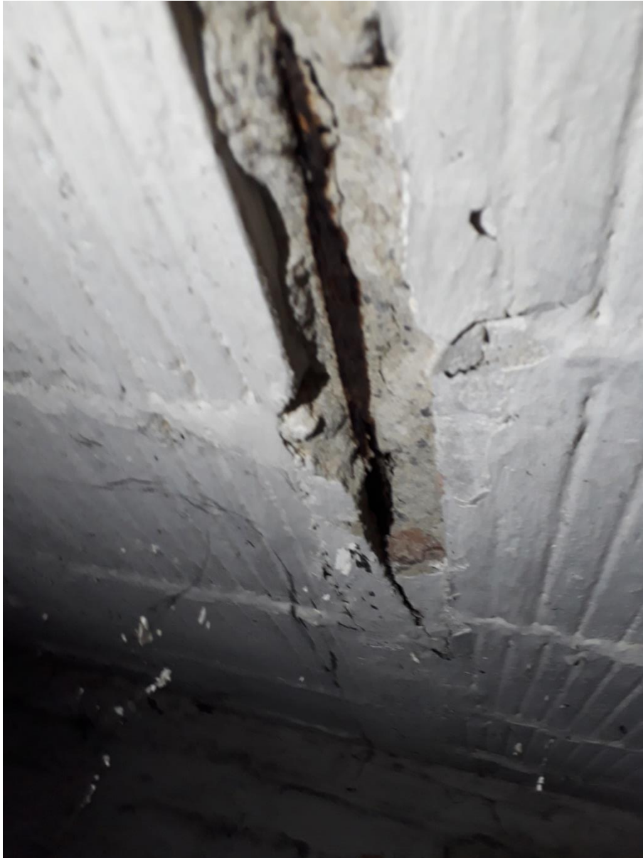
Fot. 10 – Widok skorodowanego zbrojenia stropu gęstożebrowego nad piwnicą
