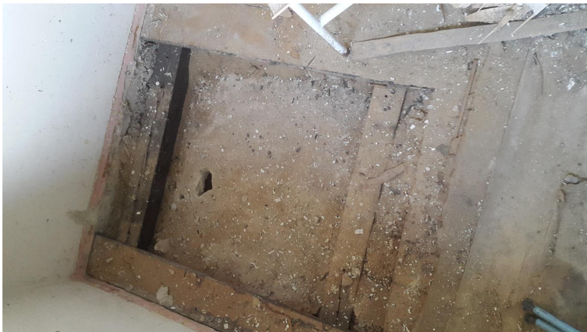
Fot. 13 – Widok odkrywki stropu nad parterem (pomieszczenie na piętrze nad archiwum)
