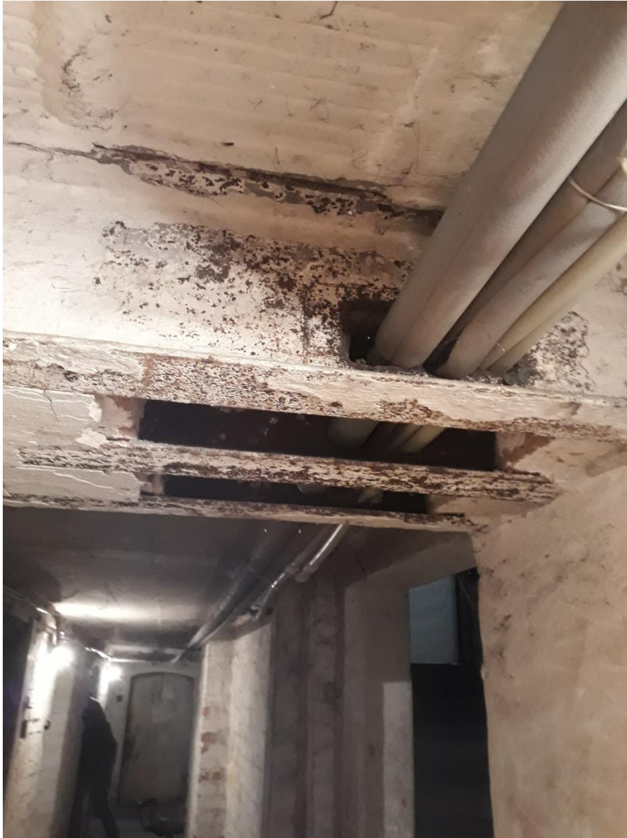
Fot. 12 – Widok nadproży stalowych w piwnicy
