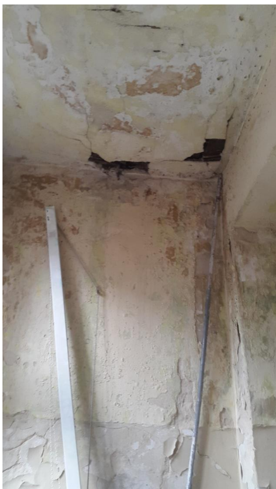
Fot. 5 – Odparzony tynk na ścianach piętra i ubytki w stropie drewnianym nad piętrem Stropy.
