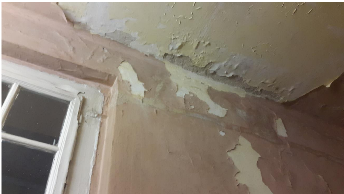
Fot. 4 – Odparzony tynk na ścianach piętra
