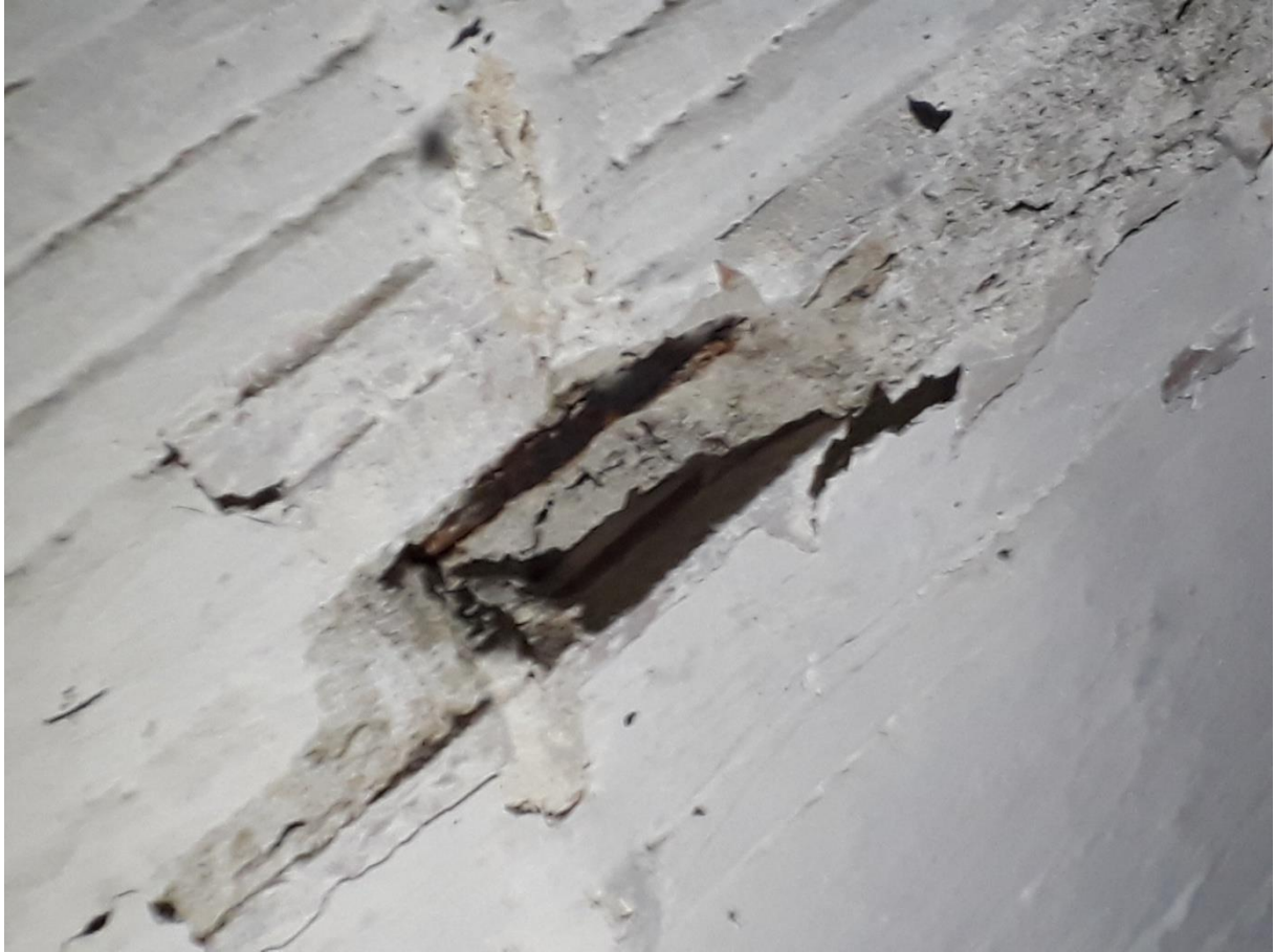
Fot. 9 – Widok skorodowanego zbrojenia stropu gęstożebrowego nad piwnicą
