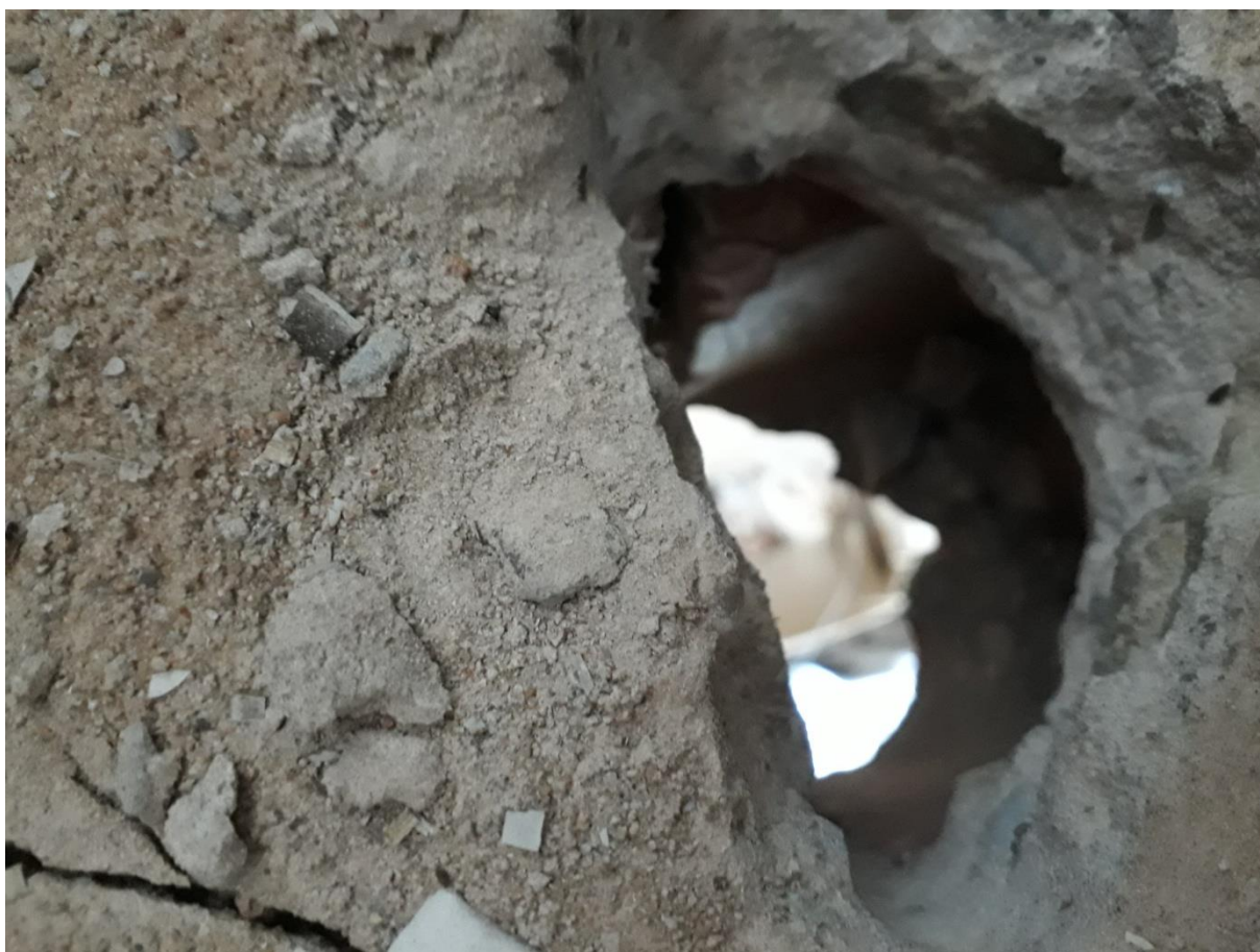
Fot. 14 – Widok przewiertu odkrywki stropu nad parterem (pomieszczenie na piętrze nad archiwum)
