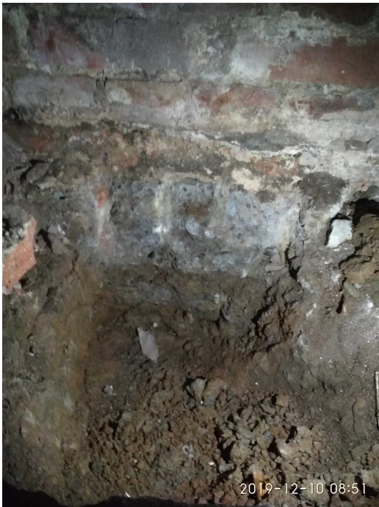
Fot. 2 – odkrywka fundamentów w pom. -1.14 (zgodnie z opisem pomieszczeń wg inwentaryzacji)
