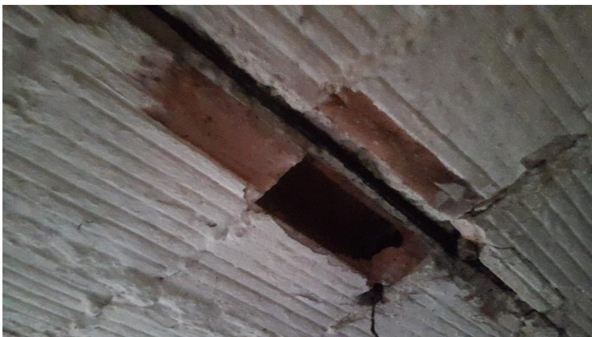
Fot. 8 – Widok pustaka stropu gęstożebrowego nad piwnicą
