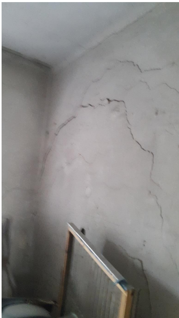
Fot. 3 – Pęknięta ściana na poddaszu
