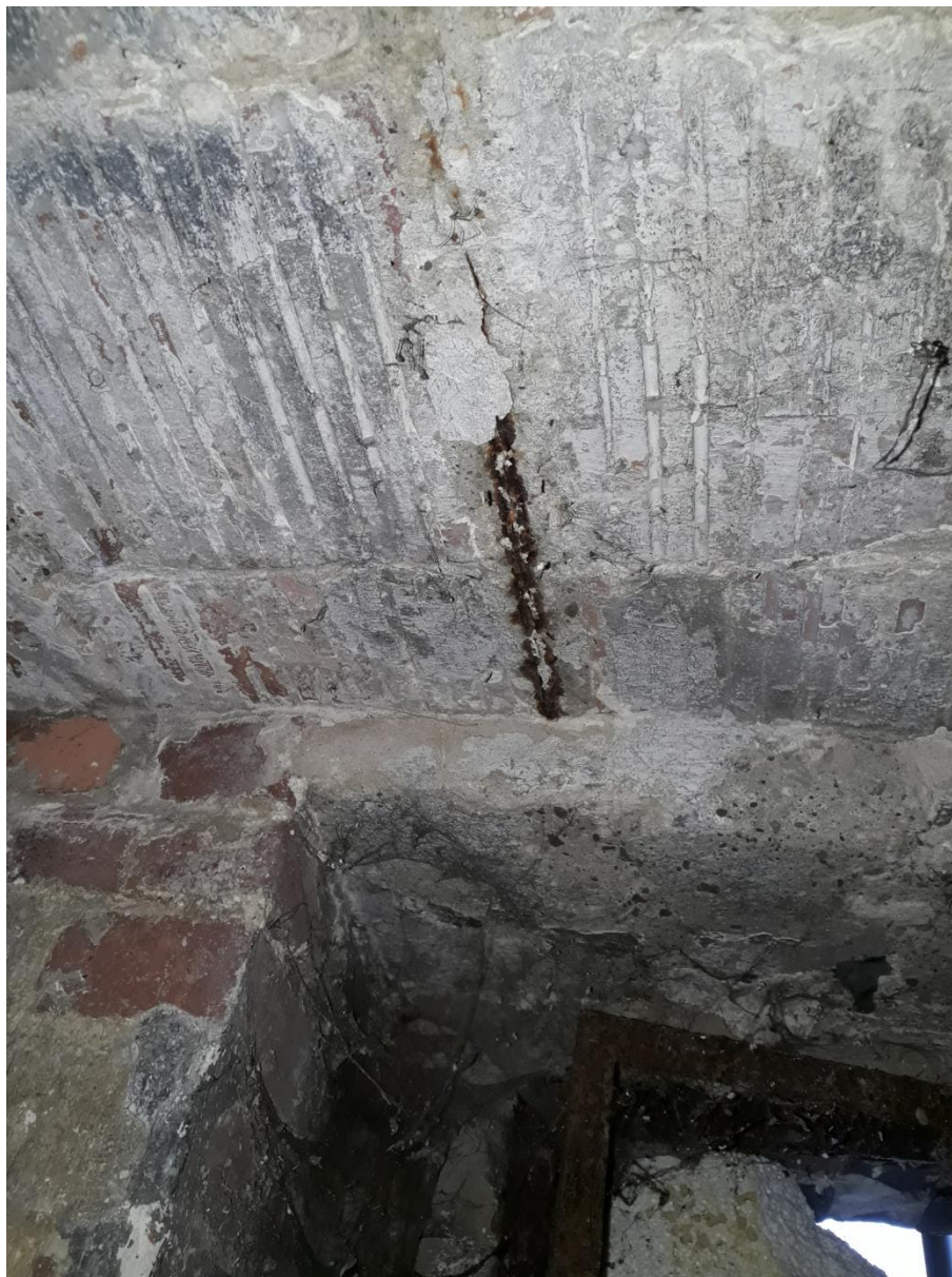
Fot. 11 – Widok skorodowanego zbrojenia stropu gęstożebrowego nad piwnicą
