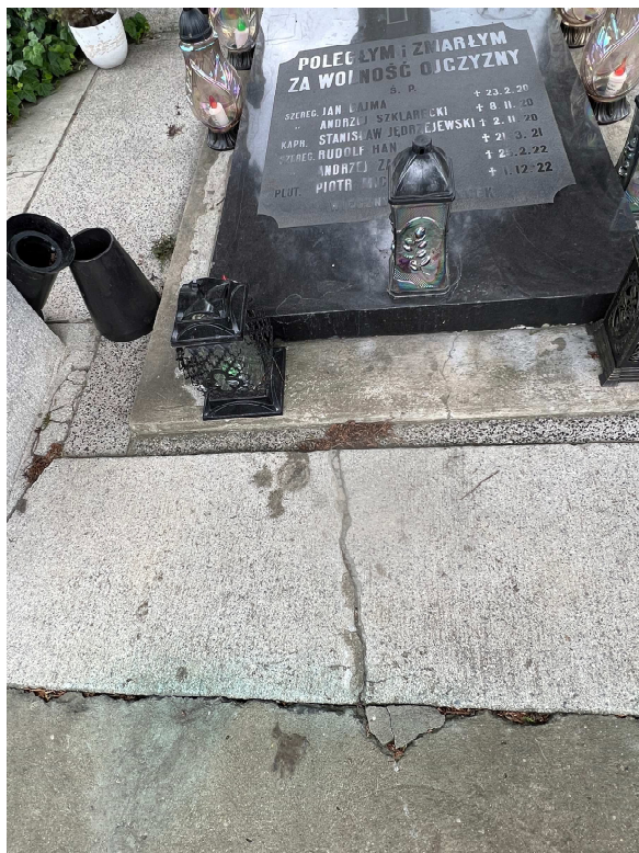
Fot. nr 3. Pęknięcia płyty betonowej
