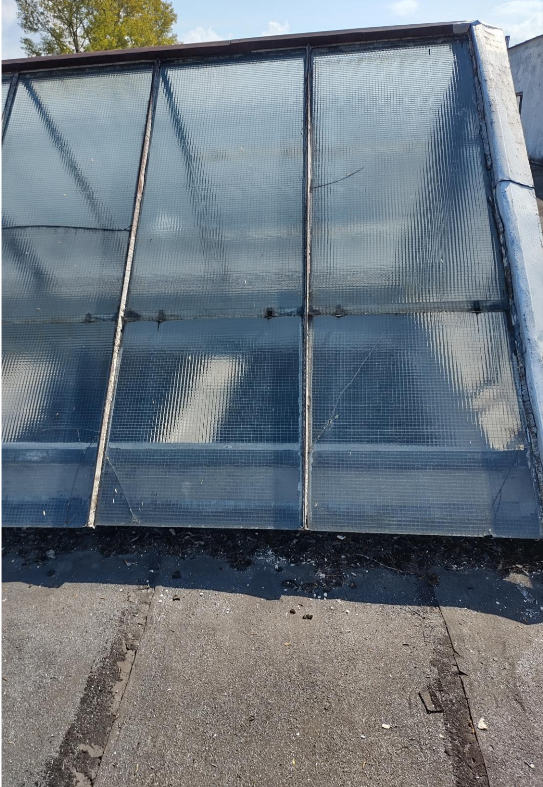
NAŚWIETLA DO ROZBIÓRKI
